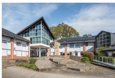
Vue d'ensemble prise du sud du hall-entrée et des façades adjacentes (Patrick Pincemaille et Ruelland-Perche-Héraud, architectes, 1986), précédés de l'espace sculpté de Michel Politzer.
