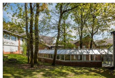
Vue d'ensemble de la cour ouest, de la façade ouest de la galerie couverte et de l'aile bleue (à l'arrière plan).
