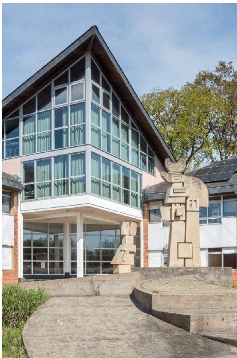
Elévation du hall-entrée et CDI, prise du sud-est. Patrick Pincemaille et Ruelland-Perche-Héraud, architectes, 1986. Noter deux des trois "totems" de l'espace sculpté de Michel Politzer.
