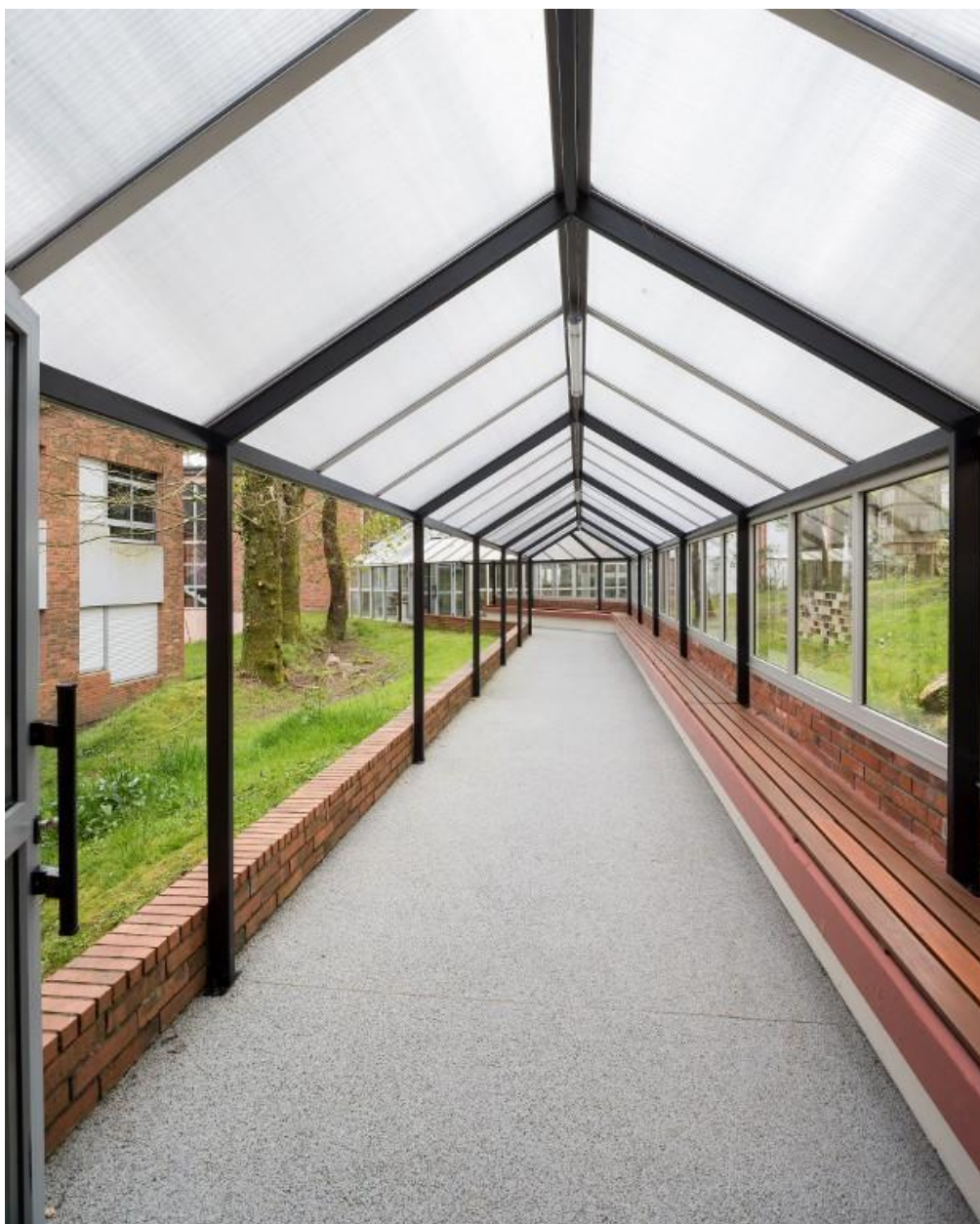
Galerie couverte permettant de rejoindre l'aile blanche (extension).
