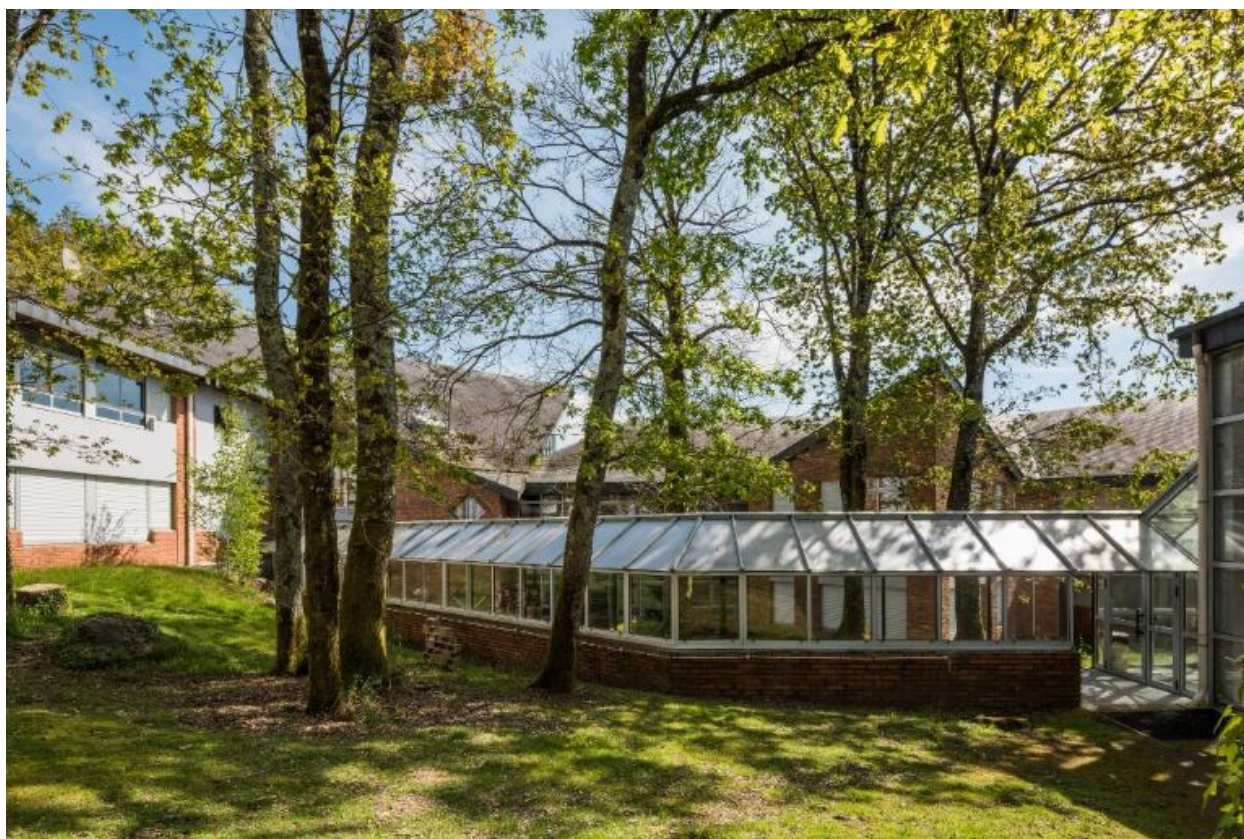
Vue d'ensemble de la cour ouest, de la façade ouest de la galerie couverte et de l'aile bleue (à l'arrière plan). Patrick Pincemaille et Ruelland-Perche-Héraud, architectes, 1986.
