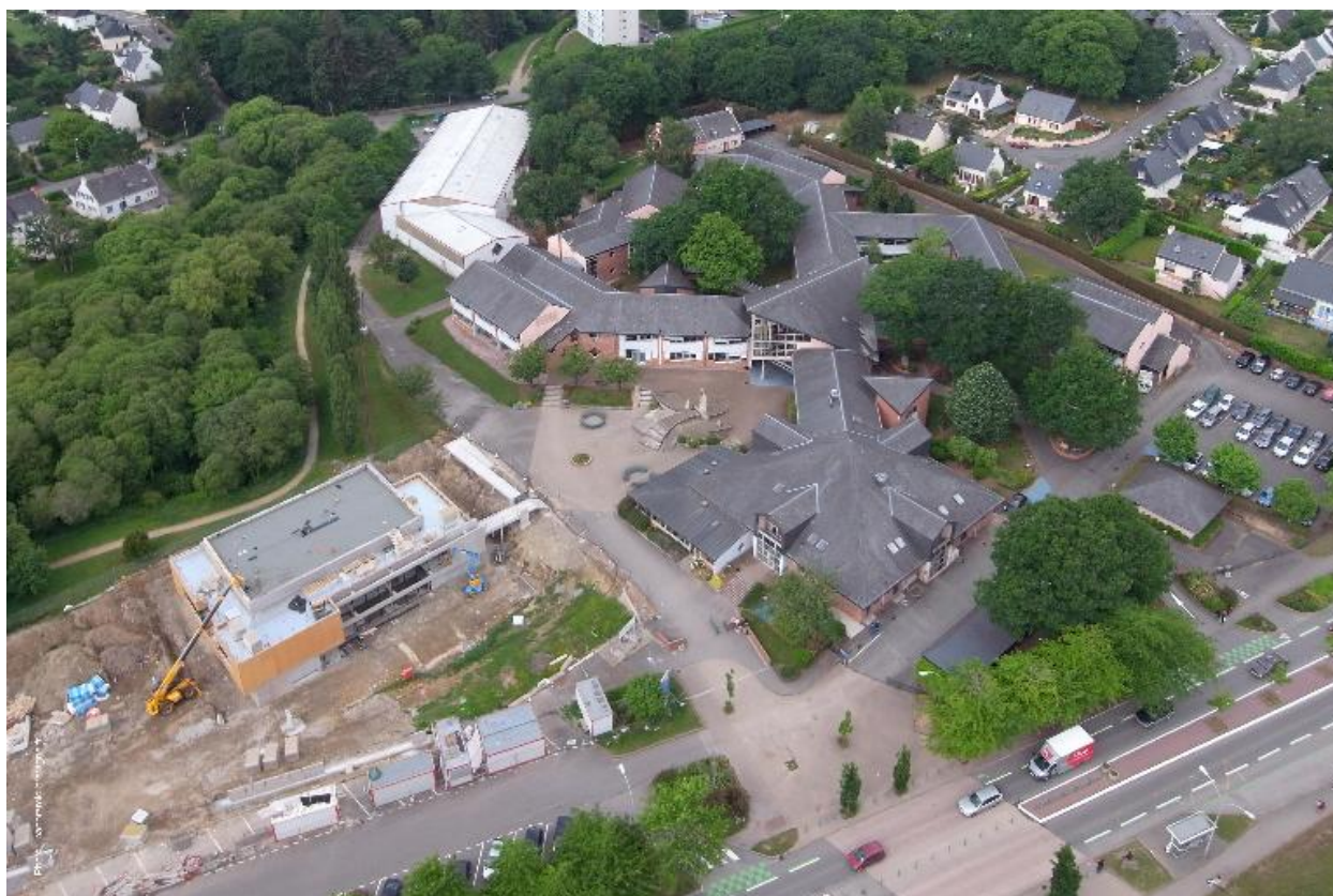
Vue aérienne oblique, 2010.
