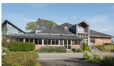
Vue d'ensemble des façade sud-est de l'aile jaune : restauration et externat. Patrick Pincemaille et Ruelland- Perche-Héraud, architectes, 1986. Phot. Barraud Charlotte IVR53_20245600285NUCA
