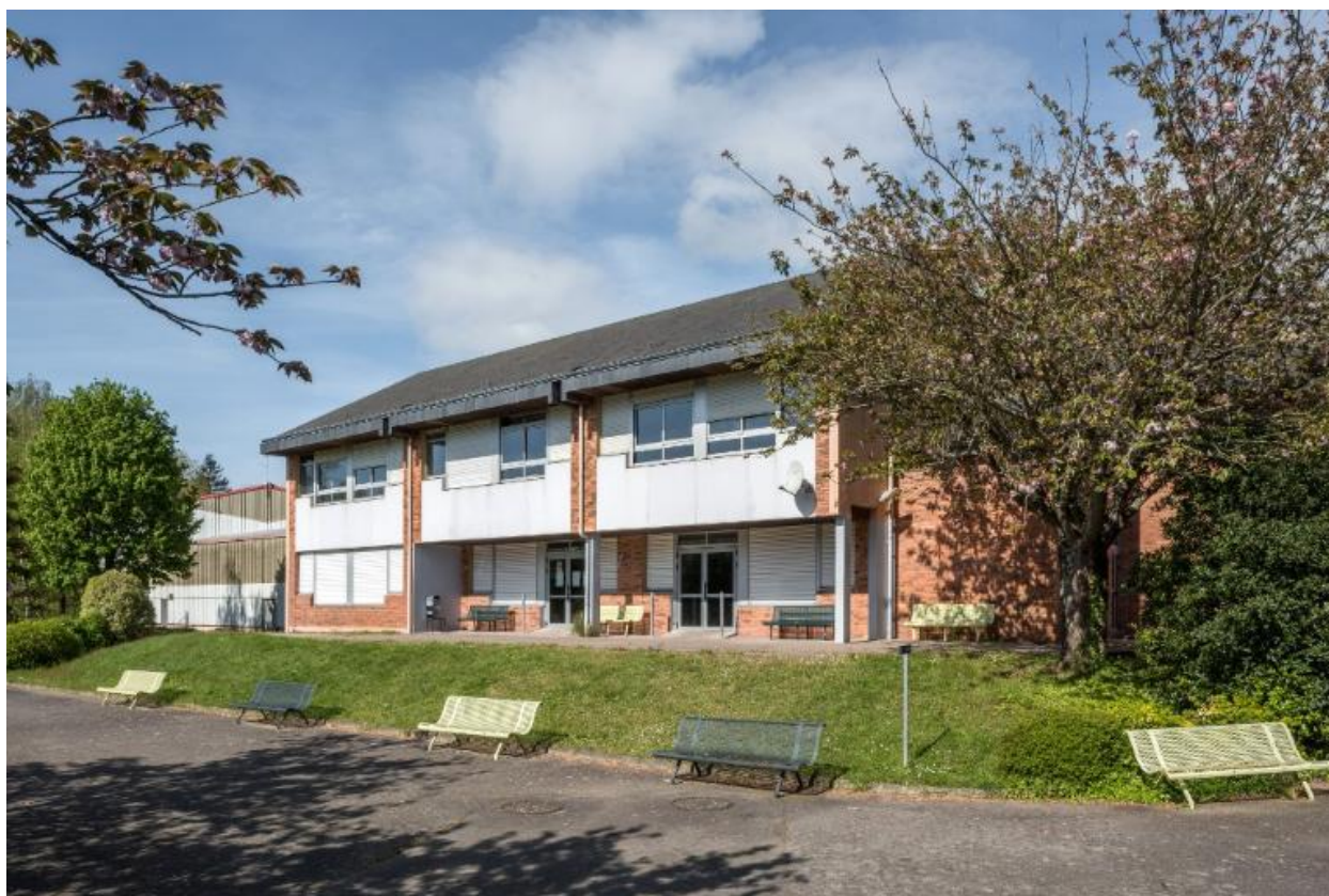
Façade sud-est de l'aile bleue (externat). Patrick Pincemaille et Ruelland-Perche-Héraud, architectes, 1986.
