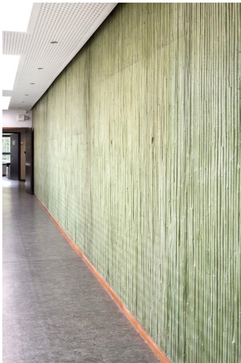
Vue intérieure de "l'amphithéâtre" : détail sur un mur en béton dont la surface est moulée dans des tiges de bambou. Agence LBL (L'Hyver-Brechet-Lohé), 2010.
