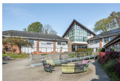
Vue d'ensemble de l'entrée prise du sud-est. Patrick Pincemaille et Ruelland-Perche- Héraud, architectes, 1986. Phot. Barraud Charlotte IVR53_20245600283NUCA
