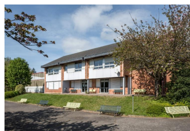
Façade sud-est de l'aile bleue (externat). Patrick Pincemaille et Ruelland-Perche-Héraud, architectes, 1986.
