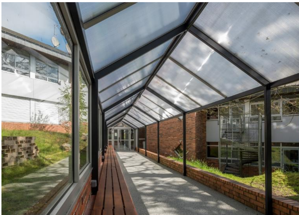
Galerie couverte entre le hall-entrée et l'aile blanche (externat sciences).
