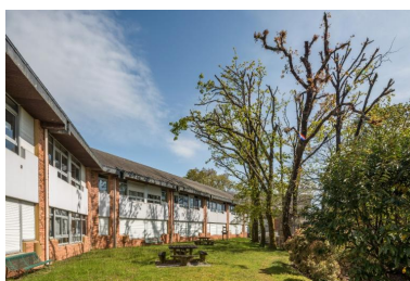
La cour ouest et les façades sud-est et sud de l'aile verte (externat sciences).
