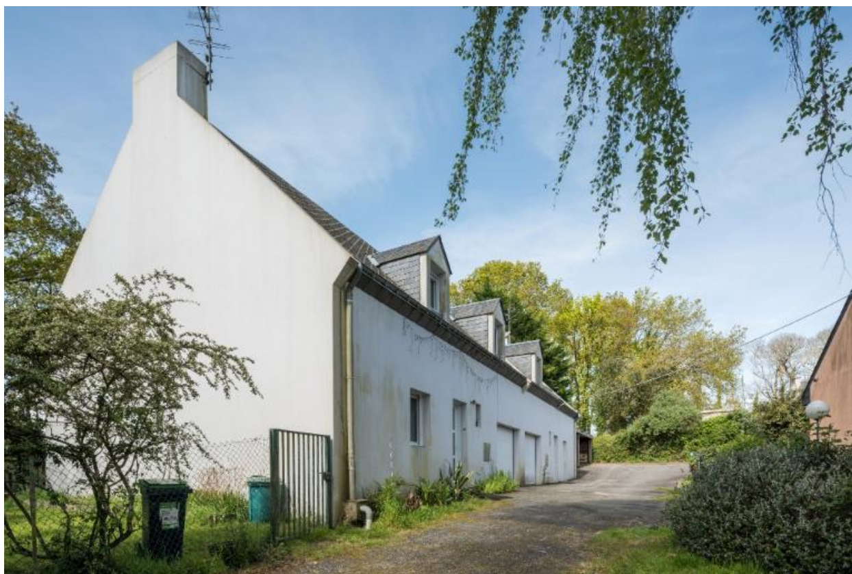
Façades nord-est des logements.
