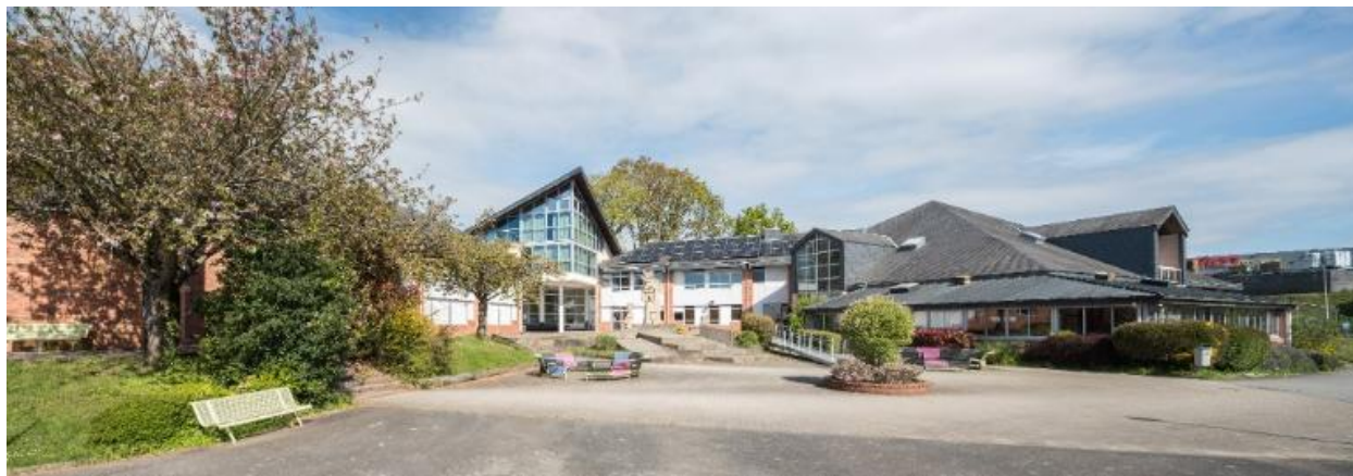
Vue d'ensemble prise du sud. Patrick Pincemaille et Ruelland-Perche-Héraud, architectes, 1986.
