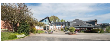
Vue d'ensemble prise du sud. Patrick Pincemaille et Ruelland- Perche-Héraud, architectes, 1986. Phot. Barraud Charlotte IVR53_20245600290NUCA
