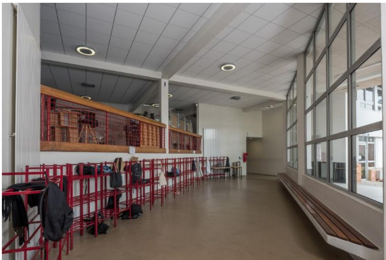
Hall - entrée : vue intérieure, noter la mezzanine en demi-niveau qui compense l'inclinaison du terrain. Patrick Pincemaille et Ruelland-Perche-Héraud, architectes, 1986.
