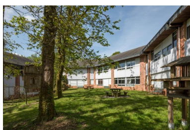
Les façades de l'aile verte (externat sciences) prise depuis la cour ouest.
