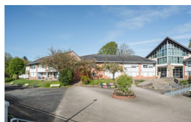
Vue d'ensemble partielle prise de l'est : aile bleue (externat) et hall-entrée. Patrick Pincemaille et Ruelland-Perche- Héraud, architectes, 1986. Phot. Barraud Charlotte IVR53_20245600287NUCA
