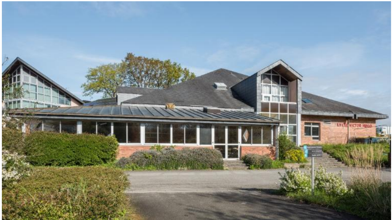
Vue d'ensemble des façade sud-est de l'aile jaune : restauration et externat. Patrick Pincemaille et Ruelland-Perche-Héraud, architectes, 1986.
