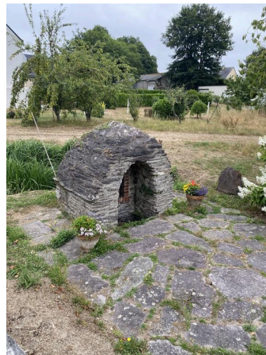
Vue nord-ouest Phot. Baptiste Oligo IVR53_20255610965NUCA
