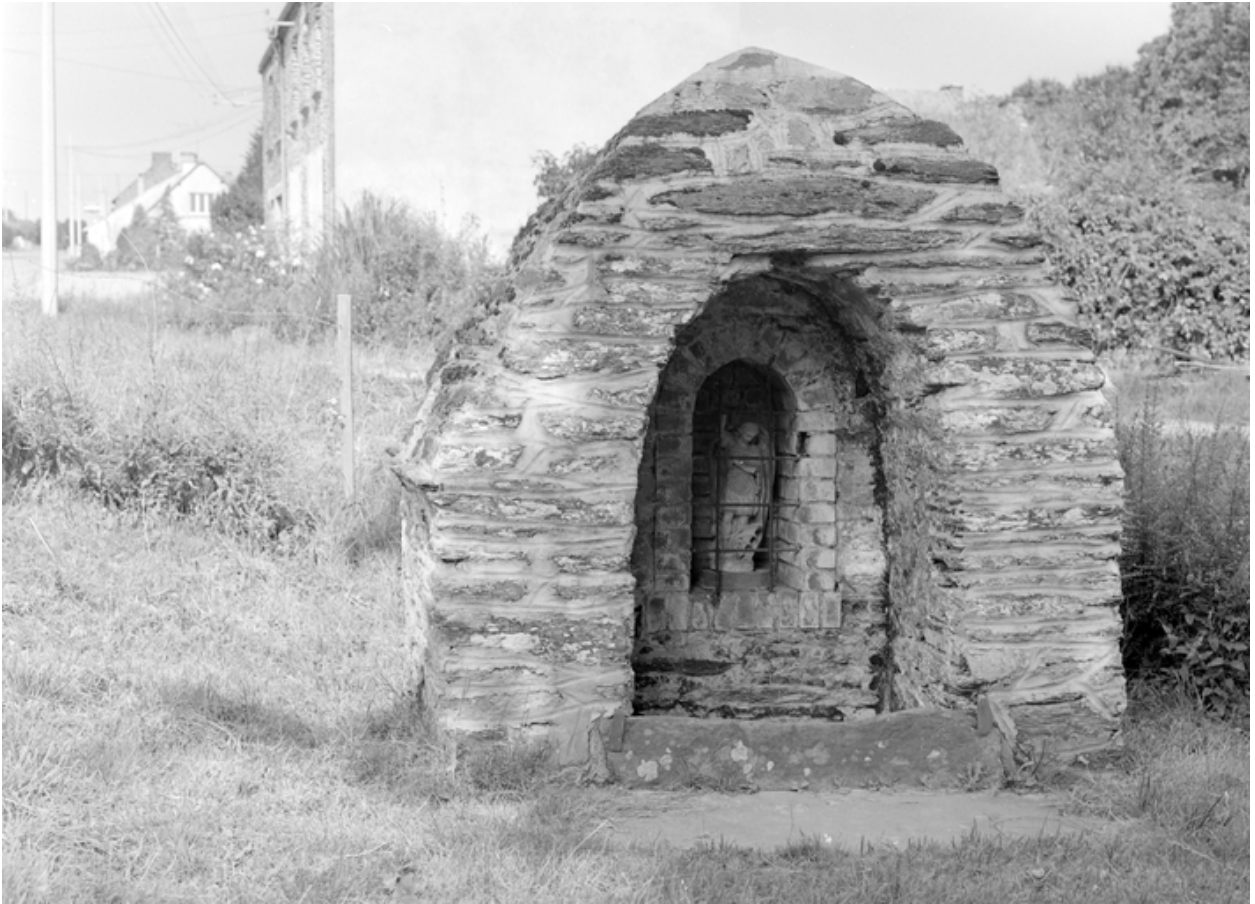
Vue générale ouest
