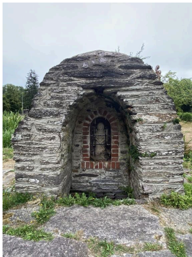
Vue ouest, détail Phot. Baptiste Oligo IVR53_20255610963NUCA
