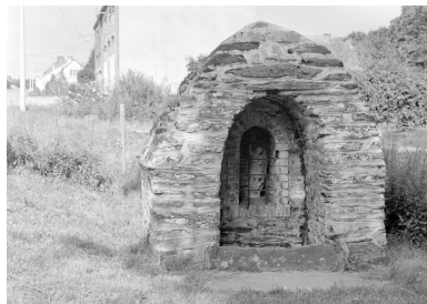
Vue générale ouest Phot. François Dagorn IVR53_19775600535X
