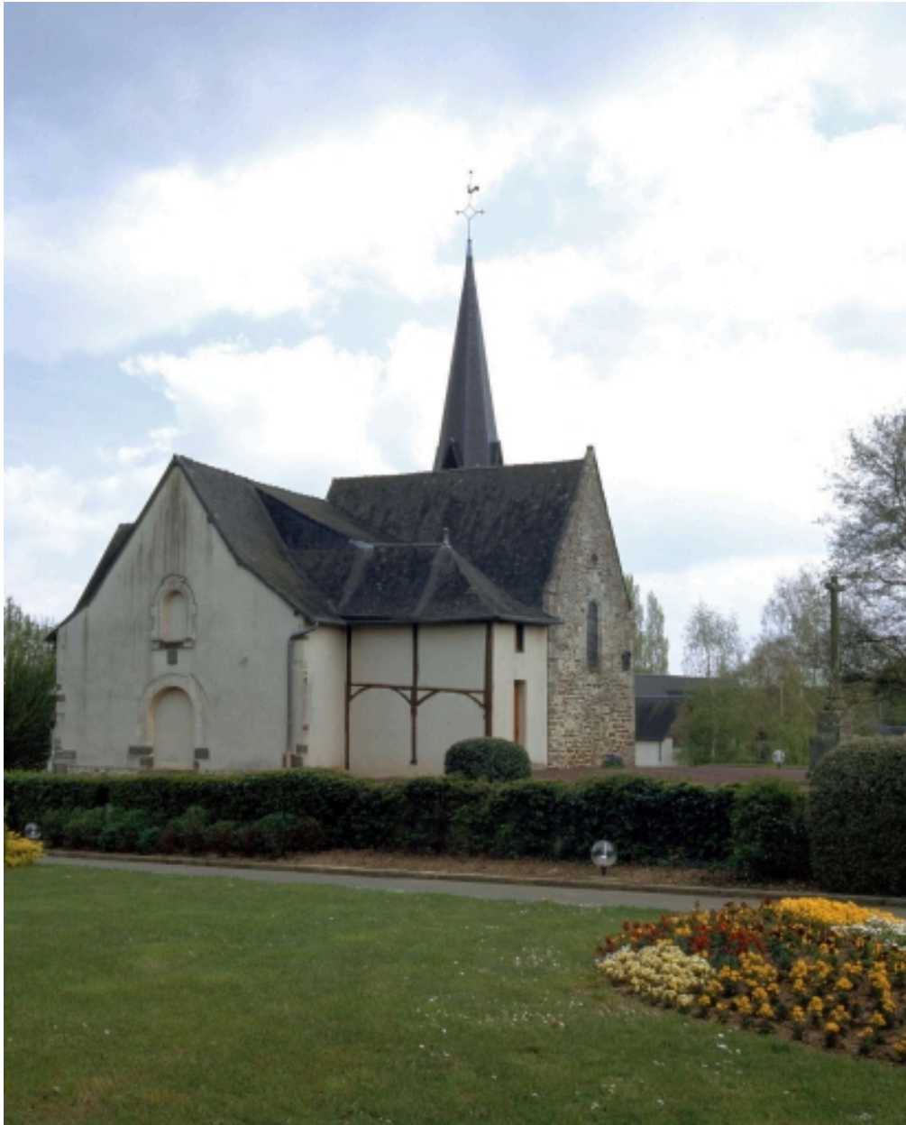
Façade sud-ouest, état après restauration
