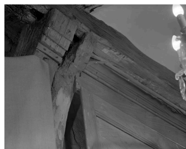
Vue intérieure, sablères, état vers 1980 Phot. Norbert Lambart IVR53_20133501315X
