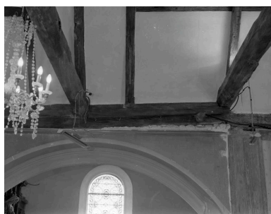
Vue intérieure, sablière de la nef, état vers 1980 Phot. Norbert Lambart IVR53_20133501301X
