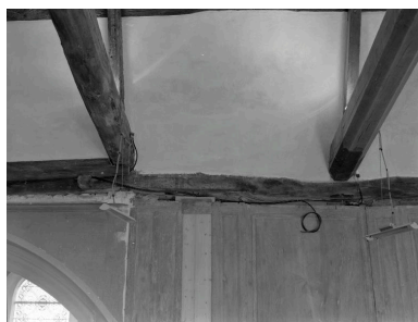
Vue intérieure, sablières et lambris de la nef, état vers 1980 Phot. Norbert Lambart IVR53_20133501316X
