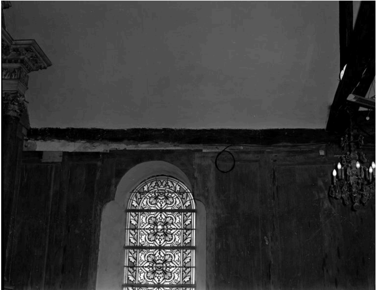
Vue intérieure, sablières et lambris de la nef, état vers 1980
