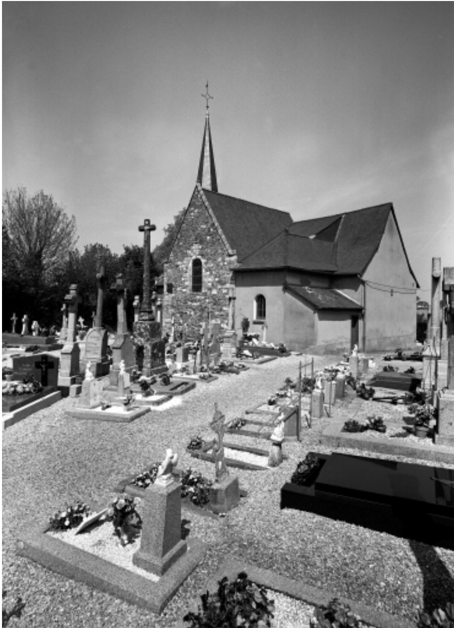
Vue depuis le sud-ouest (état en 1975)
