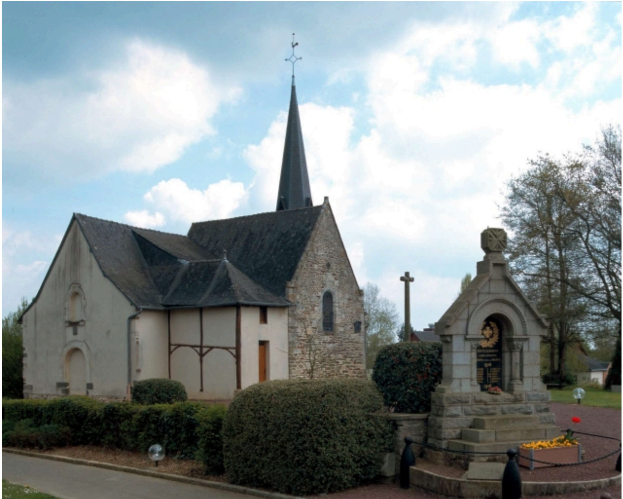
Vue générale, façades sud-ouest
