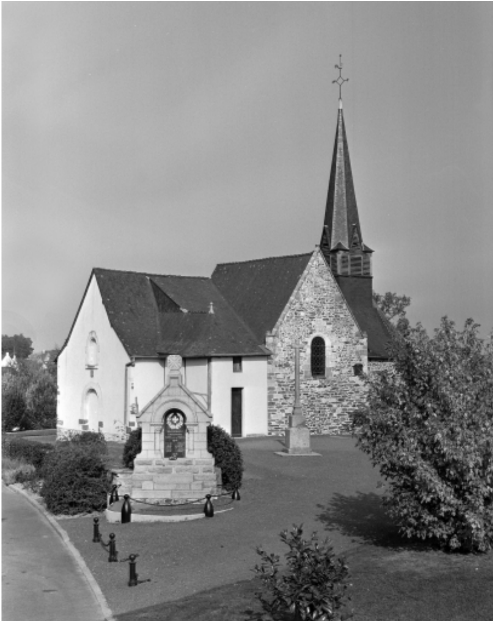
Elévation sud, état après restauration
