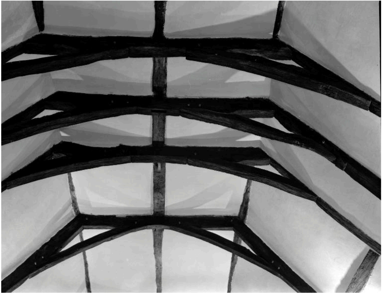
Vue intérieure, charpente de la nef, état vers 1980
