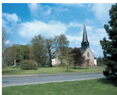
Elevation est, état après restauration Phot. Guy Artur, Phot. Norbert Lambart IVR53_20013502090XA
