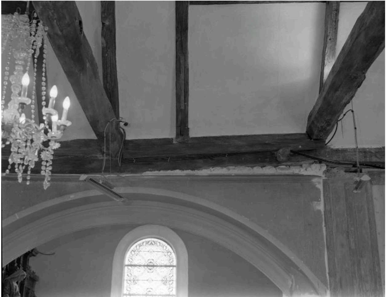
Vue intérieure, sablières, état vers 1980
