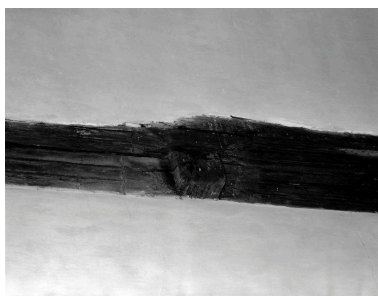
Vue intérieure, sablières de la nef, état vers 1980 Phot. Norbert Lambart IVR53_20133501317X
