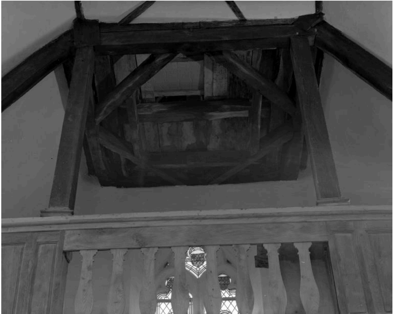
Carrée du clocher en bas de nef, état vers 1980
