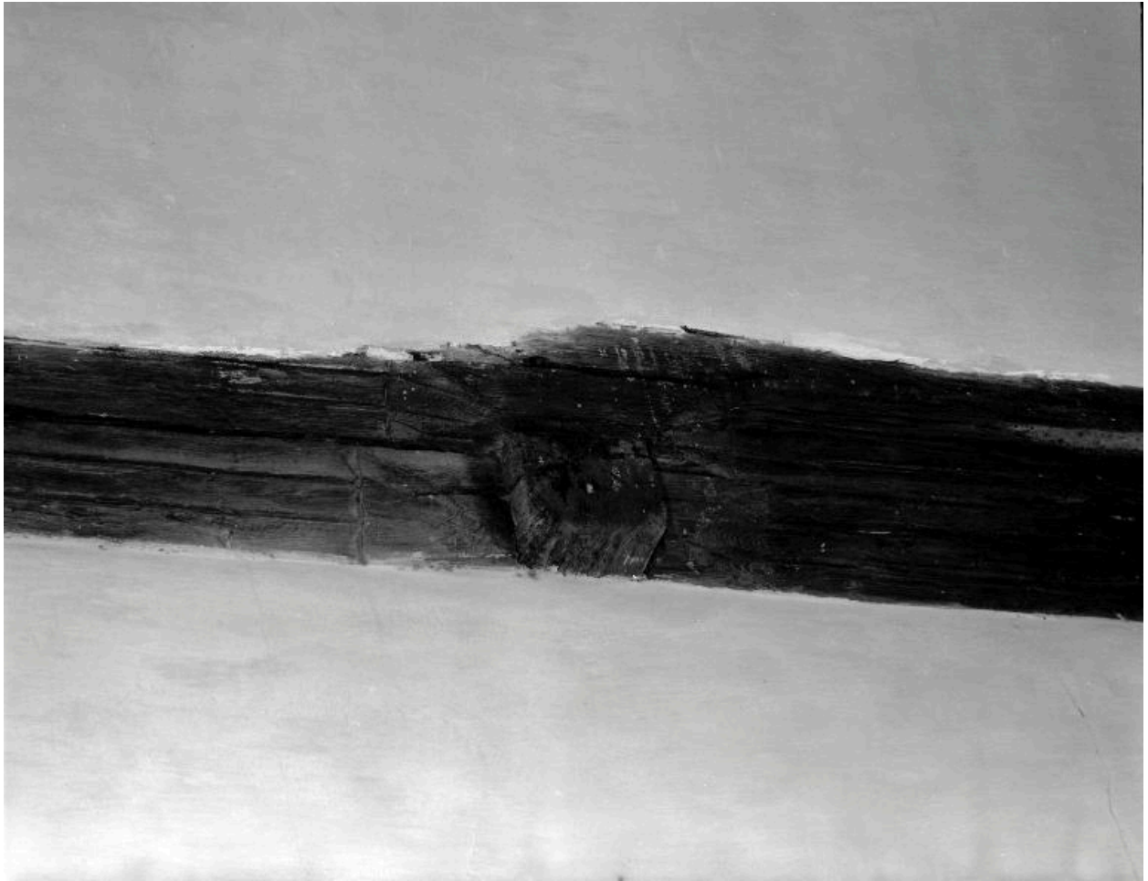
Vue intérieure, sablières de la nef, état vers 1980
