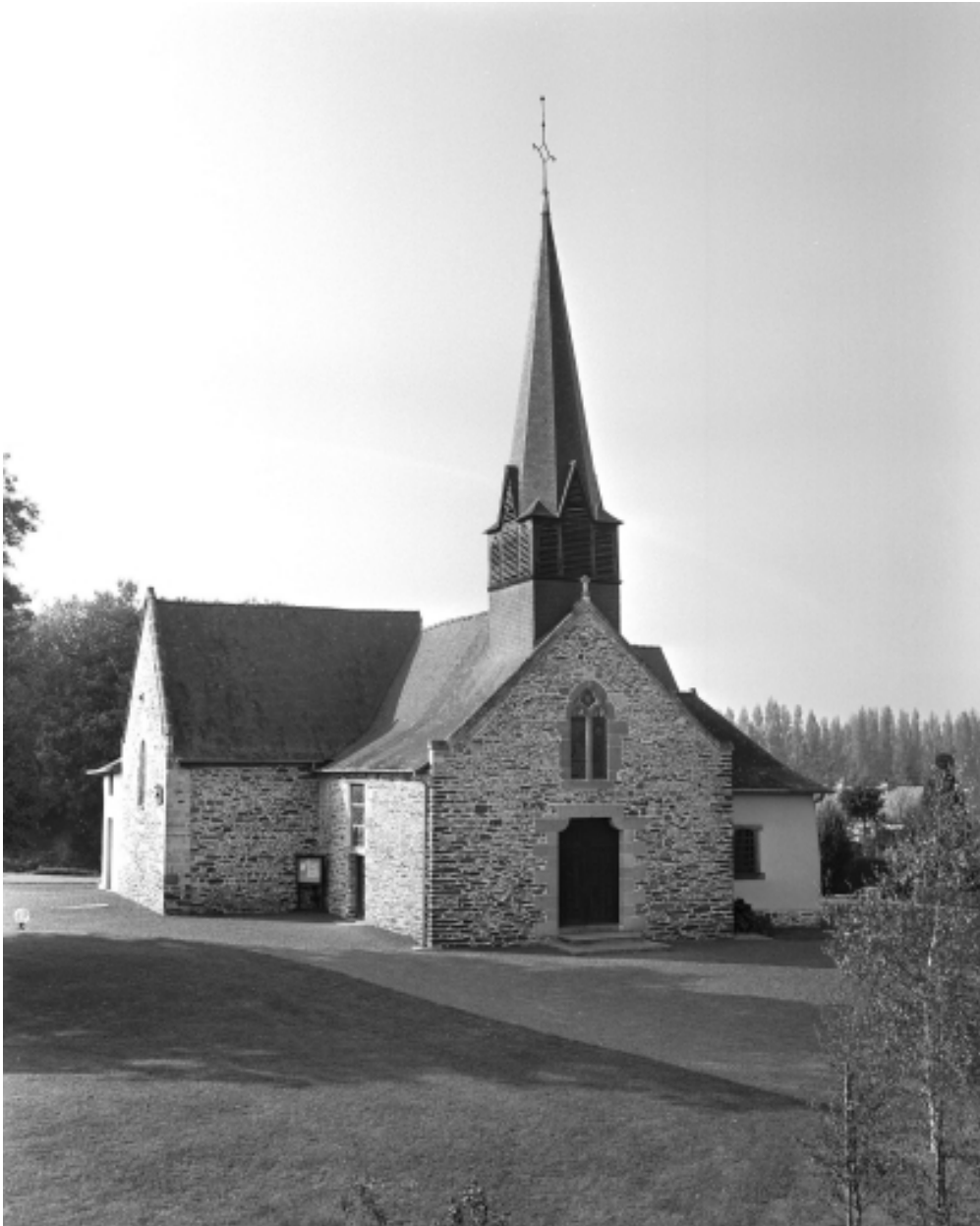
Elévation est, état après restauration
