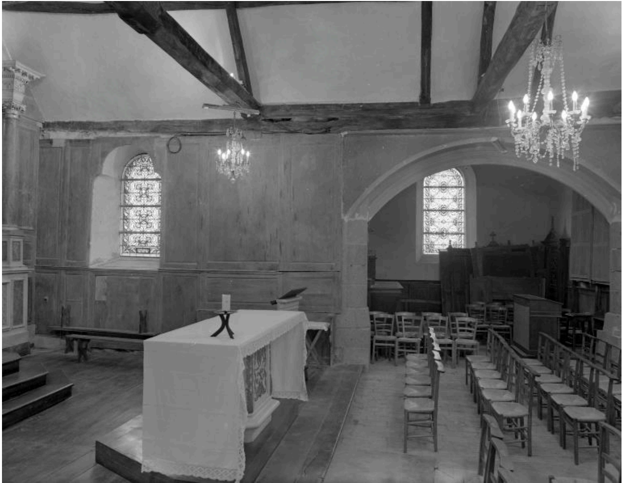
Vue intérieure, chapelle latérale, état vers 1980
