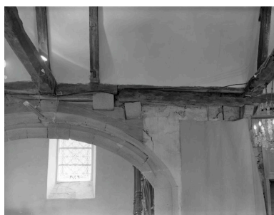
Vue intérieure, sablières et lambris de la nef, état vers 1980 Phot. Norbert Lambart IVR53_20133501307X
