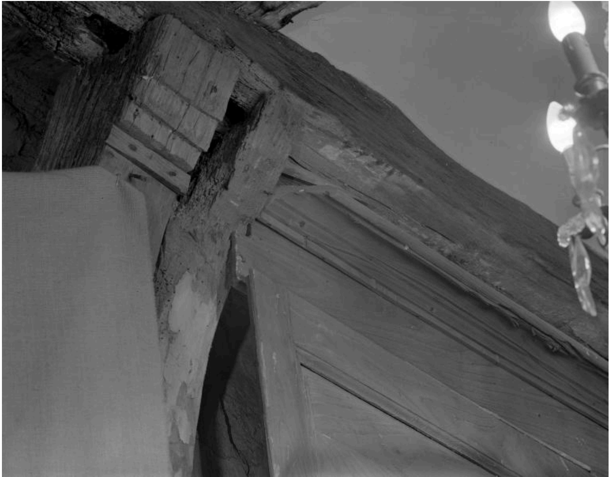
Vue intérieure, sablières, état vers 1980
