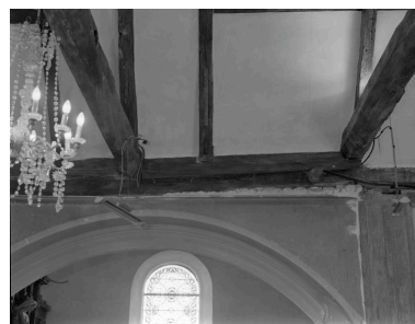
Vue intérieure, sablières, état vers 1980 Phot. Norbert Lambart IVR53_20133501320X
