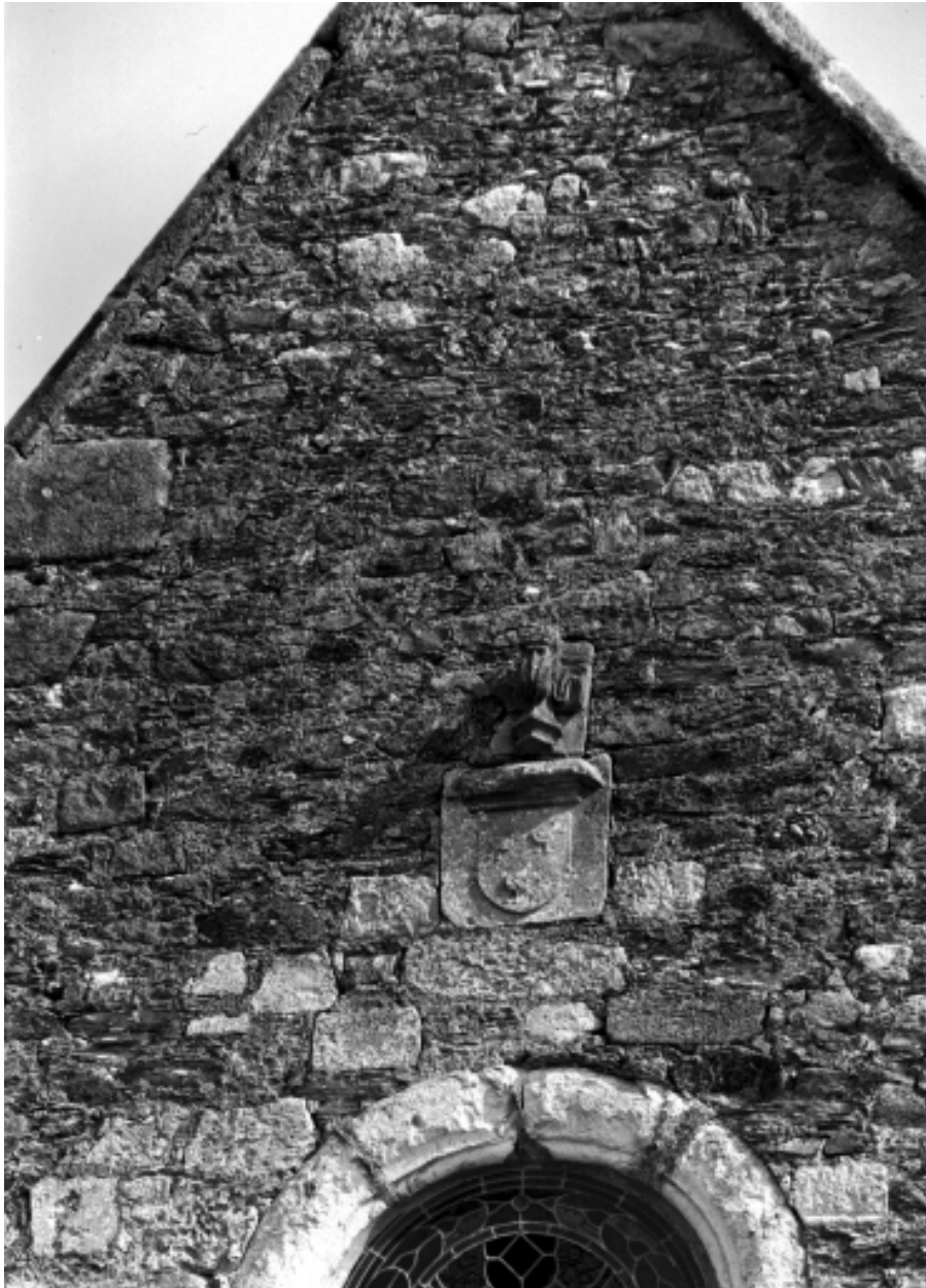
Transept sud, détail du blason, état en 1975
