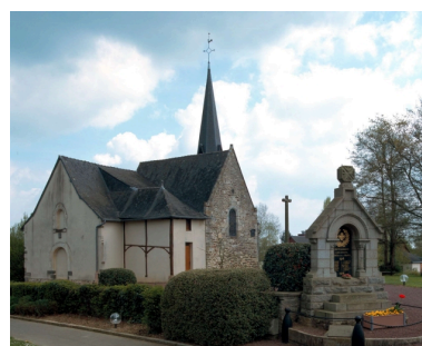
Vue générale, façades sud-ouest Phot. Guy Artur, Phot. Norbert Lambart IVR53_20013502093XA
