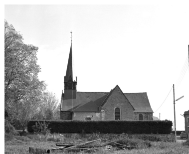
Vue générale depuis le nord (état en 1975) Phot. François Dagorn IVR53_19913500072X
