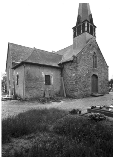
Vue générale de l'élévation est (état en 1975) Phot. François Dagorn IVR53_19913500080V
