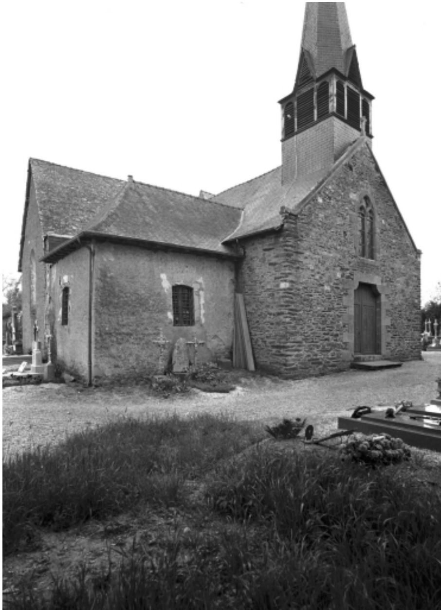
Vue générale de l'élévation est (état en 1975)
