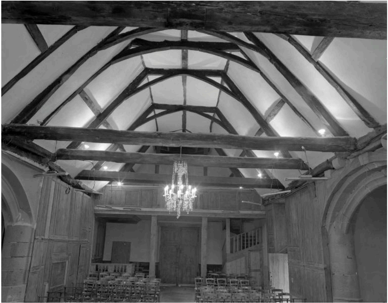
Vue intérieure, charpente, vue vers le bas de la nef, état vers 1980
