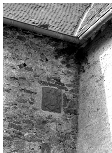
Elévation nord, détail du blason (état en 1975) Phot. François Dagorn IVR53_19913500083V
