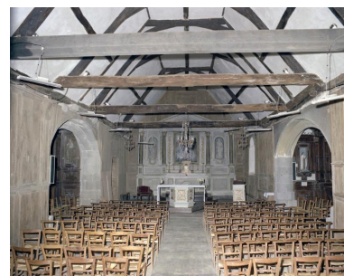
Vue intérieure de l'église, prise du bas de la nef vers le choeur, vers 1980 Phot. Norbert Lambart IVR53_20133501273XA
