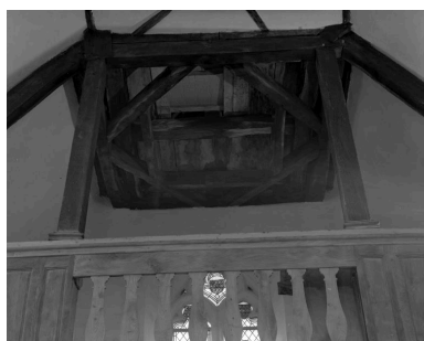
Carrée du clocher en bas de nef, état vers 1980 Phot. Norbert Lambart IVR53_20133501304X
