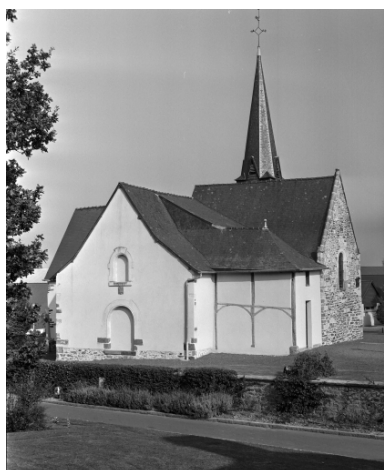
Elévation ouest, état après restauration Phot. Guy Artur, Phot. Norbert Lambart IVR53_19943502158X
