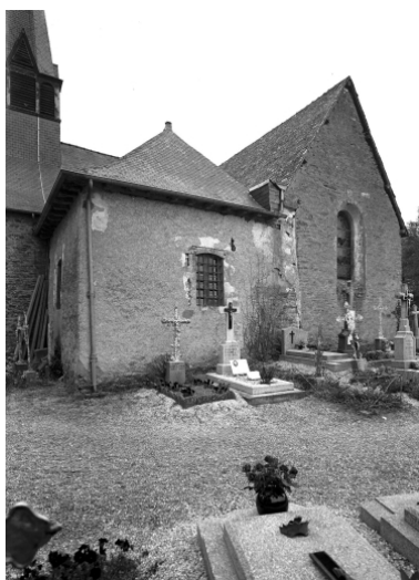
Elévation nord, ancienne sacristie (état en 1975) Phot. François Dagorn IVR53_19913500081V
