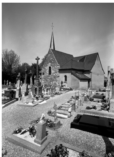
Vue depuis le sud-ouest (état en 1975) Phot. François Dagorn IVR53_19913500076V
