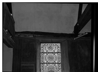
Vue intérieure, sablières et lambris de la nef, état vers 1980 Phot. Norbert Lambart IVR53_20133501306X
