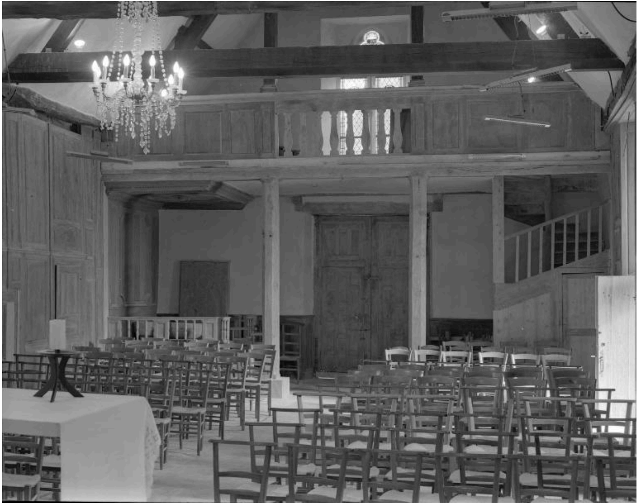
Vue intérieure, tribune, état vers 1980
