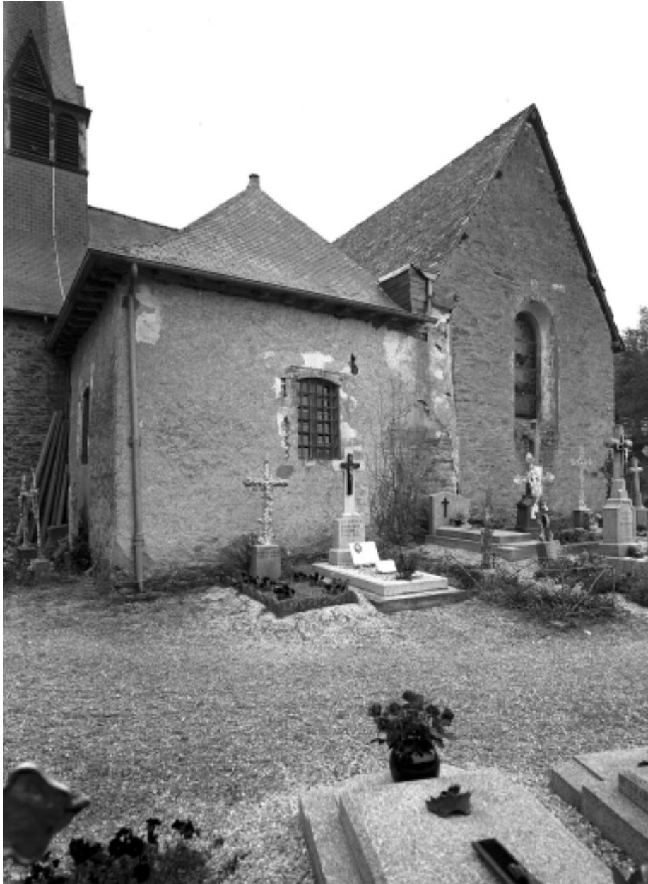
Elévation nord, ancienne sacristie (état en 1975)
