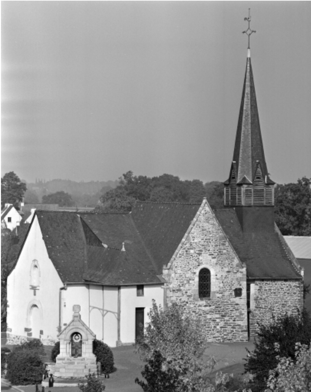
Elévation sud-ouest, état après restauration
