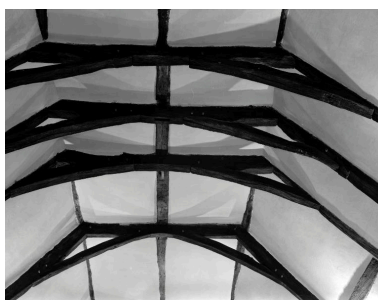
Vue intérieure, charpente de la nef, état vers 1980 Phot. Norbert Lambart IVR53_20133501311X
