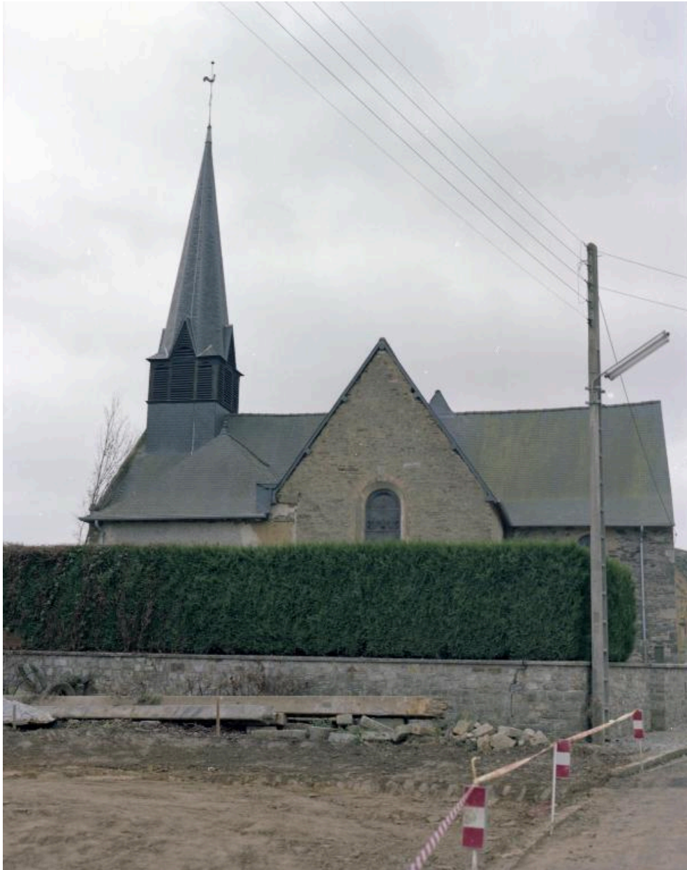
Façade latérale, vers 1980
