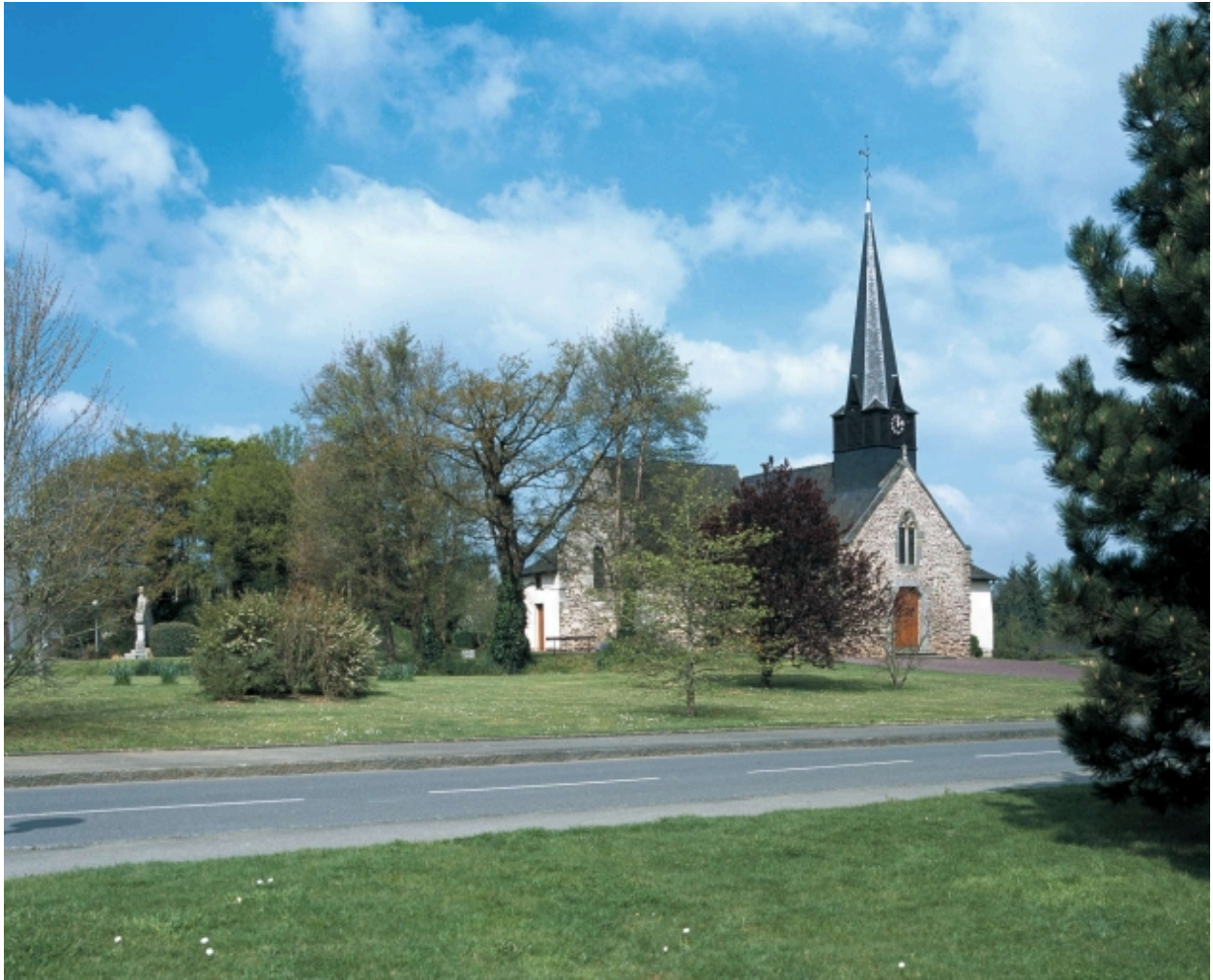
Elevation est, état après restauration
