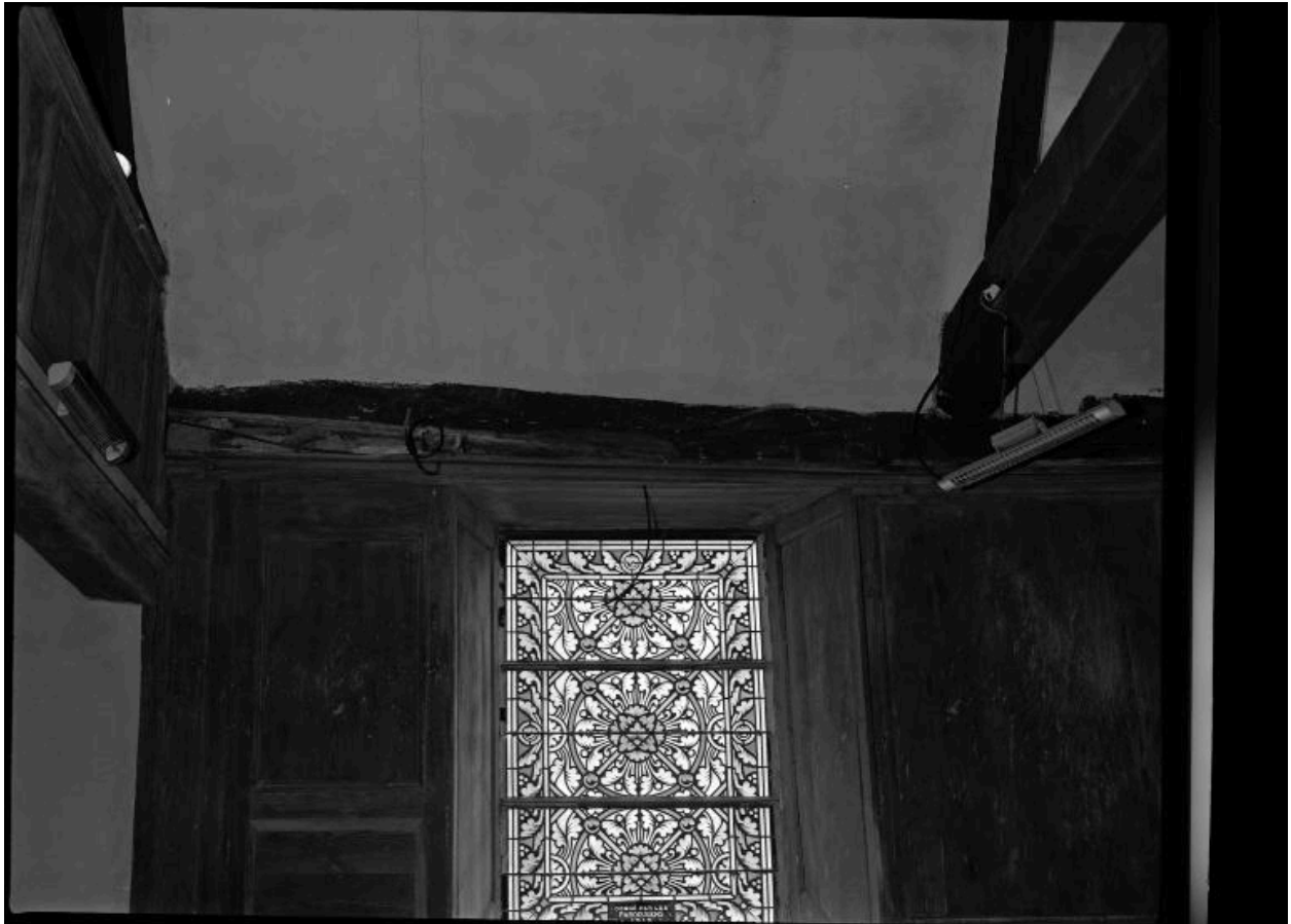
Vue intérieure, sablières et lambris de la nef, état vers 1980
