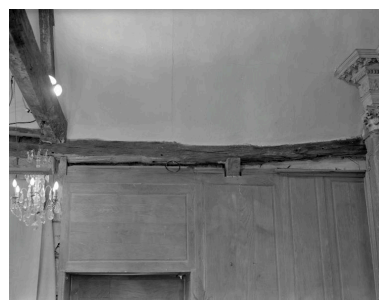
Vue intérieure, sablières et lambris du chœur, état vers 1980 Phot. Norbert Lambart IVR53_20133501312X
