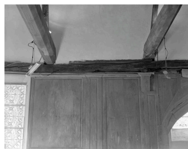
Vue intérieure, sablières et lambris de la nef, état vers 1980 Phot. Norbert Lambart IVR53_20133501309X
