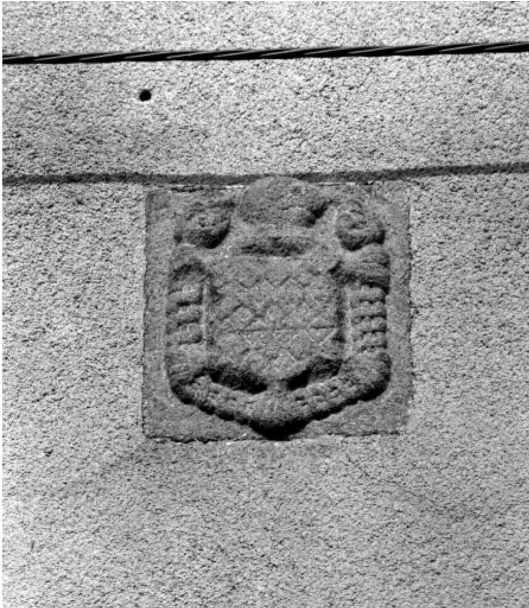
Elévation ouest, détail du blason (état en 1975)
