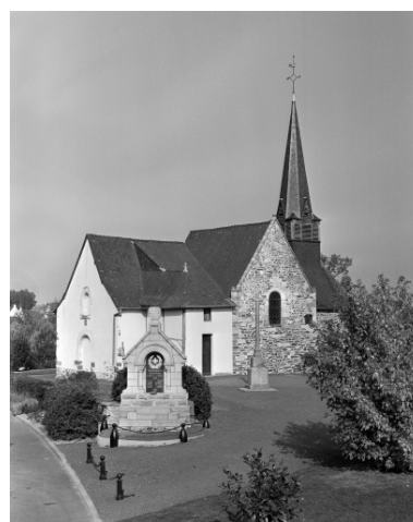
Elévation sud, état après restauration Phot. Guy Artur, Phot. Norbert Lambart IVR53_19943502157X
