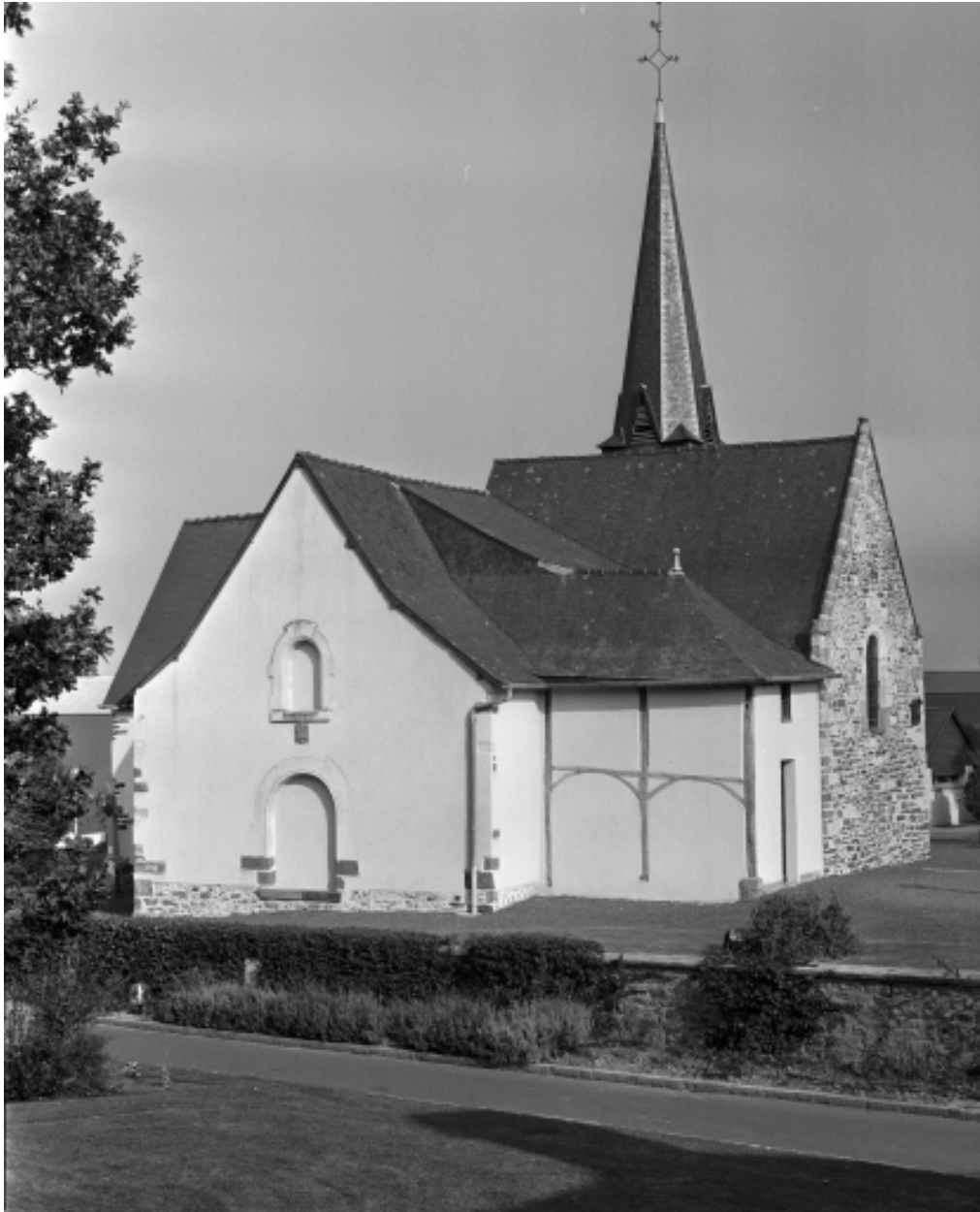
Elévation ouest, état après restauration
