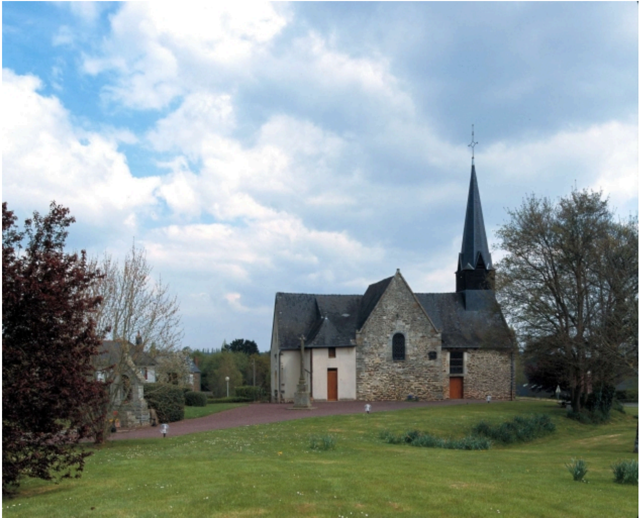
Façade nord, état après restauration
