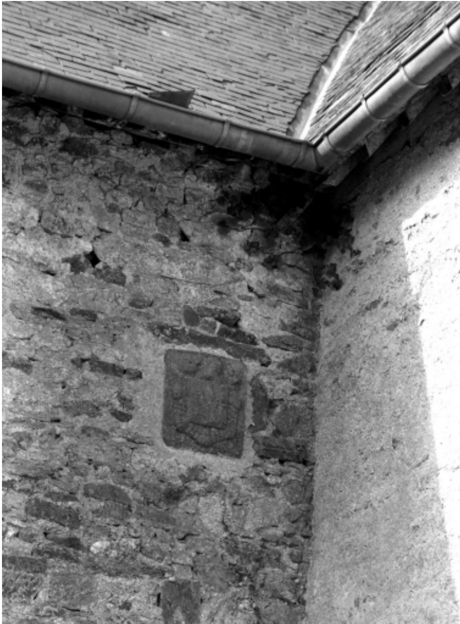
Elévation nord, détail du blason (état en 1975)
