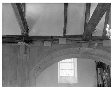
Vue intérieure, sablières et lambris de la nef, état vers 1980 Phot. Norbert Lambart IVR53_20133501310X
