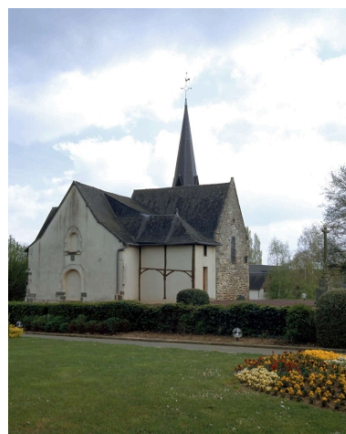
Façade sud-ouest, état après restauration Phot. Guy Artur, Phot. Norbert Lambart IVR53_20013502092XA
