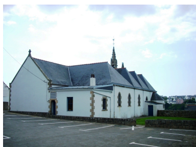
Plouhinec, église paroissiale de Poulgoazec : vue générale nord-est Phot. Gwénaél Fauchille IVR53_20082906496NUCA
