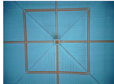
Plouhinec, église paroissiale de Poulgoazec : détail lambris de couverture Phot. Gwénaél Fauchille IVR53_20082905768NUCA
