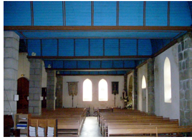
Plouhinec, église paroissiale de Poulgoazec : bas-côté nord vue axiale ouest Phot. Gwénaél Fauchille IVR53_20082905764NUCA
