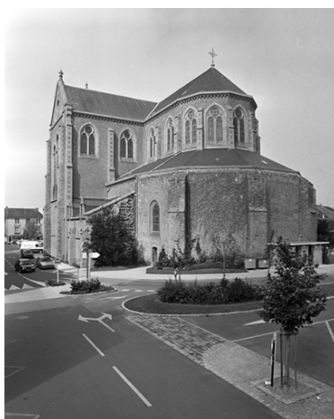
Vue générale est Phot. Guy Artur, Phot. Norbert Lambart IVR53_19943501911X
