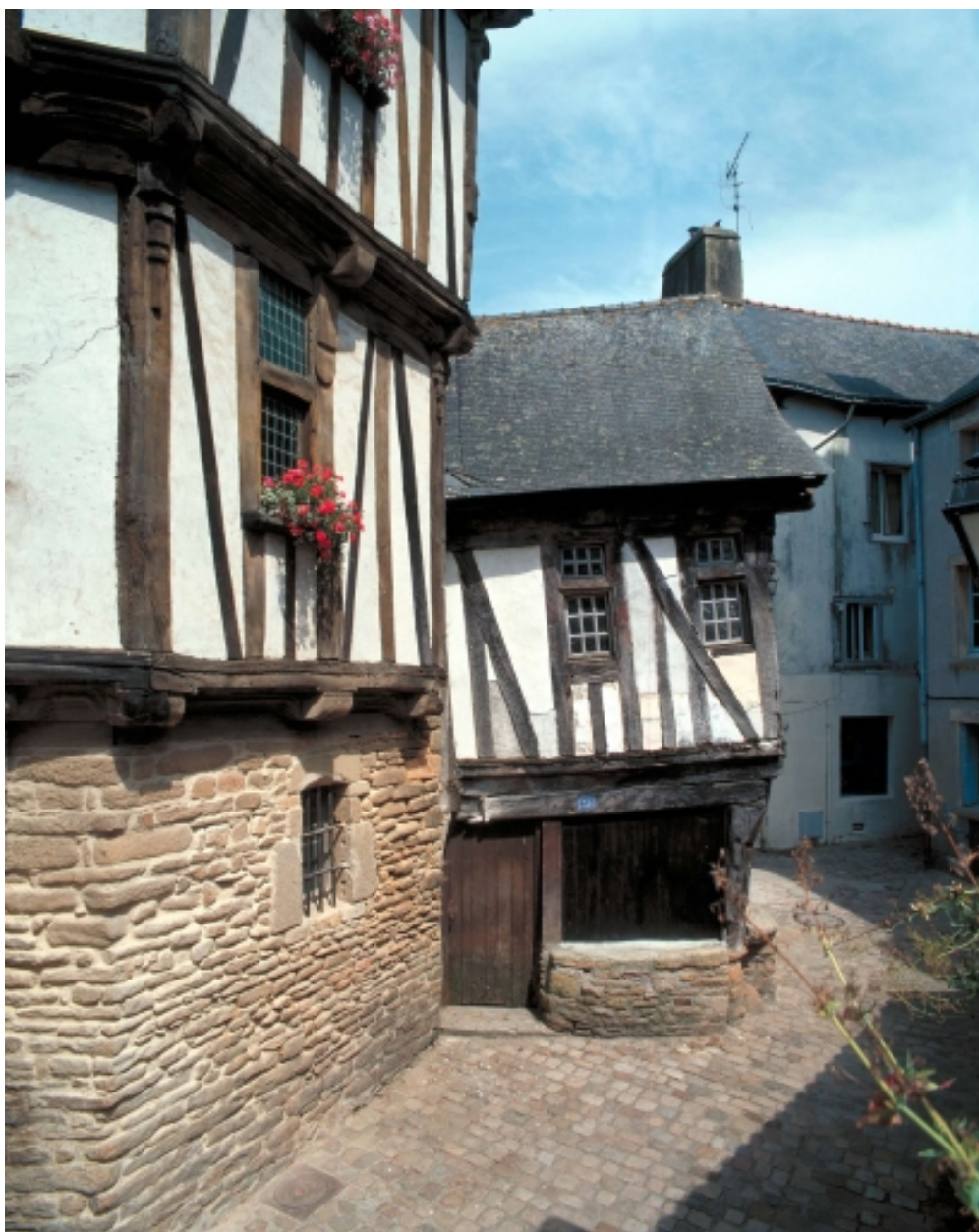
Elévation sud, vue générale
