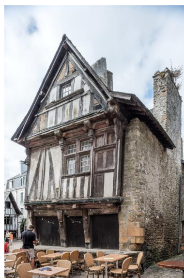
Façade sur rue en pan de bois, intégrant à l'étage une fenêtre à meneau et croisée ainsi qu'une porte. Phot. Charlotte Barraud IVR53_20222900504NUCA
