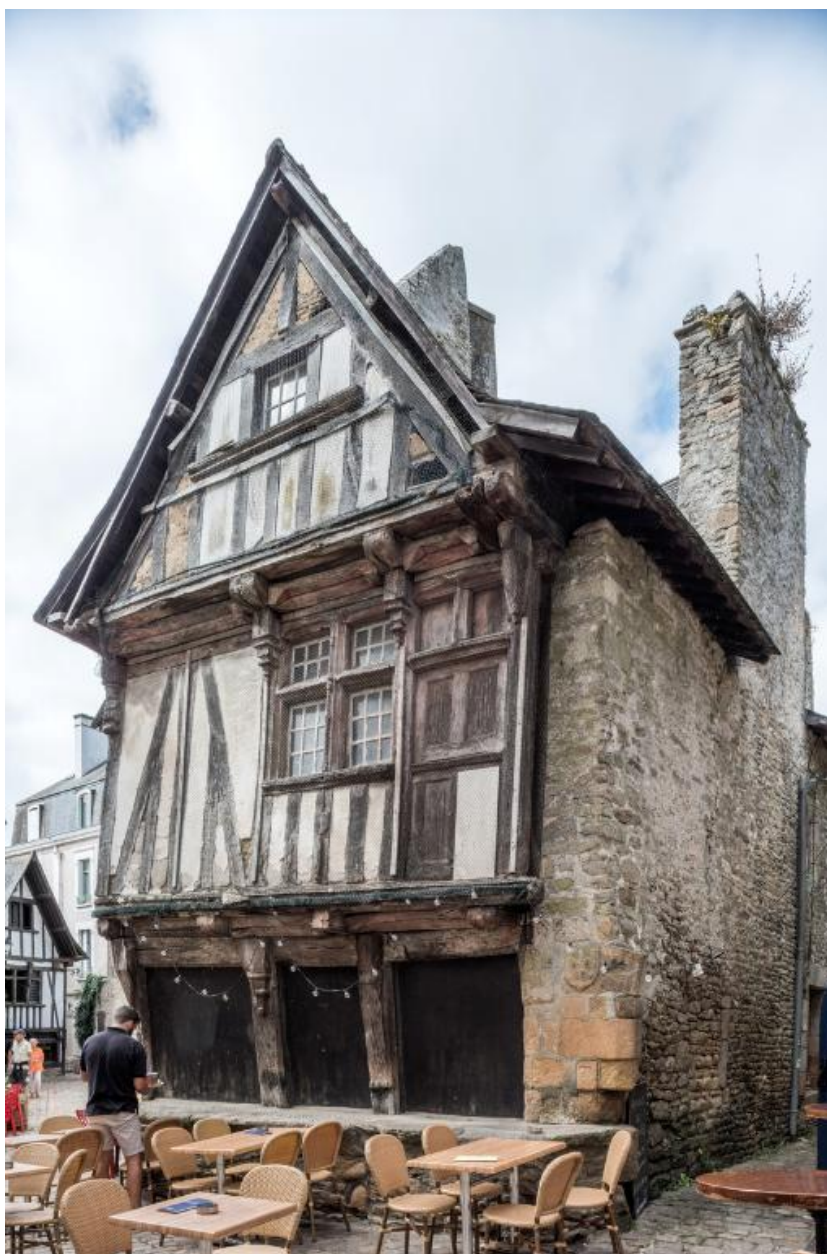
Façade sur rue en pan de bois, intégrant à l'étage une fenêtre à meneau et croisée ainsi qu'une porte.
