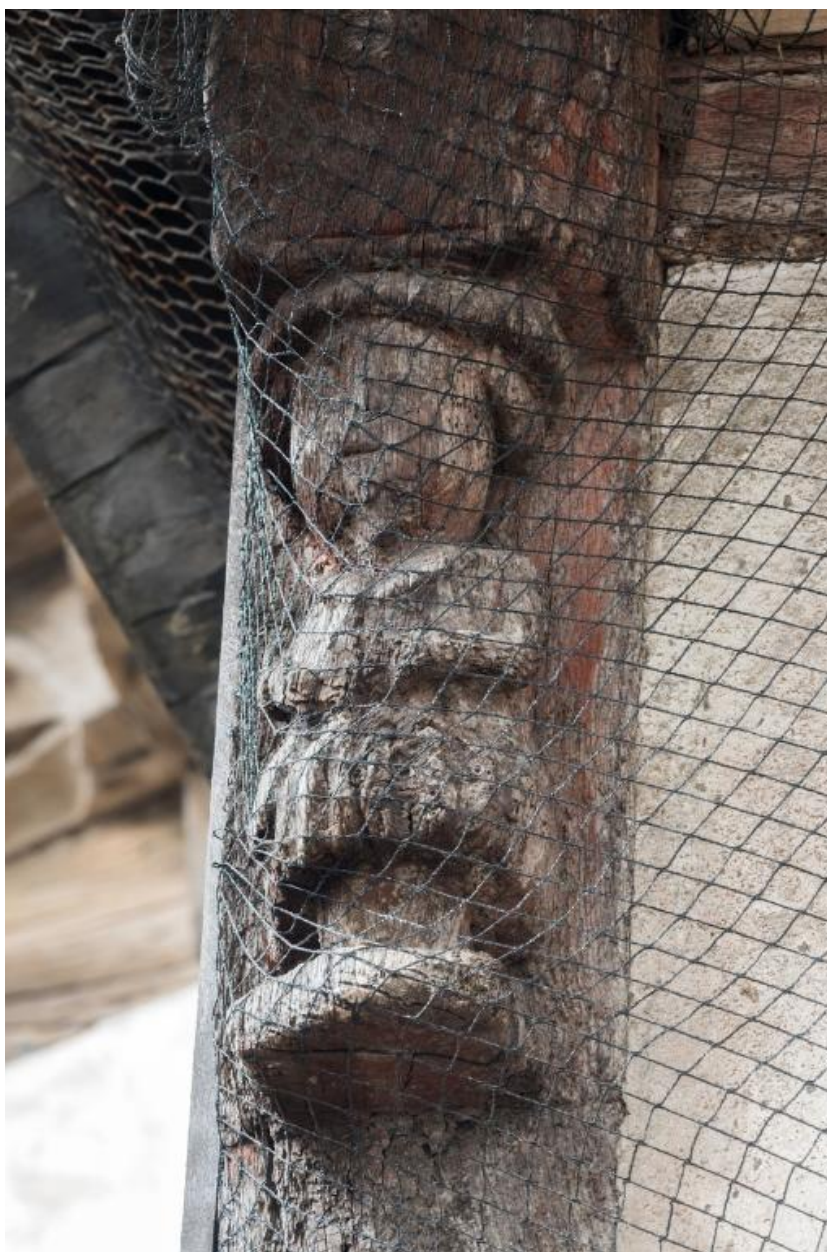
Personnage sculpté sur le poteau cornier sud-est du premier étage.
