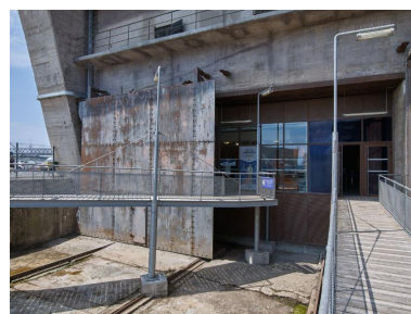
Vue de l'entrée de l'alvéole "K6a" : portes blindées et passerelles du musée (2021) Phot. Bernard Bègne IVR53_20215600542NUCA
