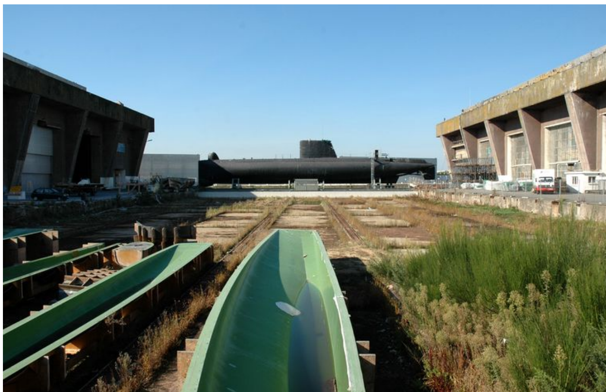
Vue du terre-plein - plate-forme de translation - situé entre les bunkers "KI" et "KII" (2005) : au centre, le sous-marin Flore (S645, lancé en 1960)
