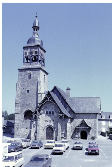
Ancienne église, actuellement mairie, élévation ouest. Phot. Guy Artur, Phot. Norbert Lambart IVR53_19803500625XE
