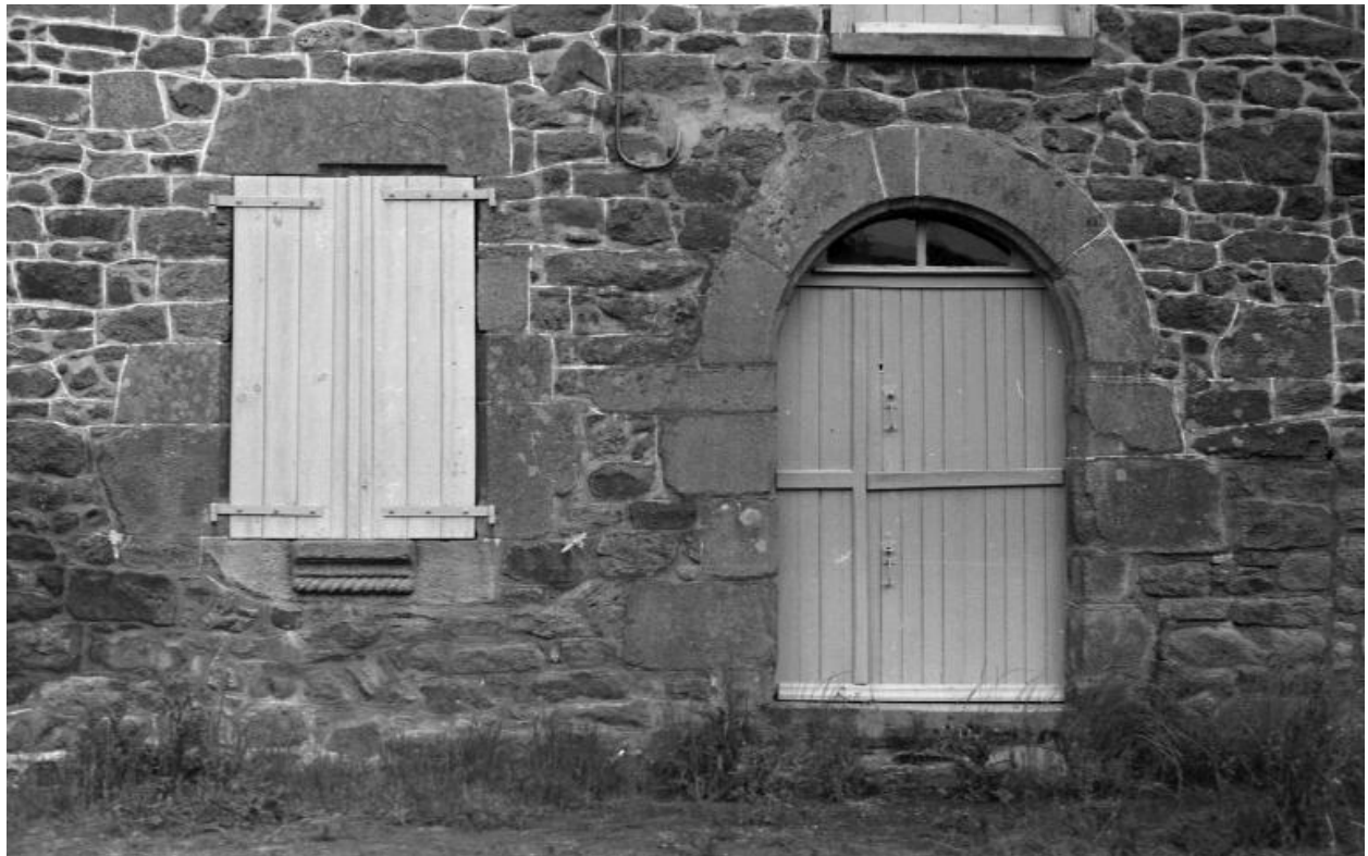
Détails du bâtiment dit "La Forge" du village de Saint-Sulien
