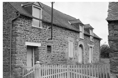
Bâtiment dit "La Forge" du village de Saint-Sulien Phot. Peyronnet, Phot. Marie-Madeleine Tugores IVR53_19752207036Z
