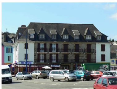
Vue latérale de l'immeuble les Flots, ancien hôtel Sainte-Marine Phot. Johan Vincent IVR53_20072908724NUCA
