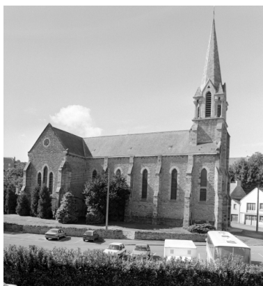
Elévation Est : vue générale Phot. Guy Artur, Phot. Norbert Lambart IVR53_19943501826X
