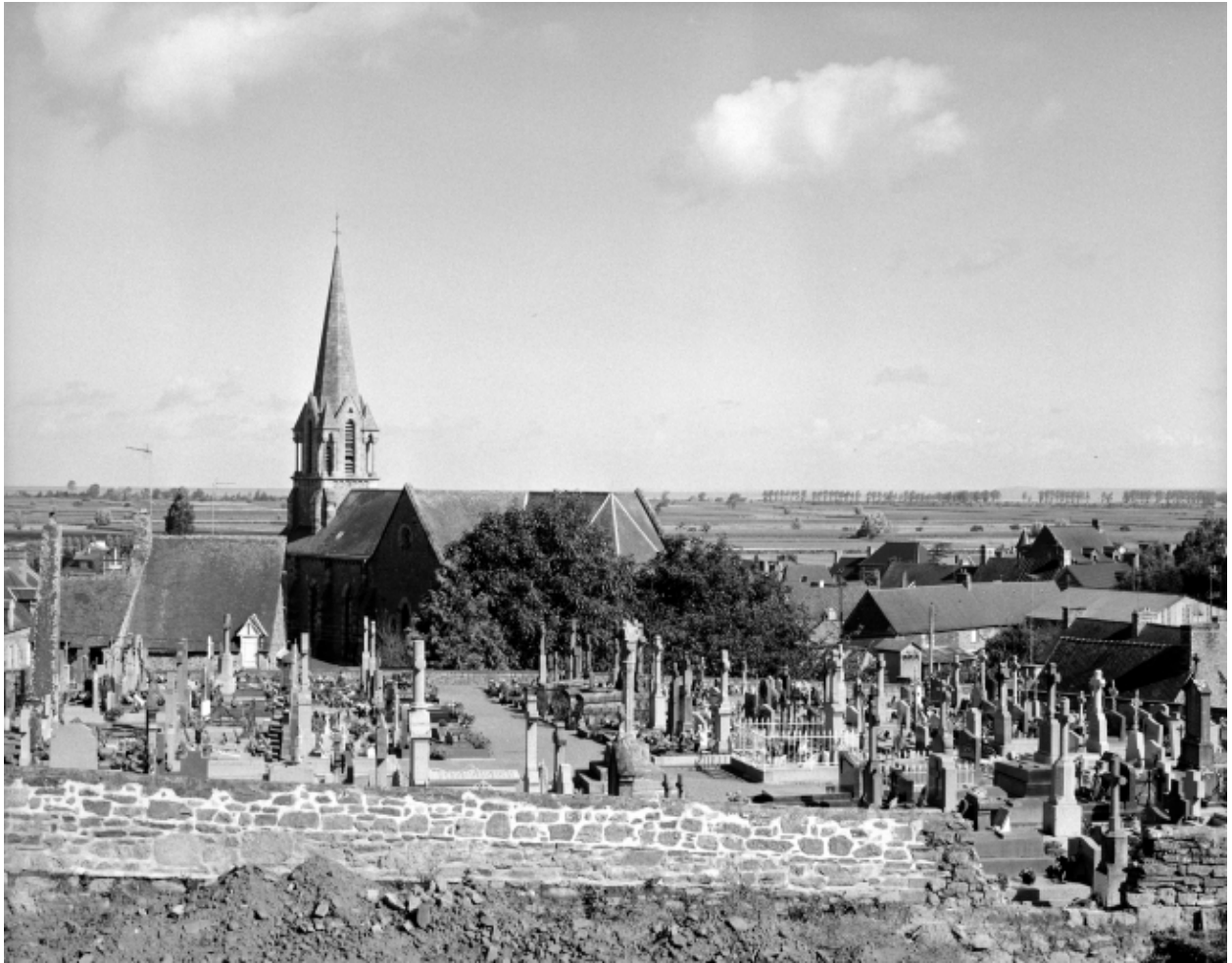
Elévation Sud-Ouest : vue générale
