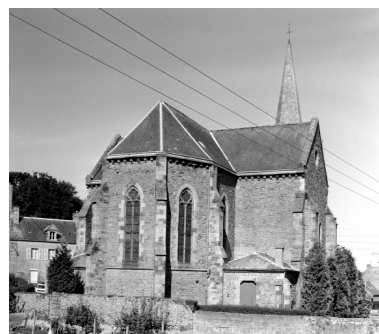
Elévation Sud : vue générale Phot. Guy Artur, Phot. Norbert Lambart IVR53_19943501825X
