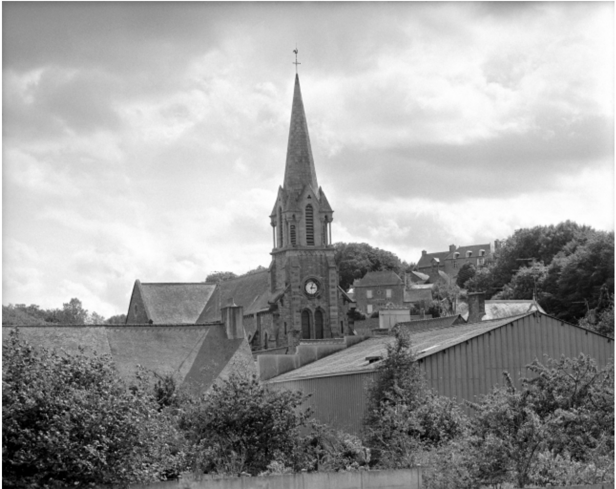
Elévation Nord : vue générale
