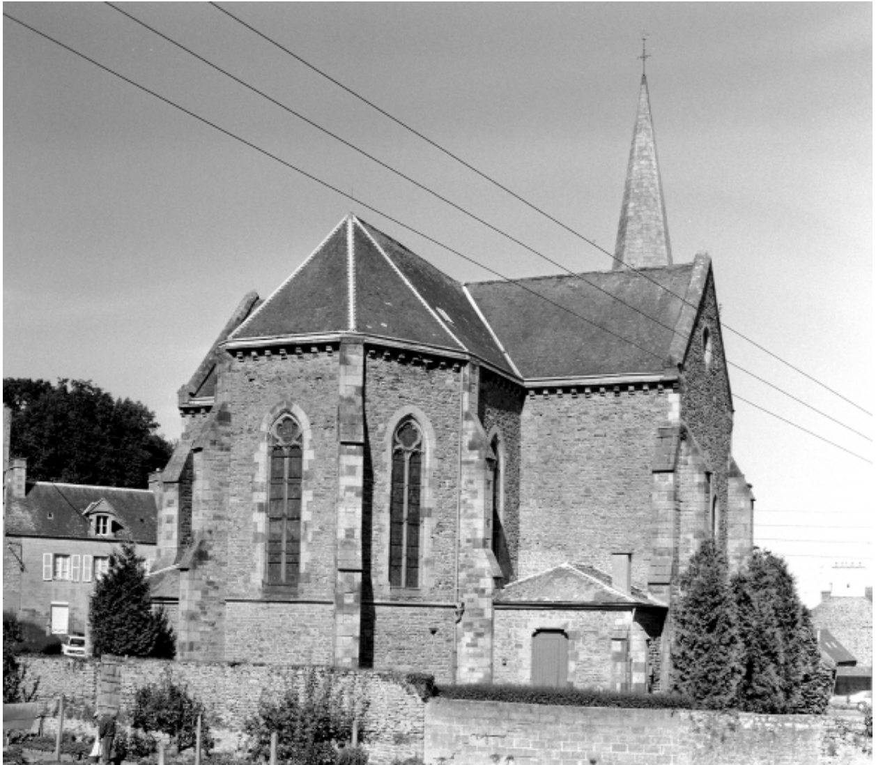
Elévation Sud : vue générale
