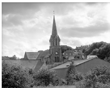
Elévation Nord : vue générale Phot. Guy Artur, Phot. Norbert Lambart IVR53_19943501837X
