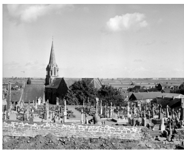
Elévation Sud-Ouest : vue générale Phot. Auteur inconnu IVR53_19943501824X
