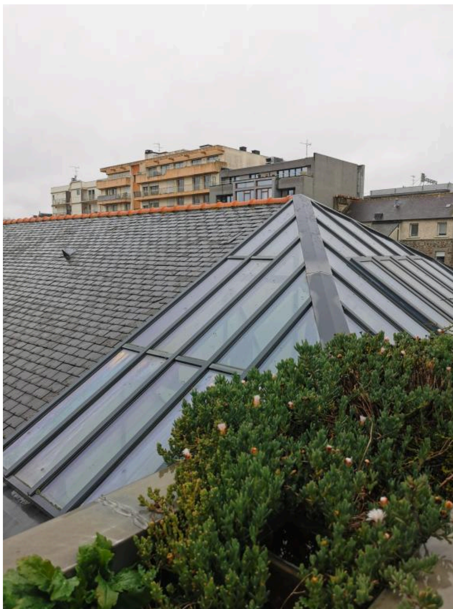
Vue de la couverture de la partie arrière en ardoise et verre
