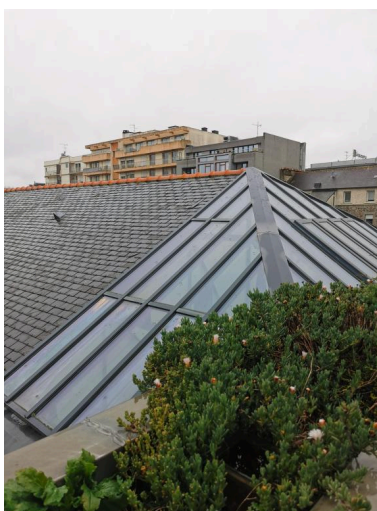
Vue de la couverture de la partie arrière en ardoise et verre Phot. Eve Pellat Pagé IVR53_20222206034NUCA
