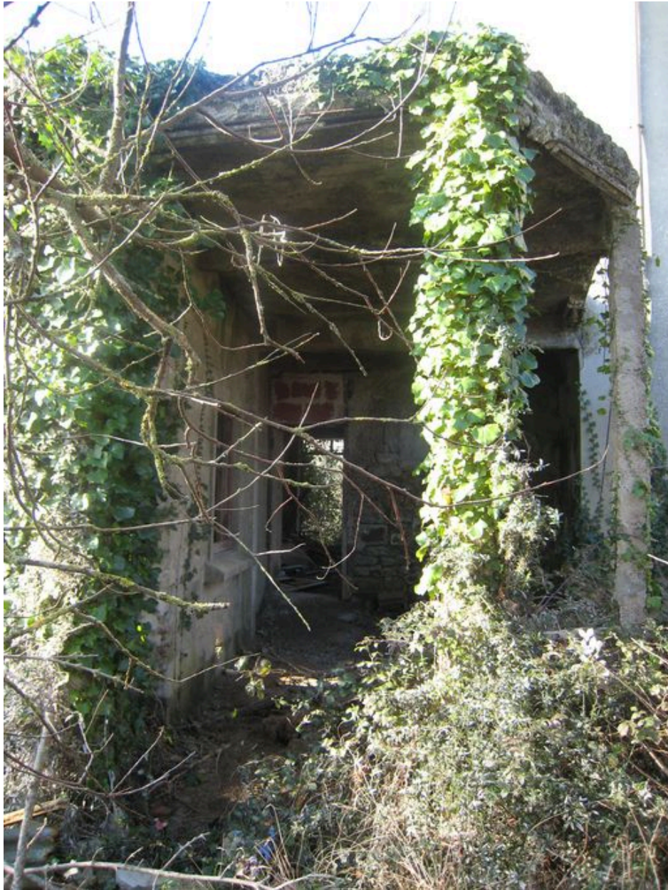
Détail à l'arrière de la villa Bellevue
