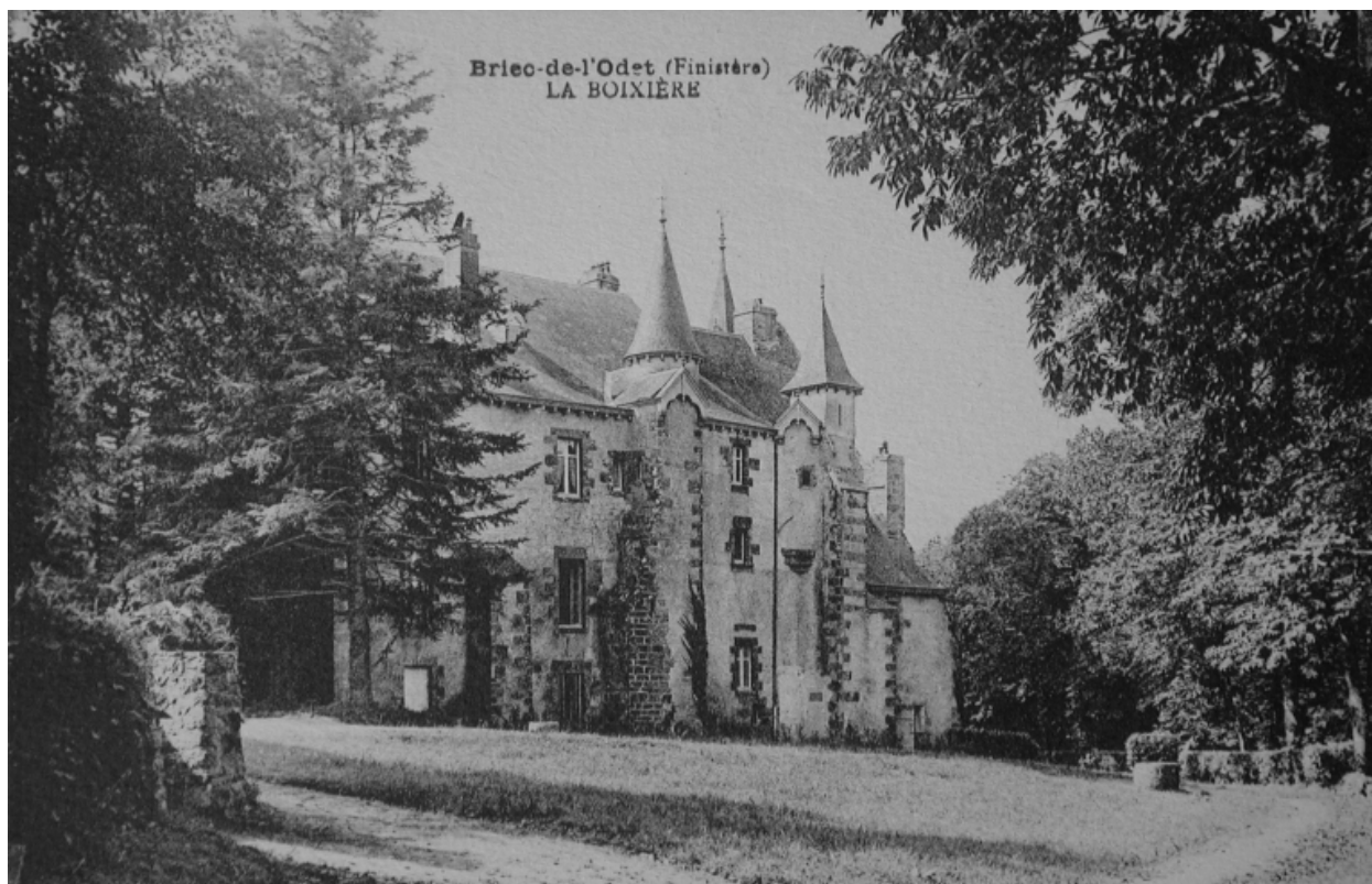
Vue de la façade postérieure
