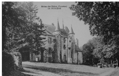
Vue de la façade postérieure Phot. Elise Lauranceau IVR53_20052904373NUCB
