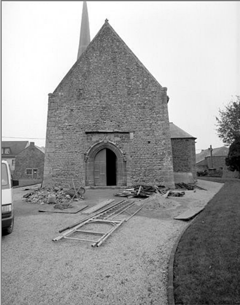
Elévation Ouest : vue générale avant restauration
