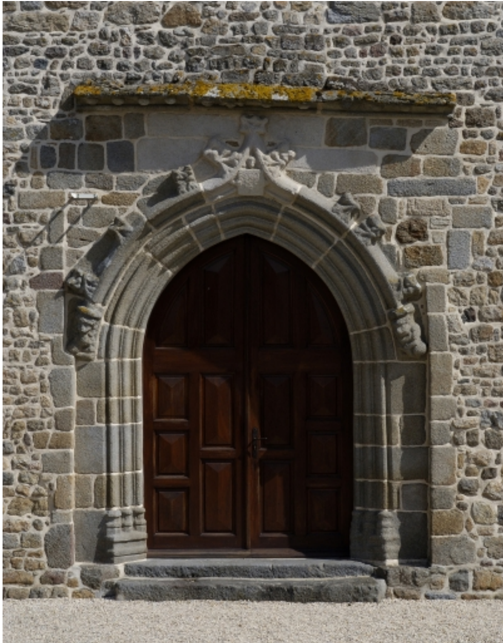
Elévation ouest : détail du porche
