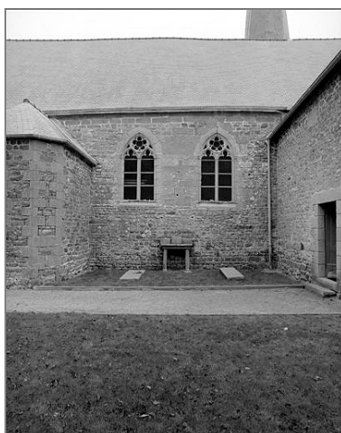
Elévation sud, partie centrale : vue générale avant restauration Phot. Bernard Bègne, Phot. M. Loyon IVR53_19923500903X
