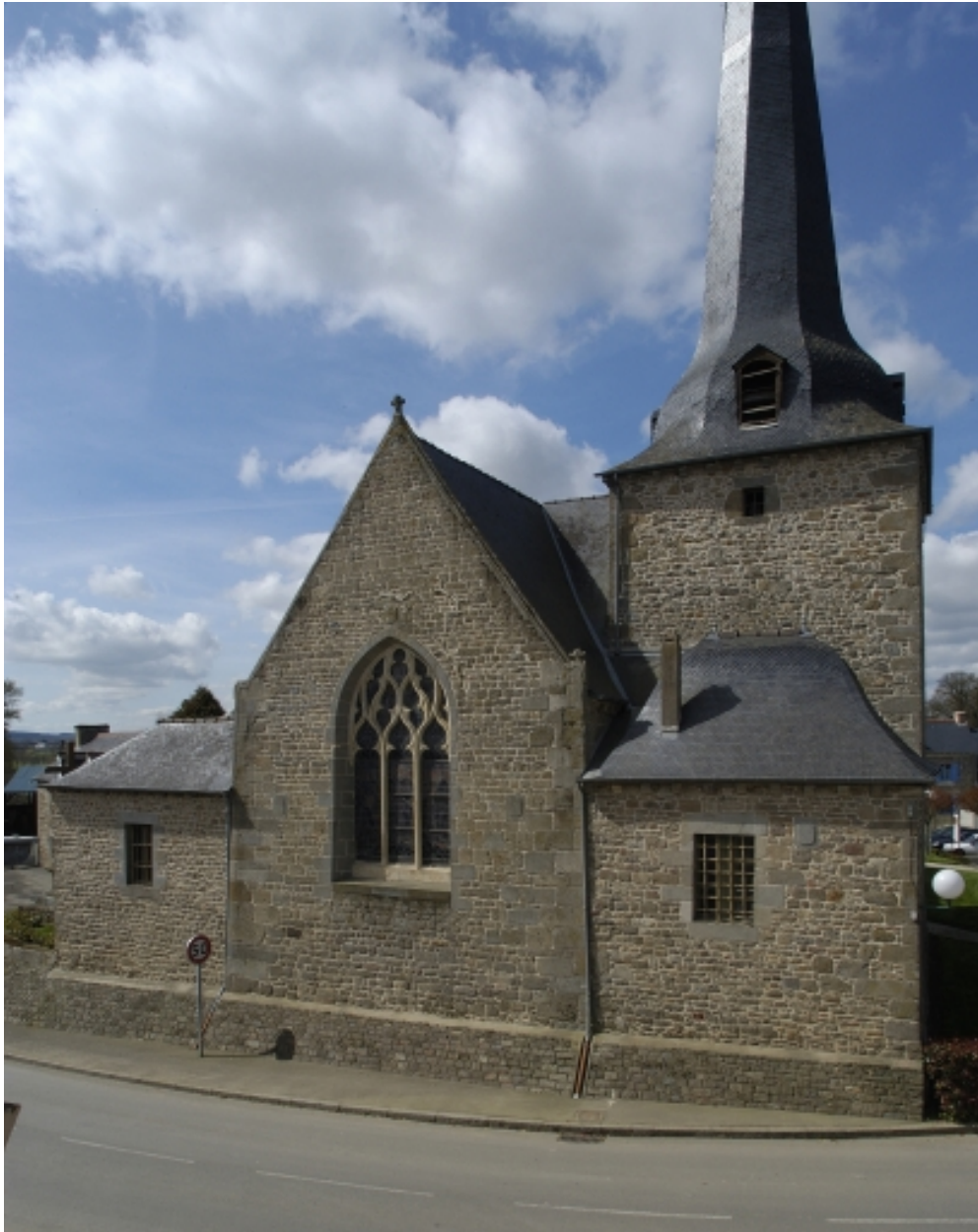
Elévation est : vue générale
