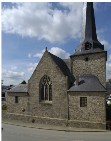
Elévation est : vue générale Phot. Bernard Bègne IVR53_20053501146NUCA
