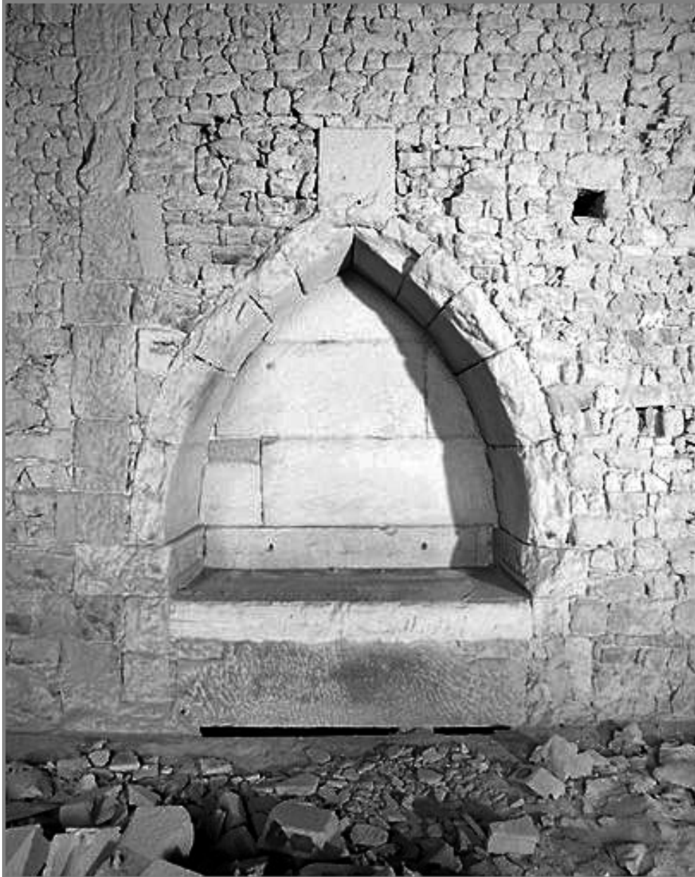
Intérieur, mur nord, partie centrale, niche : vue générale avant restauration
