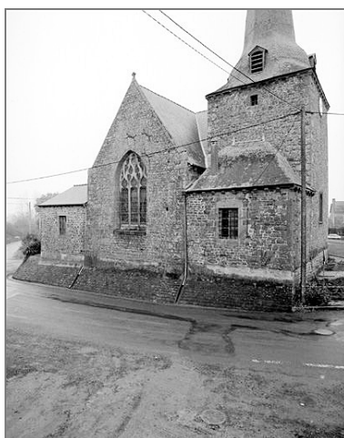
Elévation est : vue générale avant restauration Phot. Bernard Bègne, Phot. M. Loyon IVR53_19923500906X
