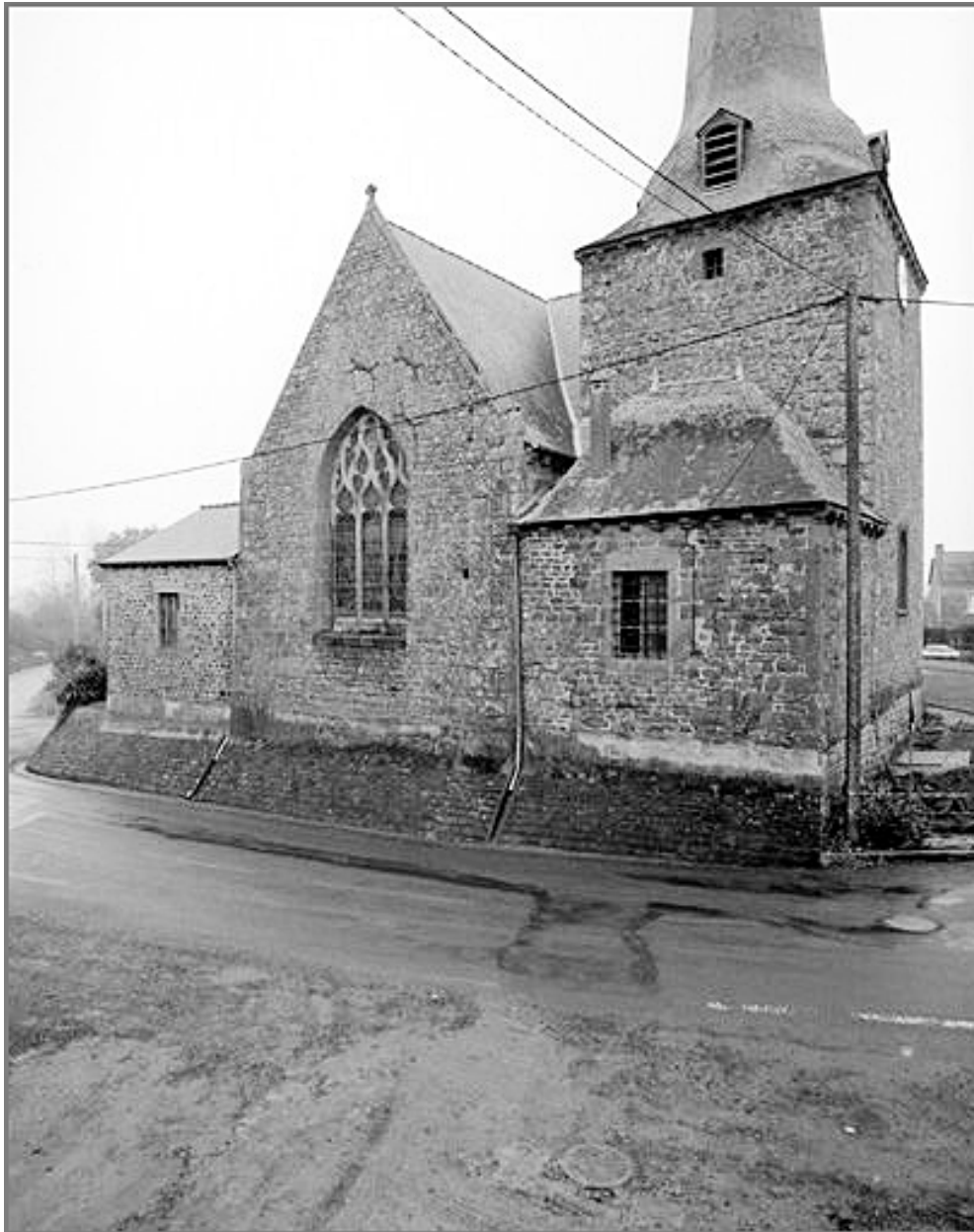
Elévation est : vue générale avant restauration
