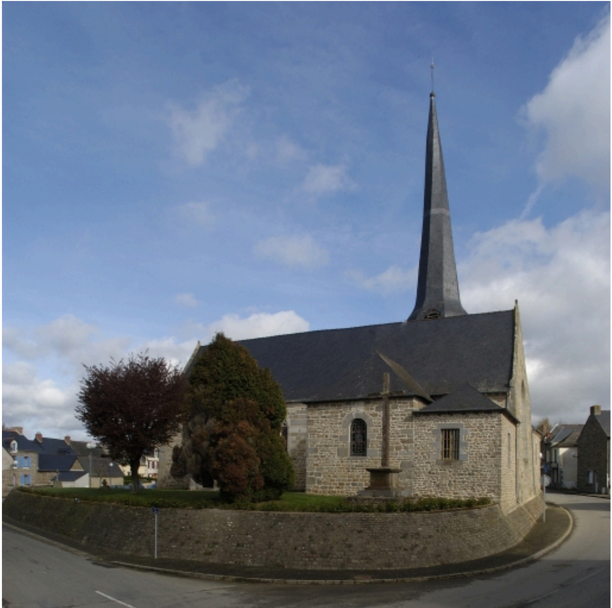
Vue générale sud
