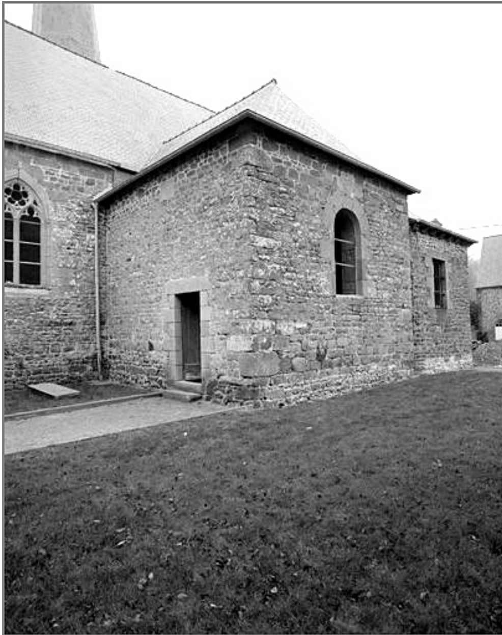
Elévation sud, partie est : vue générale avant restauration
