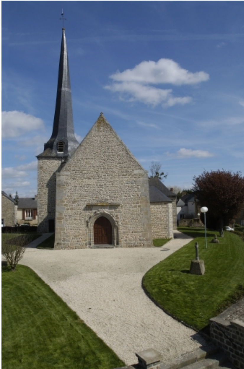
Elévation ouest : vue générale
