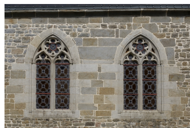
Elévation sud : détail des baies centrales Phot. Bernard Bègne IVR53_20053501056NUCA
