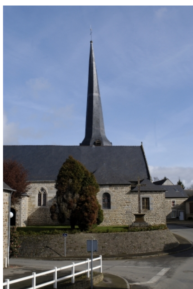
Elévation sud : vue partielle Phot. Bernard Bègne
