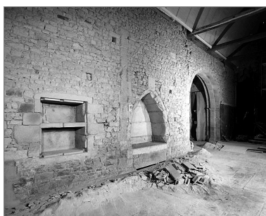
Intérieur, mur nord, partie centrale : vue générale avant restauration Phot. Bernard Bègne, Phot. M. Loyon IVR53_19923500908X
