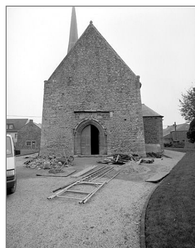
Elévation Ouest : vue générale avant restauration Phot. Bernard Bègne, Phot. M. Loyon IVR53_19923502253X
