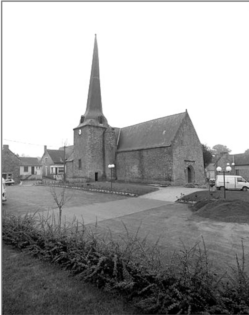
Elévation nord-ouest : vue générale avant restauration
