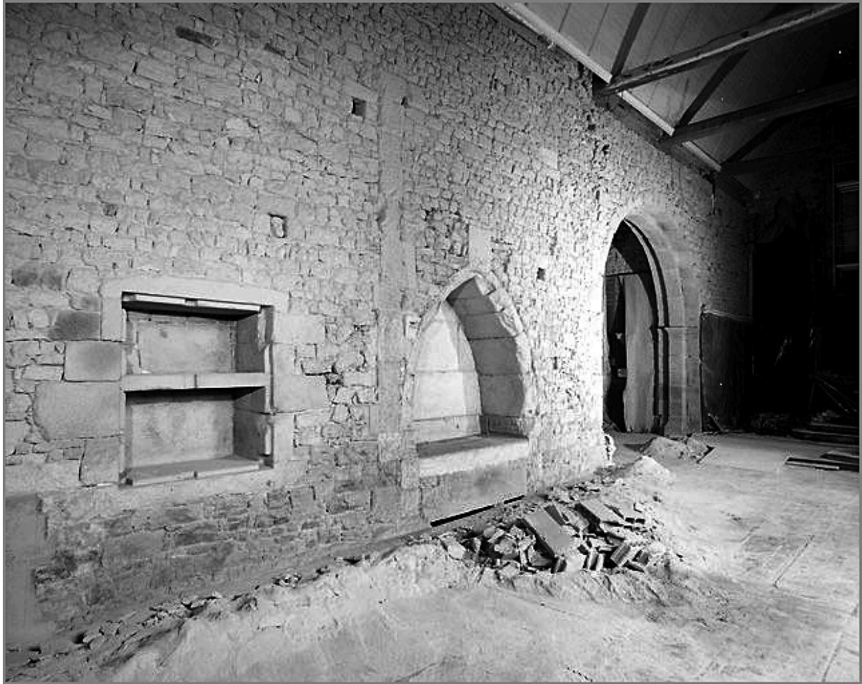
Intérieur, mur nord, partie centrale : vue générale avant restauration
