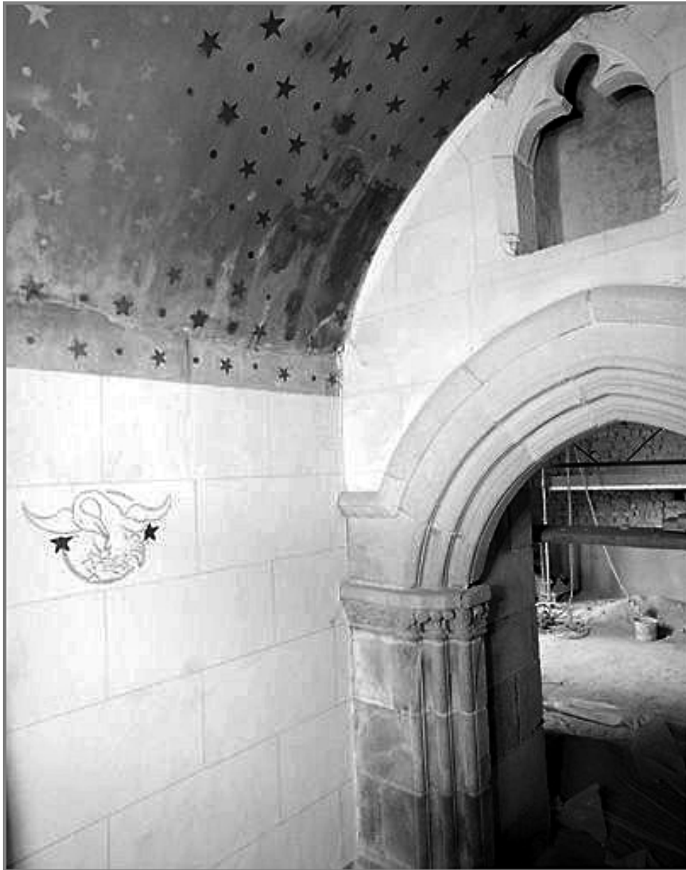
Intérieur, chapelle sud : détail de la croisée avant restauration
