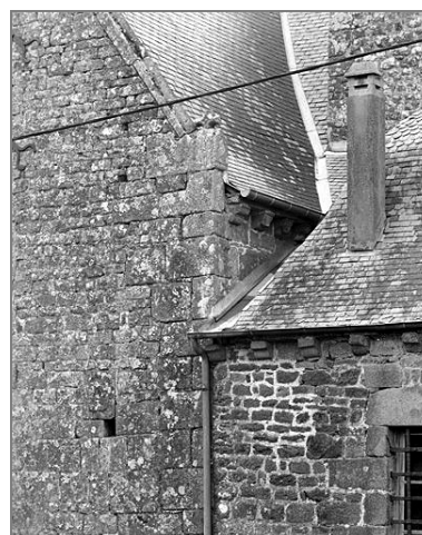
Elévation est : détail de la jonction des toitures avant restauration Phot. Bernard Bègne, Phot. M. Loyon IVR53_19923500907X
