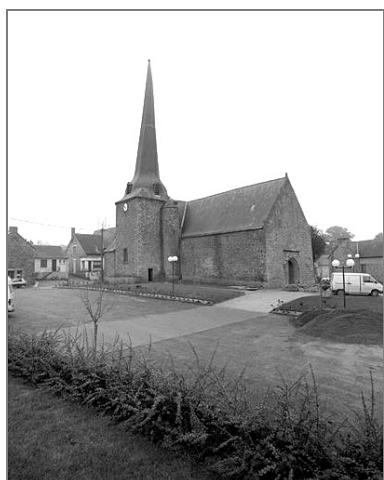
Elévation nord-ouest : vue générale avant restauration Phot. Bernard Bègne, Phot. M. Loyon IVR53_19923500905X
