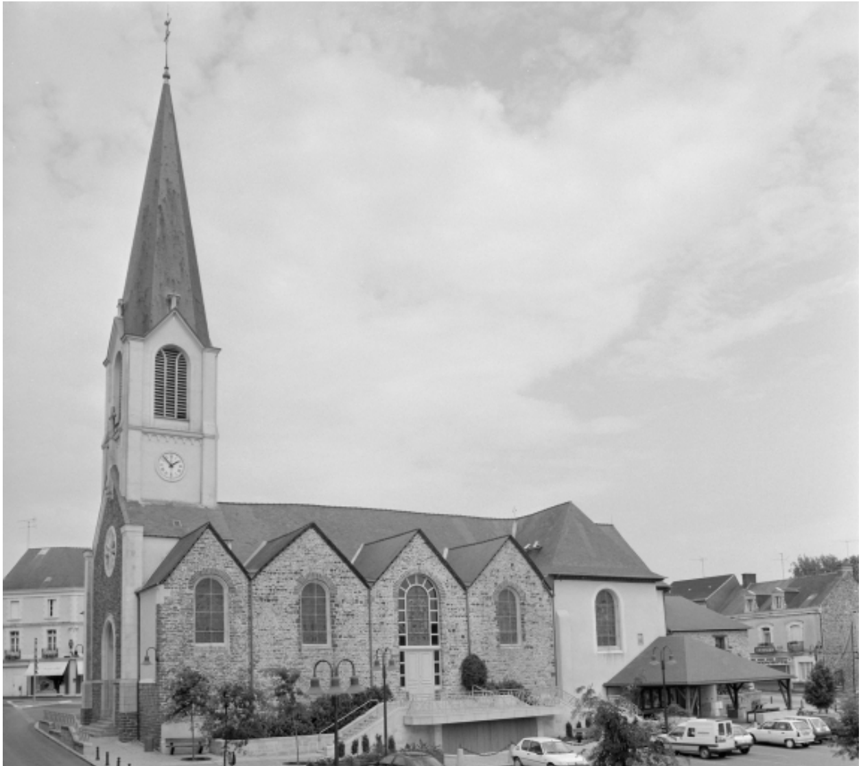
Elévation sud-ouest : vue générale
