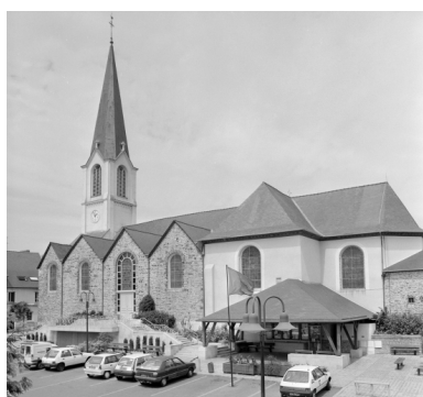
Elévation sud-est : vue générale Phot. Guy Artur, Phot. Norbert Lambart IVR53_19943501408X
