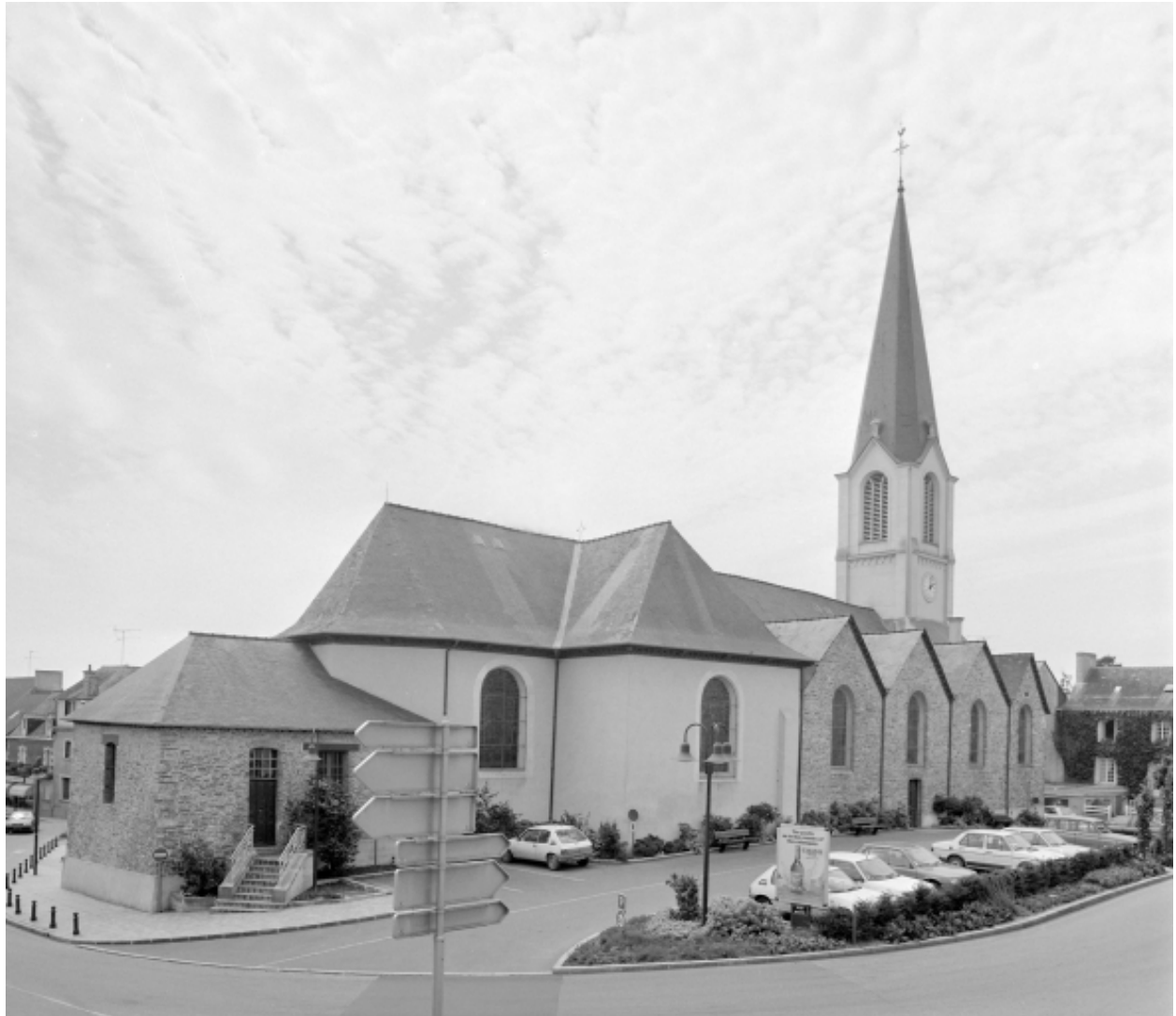
Elévation nord-est : vue générale
