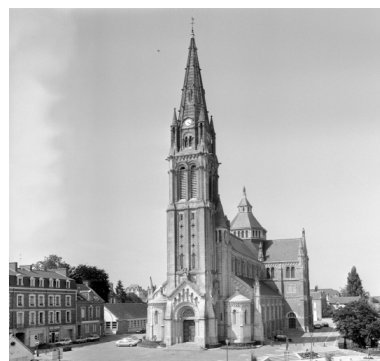
Elévation Sud : vue générale Phot. Guy Artur, Phot. Norbert Lambart IVR53_19943501428X
