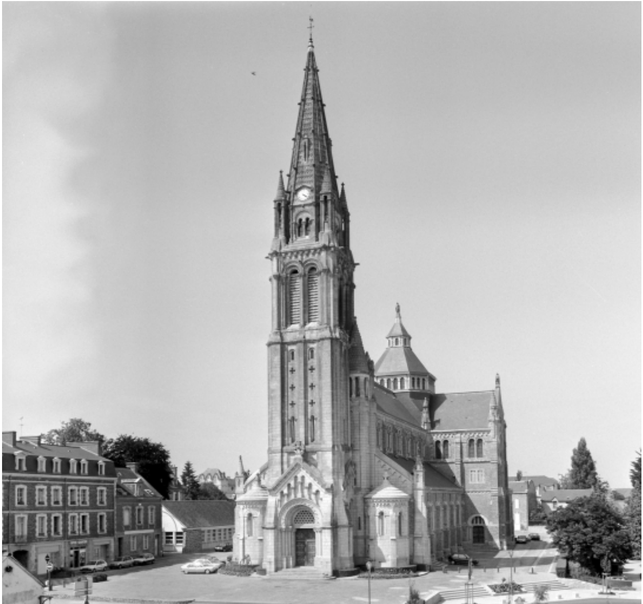
Elévation Sud : vue générale
