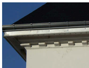
Denticules décoratifs de la corniche extérieure de la villa 3 boulevard des Plages Phot. Johan Vincent IVR53_20072909057NUCA
