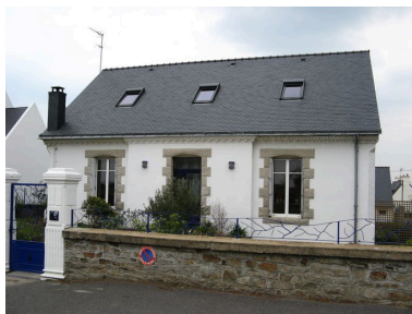
Maison et clôture d'enceinte de la villa Avel Braz Phot. Guillaume Marie IVR53_20072909065NUCA
