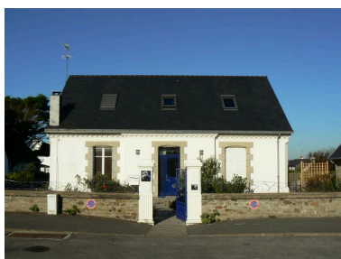
Villa Avel Braz, 17 place de l'Océan Phot. Johan Vincent IVR53_20072909062NUCA
