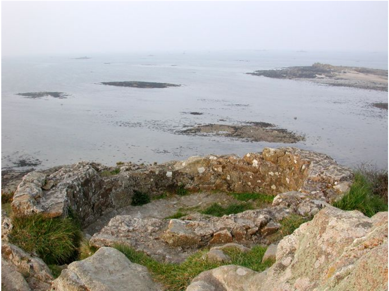
Vue du poste d'observation et de tir nord (état en 2003). Le parapet est construit en maçonnerie de moellon assemblé au ciment
