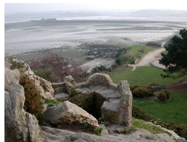
Vue du poste d'observation et de tir sud (état en 2003). Le parapet, doté de quatre merlons et de quatre créneaux, est construit en maçonnerie de moellon assemblé au ciment
