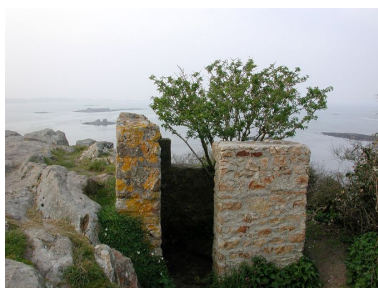
Vue de l'édicule situé au sommet du rocher de Sainte-Anne (état en 2003). Il est construit en maçonnerie de moellon assemblé au ciment (remploi d'un édifice plus ancien ?)
