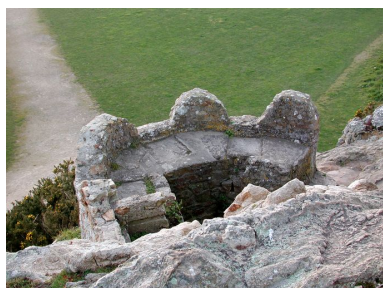
Vue du poste d'observation et de tir sud (état en 2003). Le parapet, doté de quatre merlons et de quatre créneaux, est construit en maçonnerie de moellon assemblé au ciment
