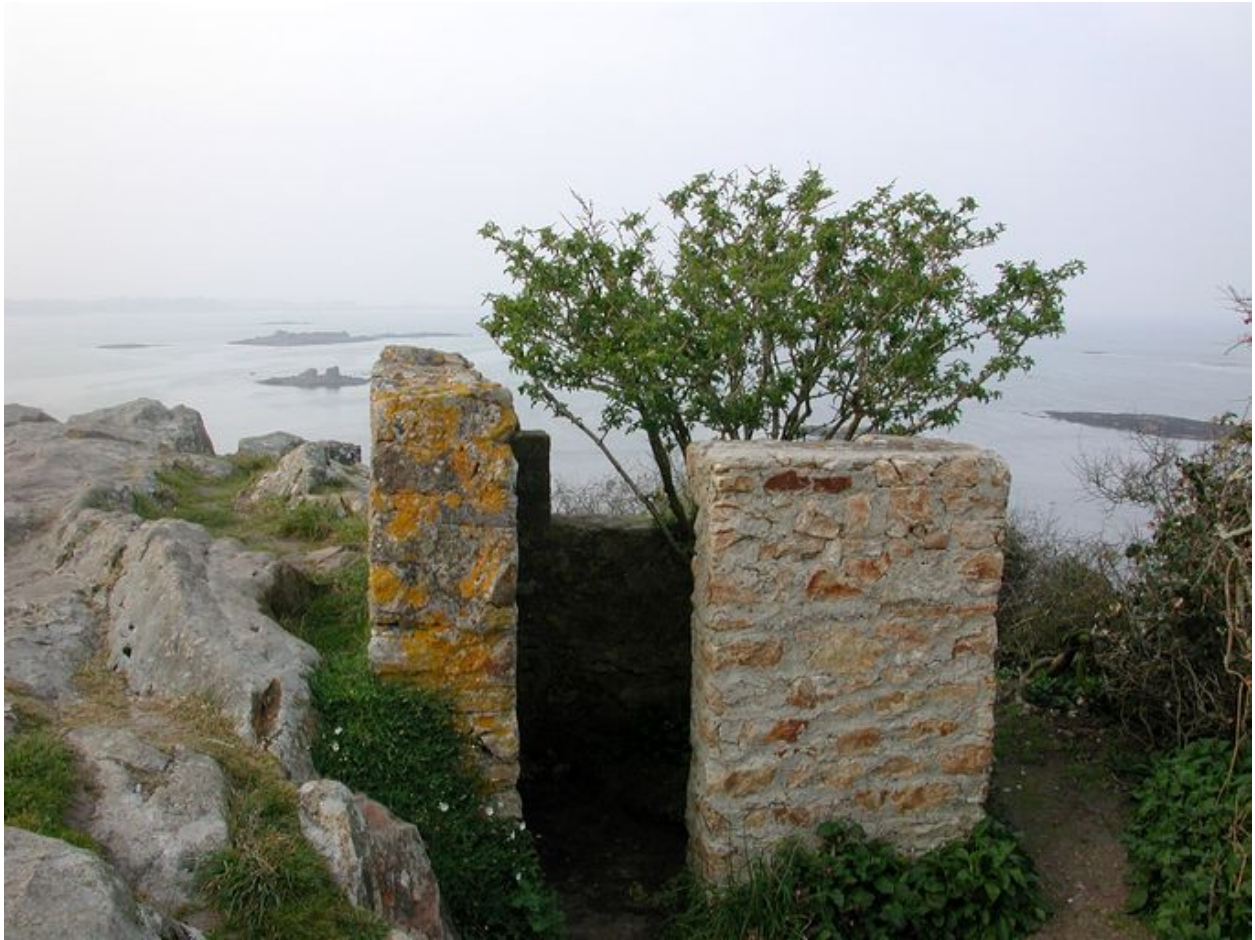
Vue de l'édicule situé au sommet du rocher de Sainte-Anne (état en 2003). Il est construit en maçonnerie de moellon assemblé au ciment (remploi d'un édifice plus ancien ?)
