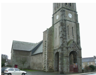
Vue nord-ouest Phot. Sabrina Dalibard IVR53_20063507162NUCA
