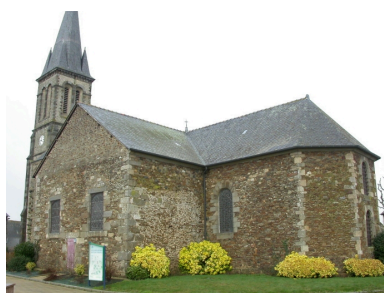
Vue sud-est Phot. Sabrina Dalibard IVR53_20063507161NUCA
