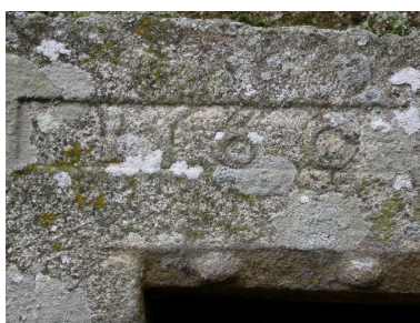
Date portée (1560) sur le linteau de la porte du transept nord Phot. Sabrina Dalibard IVR53_20063507168NUCA
