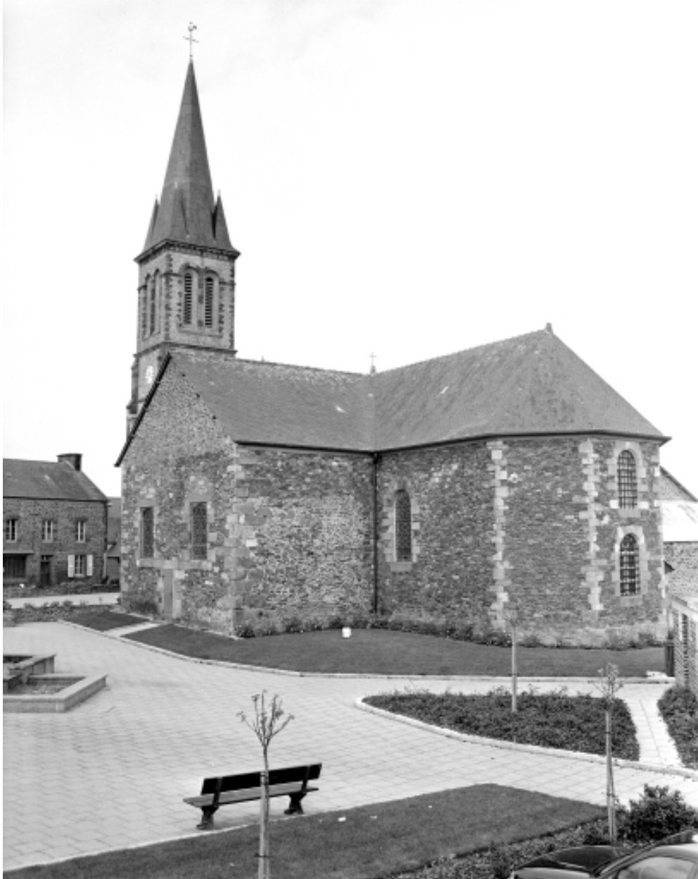
Elévation Sud-Est : vue générale
