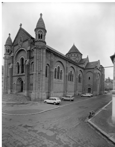
Elévation Sud-Ouest : vue générale.
