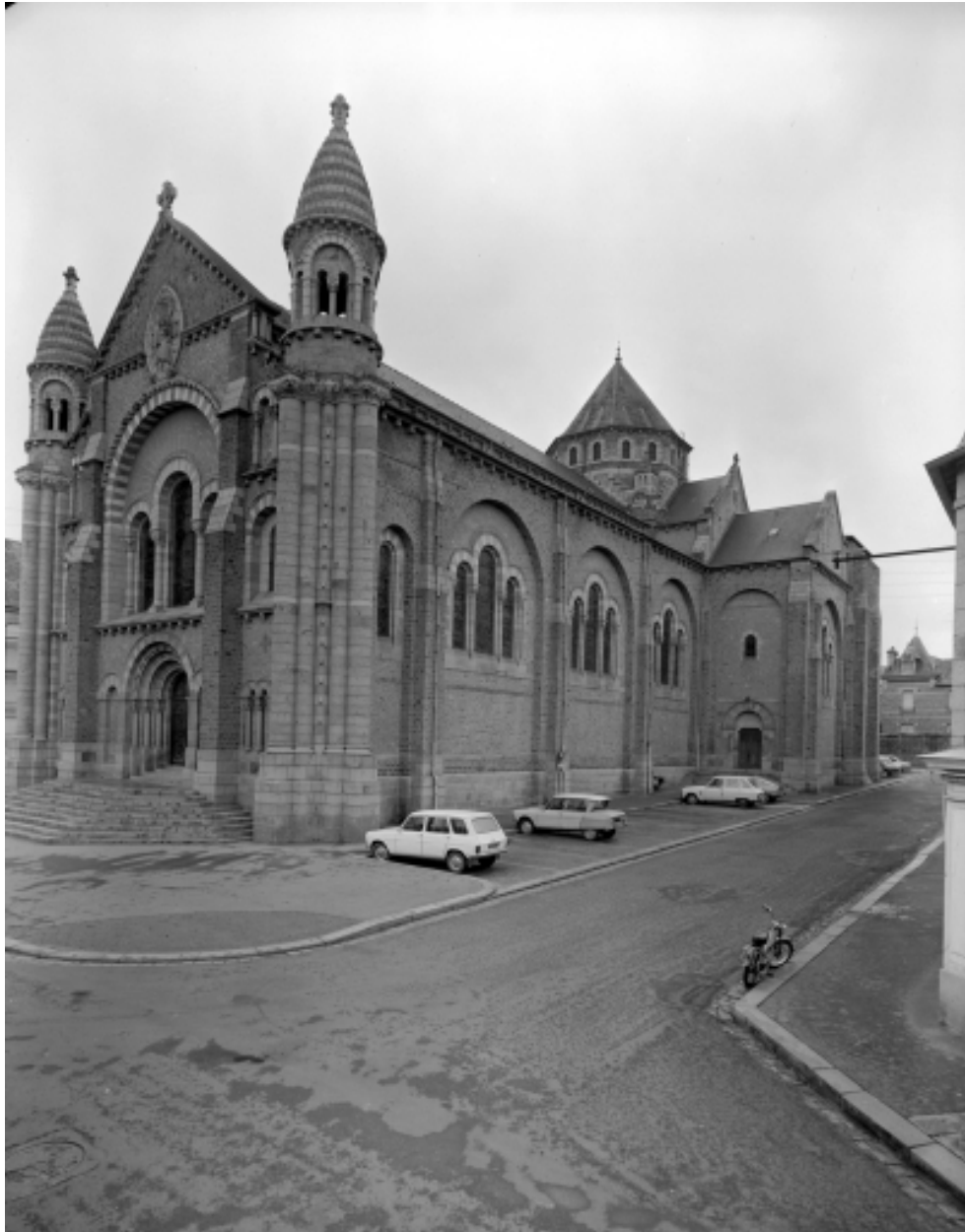
Elévation Sud-Ouest : vue générale.
