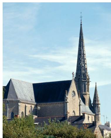
Vue générale sud-ouest Phot. Guy Artur, Phot. Norbert Lambart IVR53_20013502050XA
