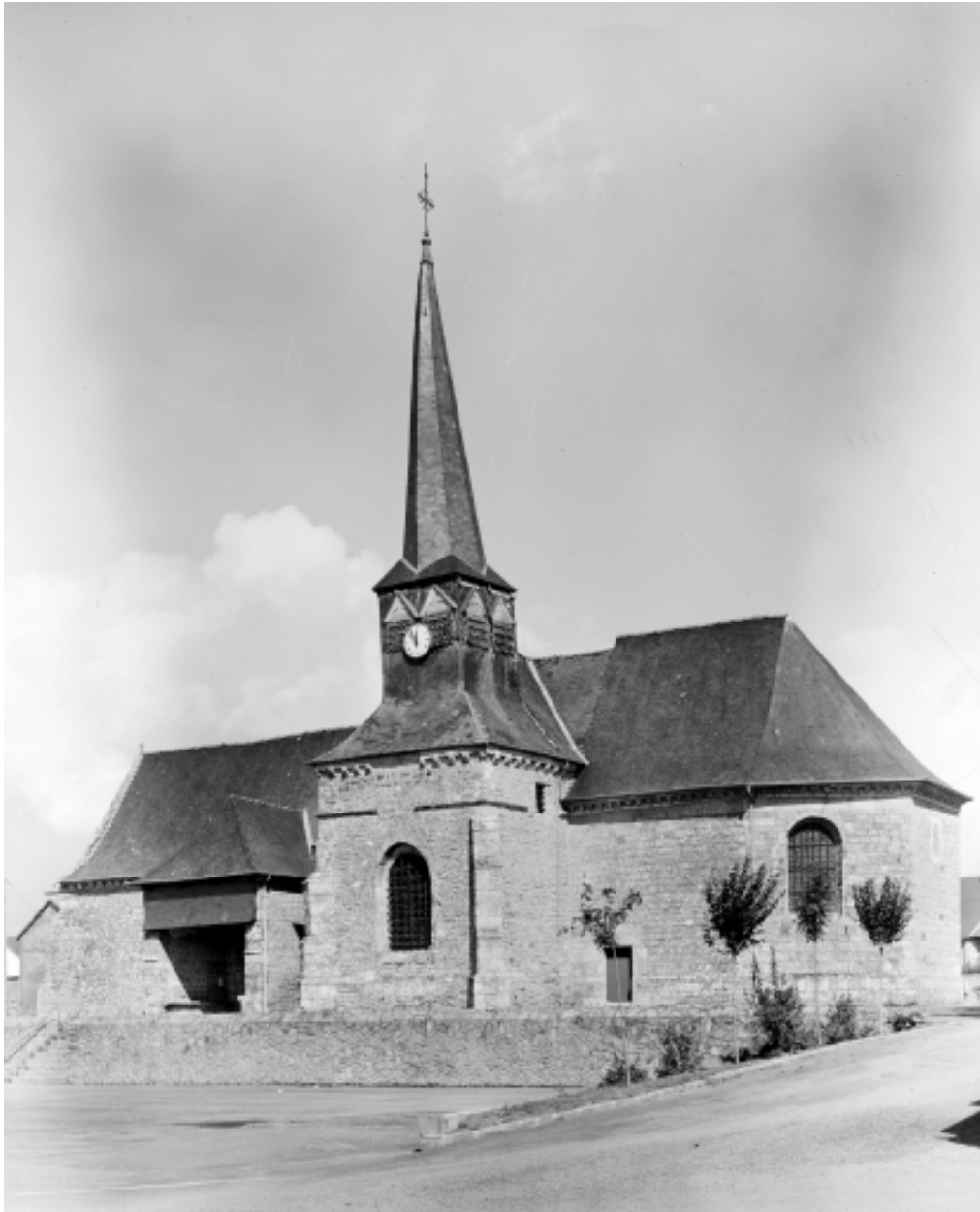
Elévation sud-est : vue générale
