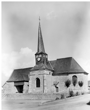
Elévation sud-est : vue générale Phot. L. Lamandé IVR53_19853501276V
