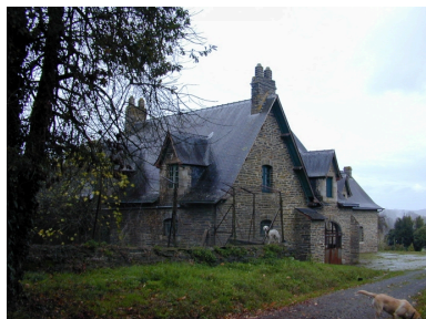
Vue du bâtiment des écuries et remises Phot. Malo Pichot IVR53_20003513235NUCA
