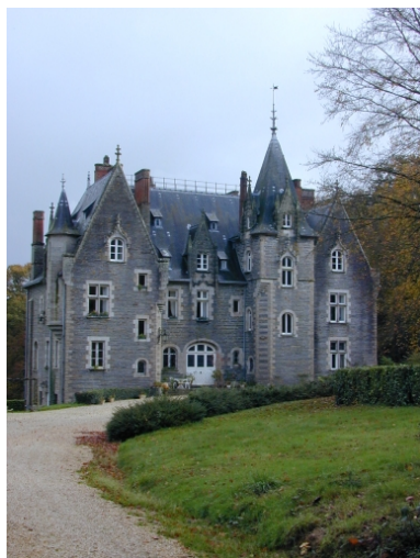
Vue générale nord-ouest Phot. Malo Pichot IVR53_20003513229NUC
