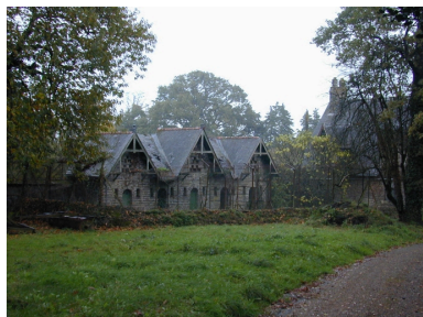
Vue du chenil et pigeonnier Phot. Malo Pichot IVR53_20003513231NUCA
