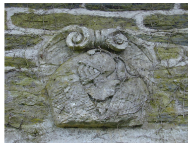
Détail d'une pierre sculptée remployée sur la remise à bois Phot. Malo Pichot IVR53_20003513234NUCA
