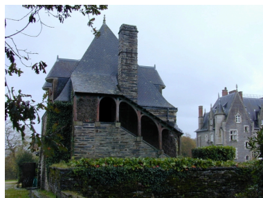
Logement et remise à automobiles Phot. Malo Pichot IVR53_20003513230NUC
