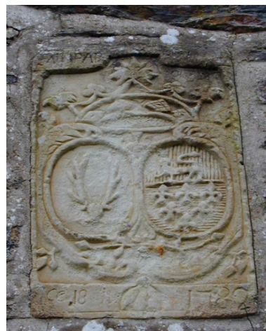
Détail d'une pierre sculptée remployée Phot. Malo Pichot IVR53_20003513232NUC
