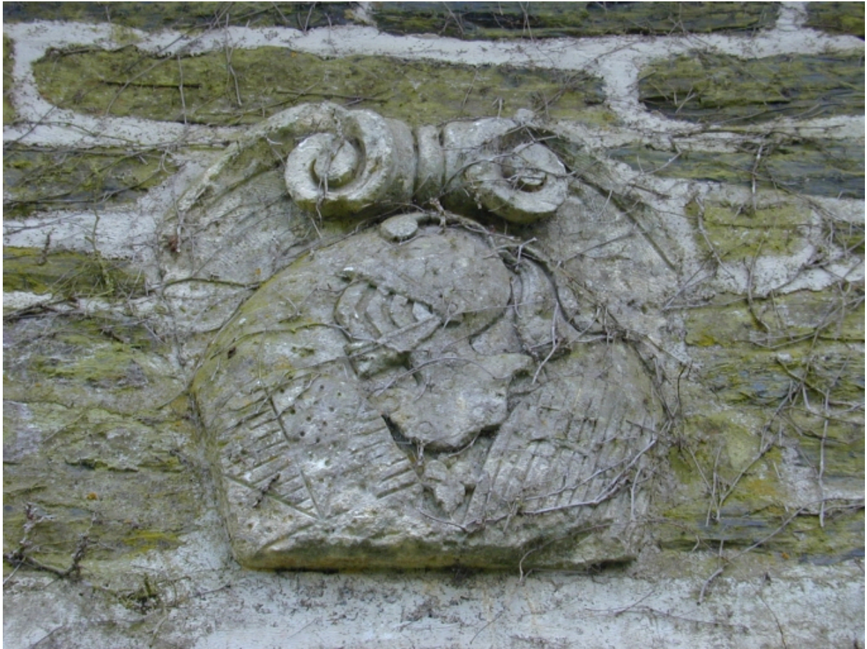
Détail d'une pierre sculptée réemployée sur la remise à bois
