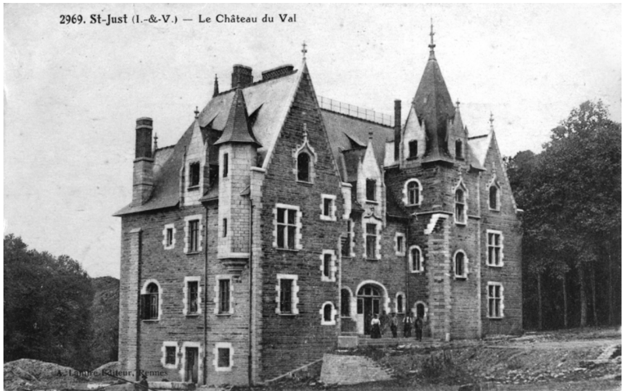
Vue générale nord-ouest
