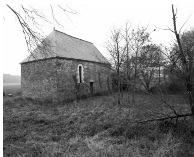
Elévation nord-est : vue générale Phot. Bernard Bègne, Phot. M. Loyon IVR53_19933500106X
