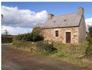
Paimpol, exemple d'habitat traditionnel au hameau de Kergoff, maison de plan massé datant probablement du milieu du 19ème siècle Phot. Patrick Pichouron IVR53_20102209305NUCA
