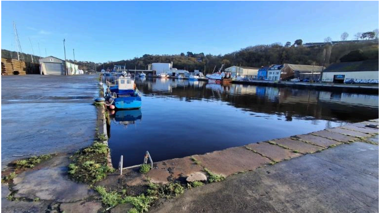
Vue générale du bassin Mézaubran
