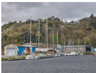
Bateaux de plaisance au nord du quai de la presqu'île, bâtiments liés à l'activité portuaire et commerciale Phot. Bernard Bègne IVR53_20262200217NUCA
