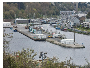
Vue générale du bassin Mézaubran, du quai de la presqu'île et du port de plaisance Phot. Bernard Bègne IVR53_20262200211NUCA
