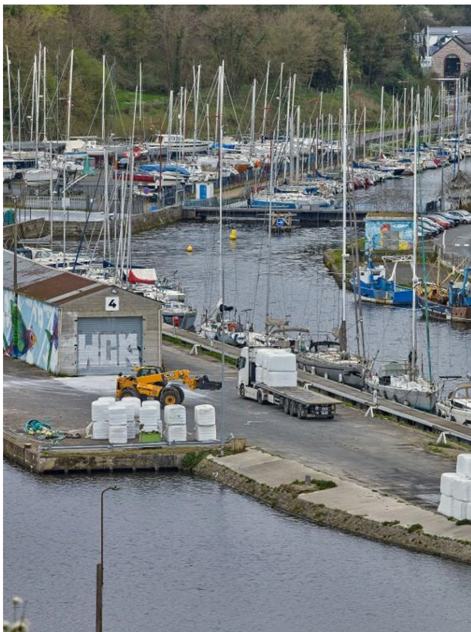
Vue du bassin de Mézaubran, du pont-tournant et du port de plaisance
