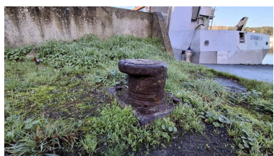
Bitte d'amarrage et traces d'usure Phot. Erwana L'Haridon IVR53_20262210252NUCA
