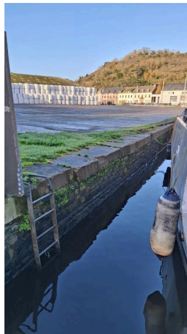
Maçonnerie du quai Travers Phot. Erwana L'Haridon IVR53_20262210255NUCA
