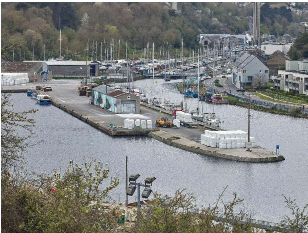
Vue générale du bassin Mézaubran, du quai de la presqu'île et du port de plaisance
