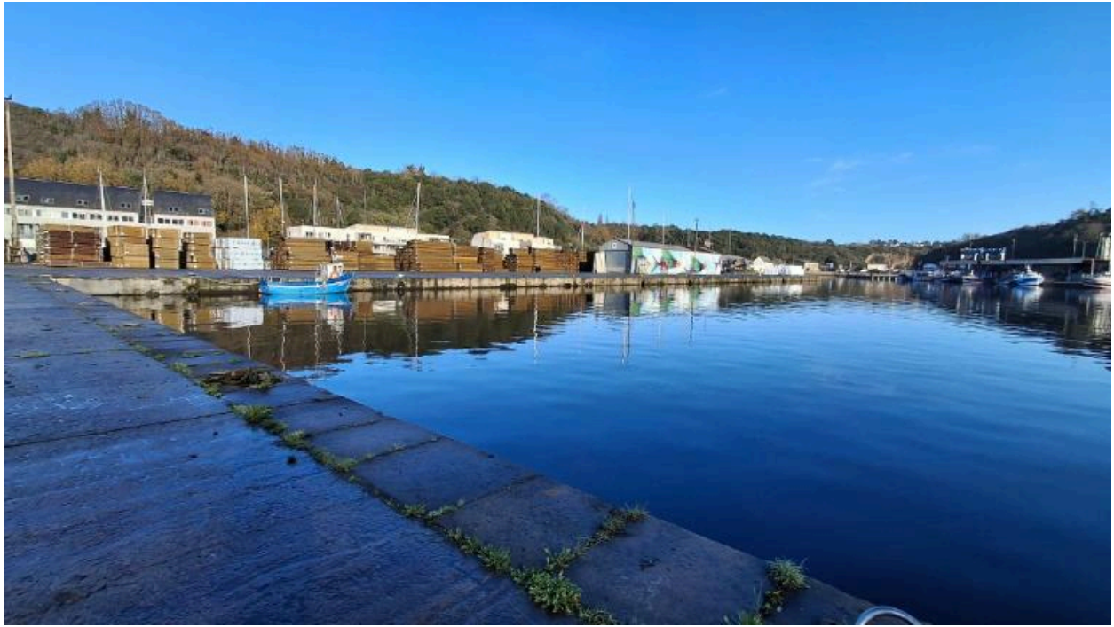
Vue générale du bassin Mézaubran
