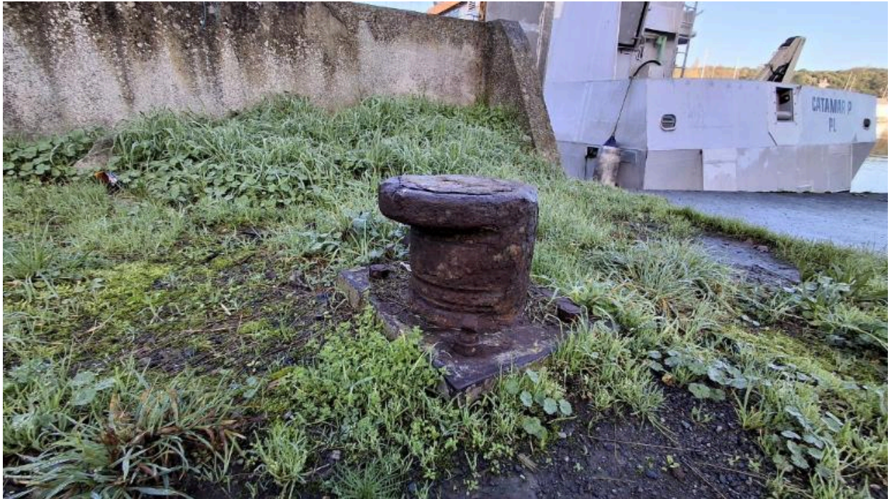
Bitte d'amarrage et traces d'usure
