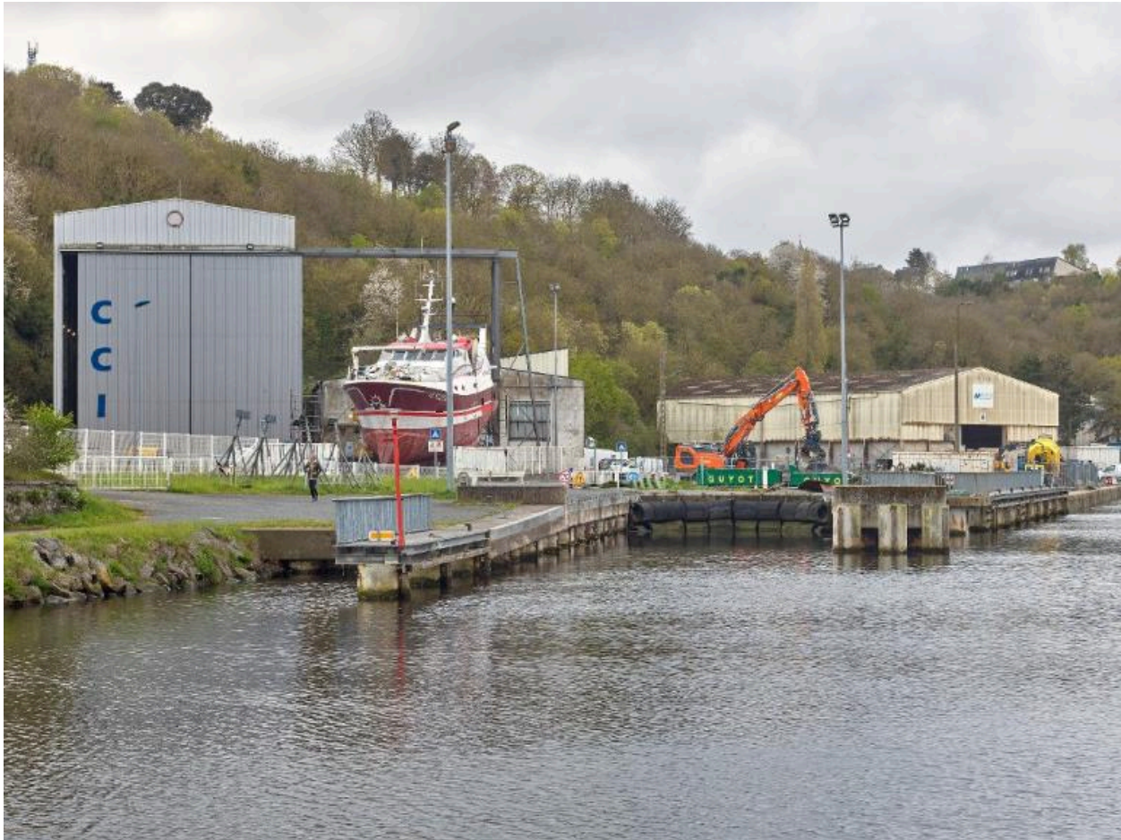
Darse de l'aire de réparation navale
