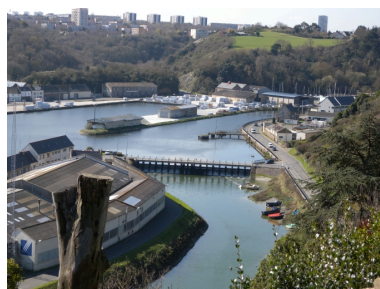
Vue du bassin de Mézaubran, du quai Surcouf, de l'île sèche et du barrage-déversoir en 2008 Phot. Guy Prigent IVR53_20082212984NUCA
