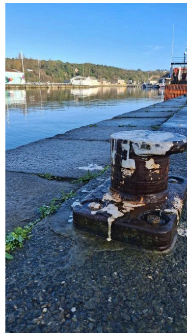
Bitte d'amarrage et traces d'usure Phot. Erwana L'Haridon IVR53_20262210256NUCA
