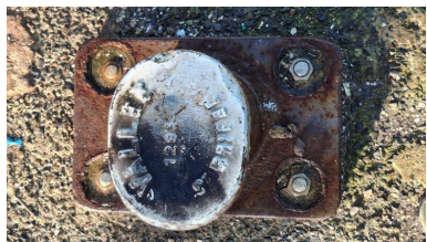
Bitte d'amarrage : entreprise VALLEE St-BRIEUC (fonderie de fonte et de cuivre installée à St-Brieuc) Phot. Erwana L'Haridon IVR53_20262210244NUCA
