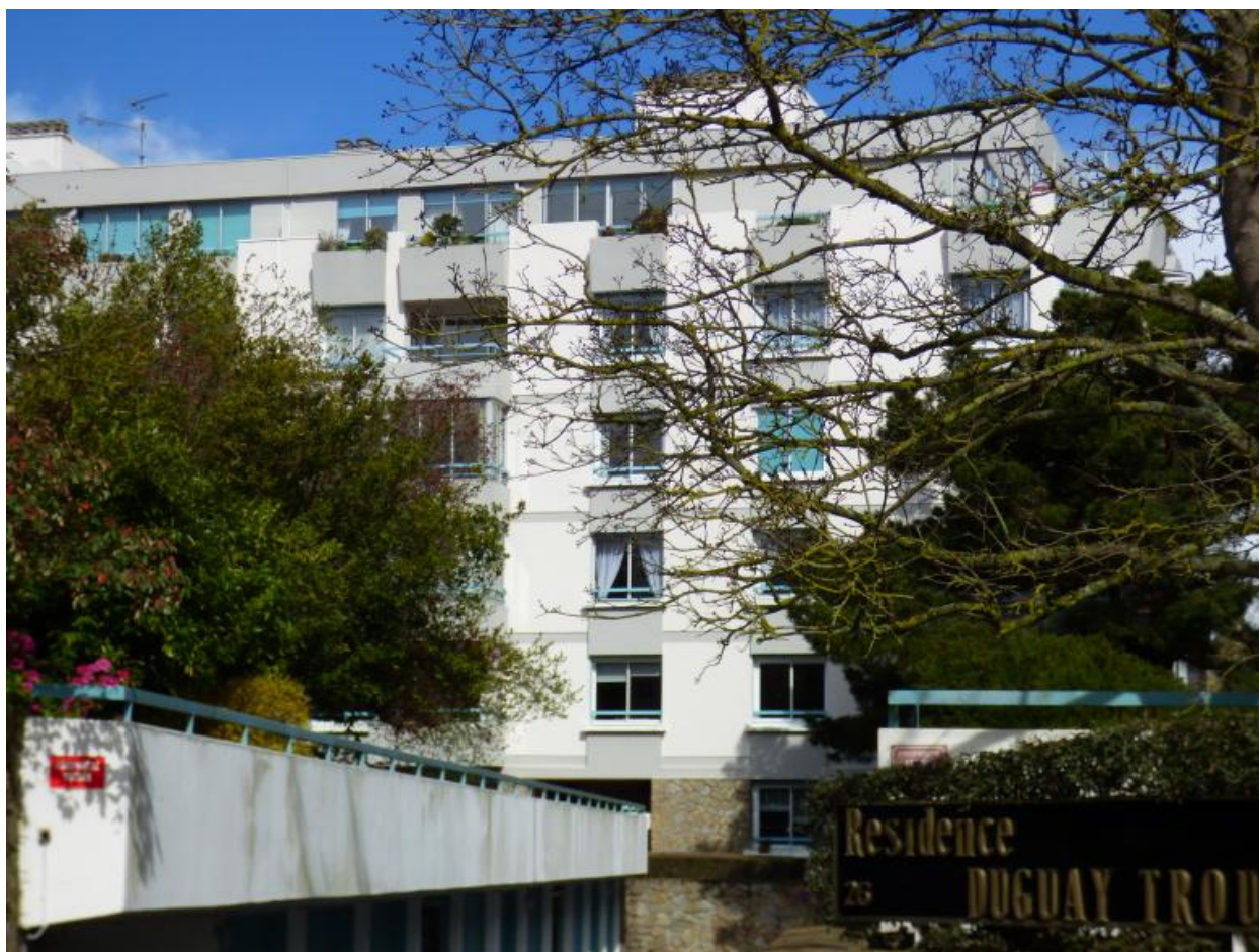
Vue d'ensemble depuis la voie d'accès privative
