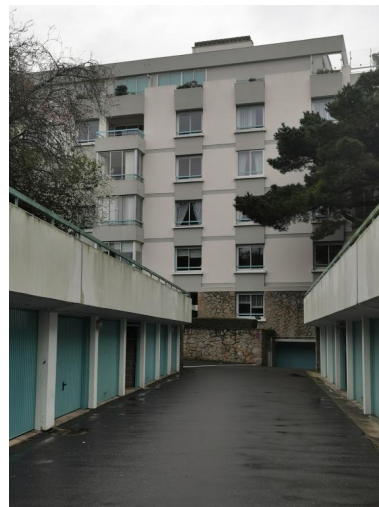
Vue de la voie privative avec les garages de part et d'autre Phot. Eve Pellat Pagé IVR53_20222206046NUCA
