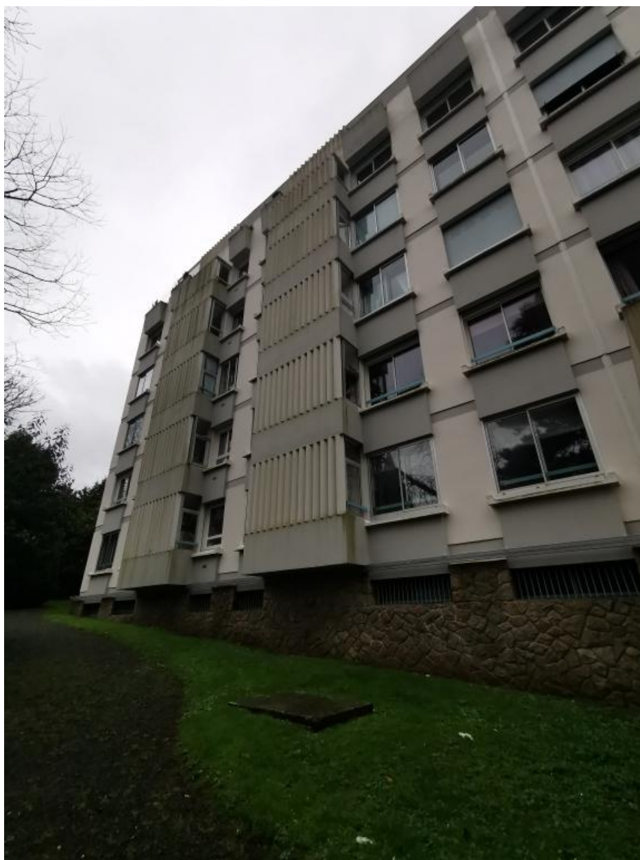
Vue de la façade côté nord
