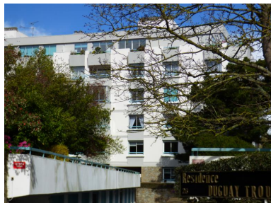
Vue d'ensemble depuis la voie d'accès privative Phot. Eve Pellat Pagé IVR53_20222206062NUCA
