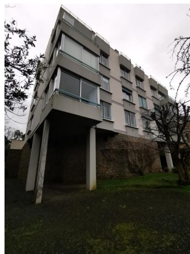
Vue des pilotis côté ouest Phot. Eve Pellat Pagé IVR53_20222206056NUCA
