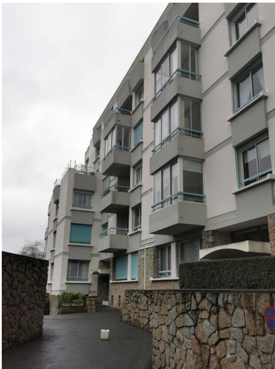
Vue de la façade sud avec le soubassement en granit
