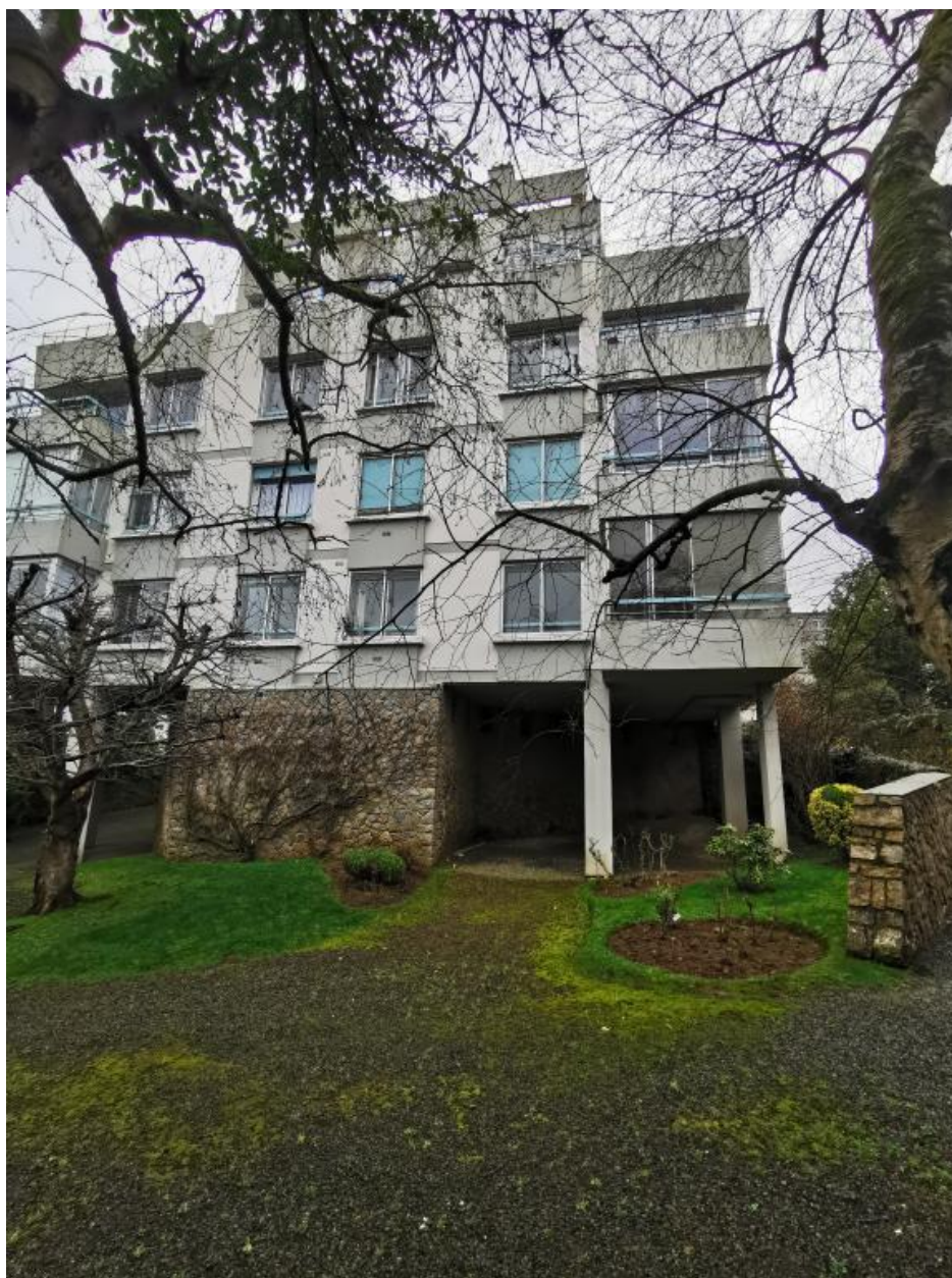
Vue de la façade ouest sur pilotis
