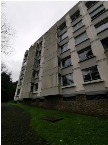
Vue de la façade côte nord Phot. Eve Pellat Pagé IVR53_20222206057NUCA
