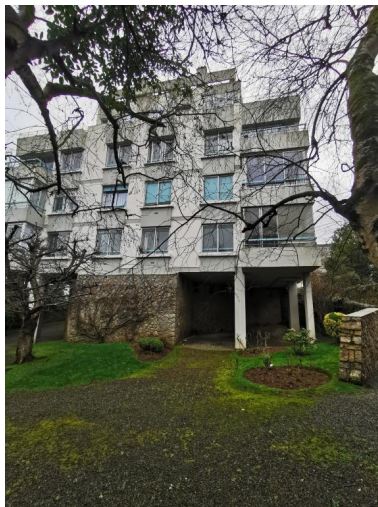
Vue de la façade ouest sur pilotis Phot. Eve Pellat Pagé IVR53_20222206055NUCA
