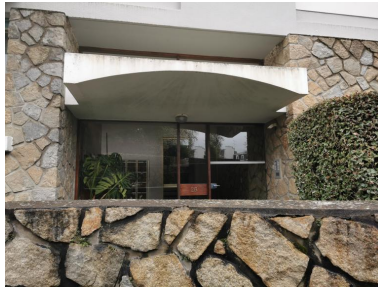
Vue de détail d'un des 2 halls d'entrée Phot. Eve Pellat Pagé IVR53_20222206050NUCA
