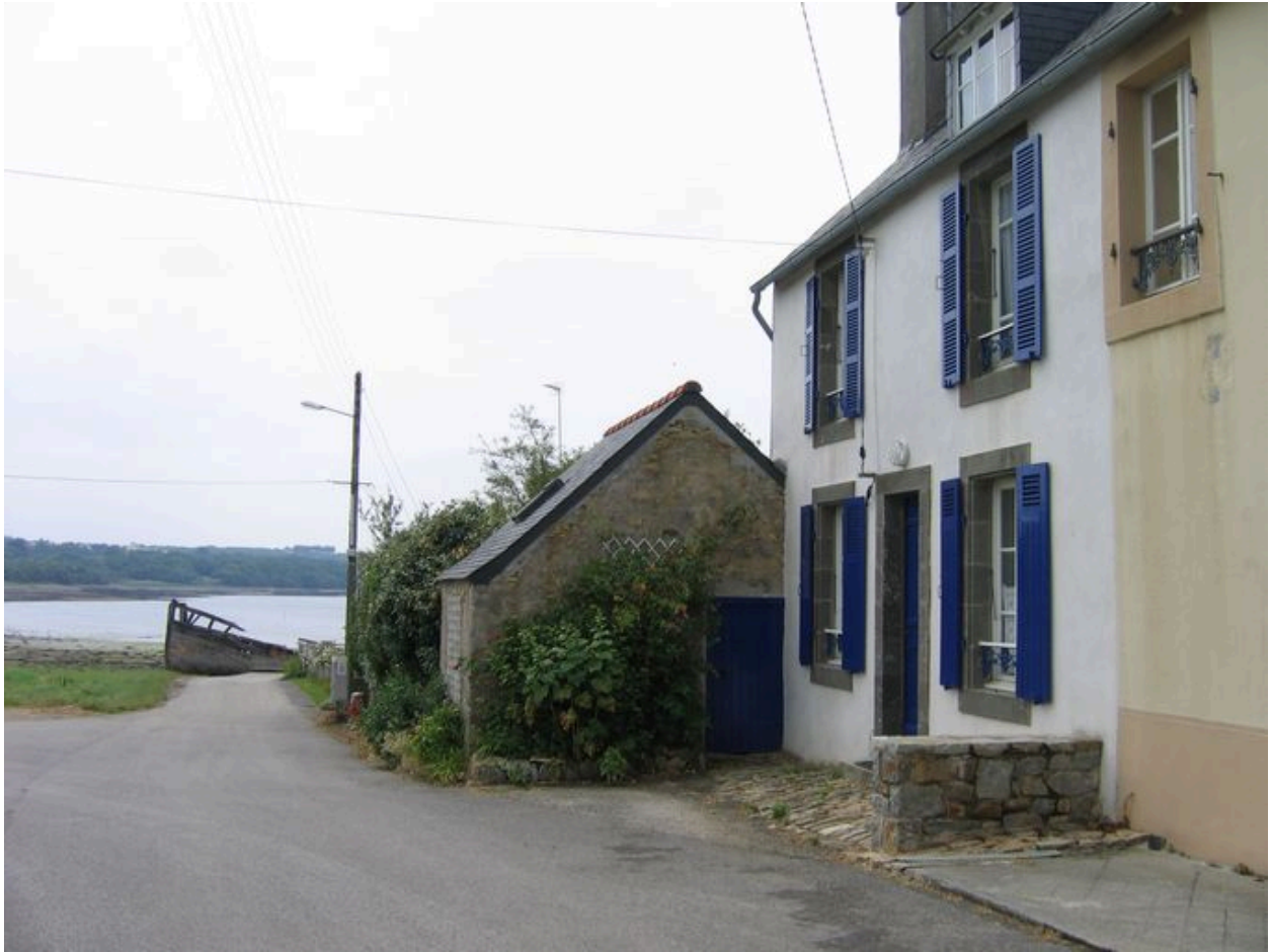
Maison du front de mer de Rostellec
