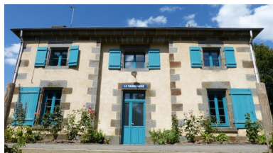
Vue sud Phot. Laurence Marquet IVR53_20243531614NUCA
