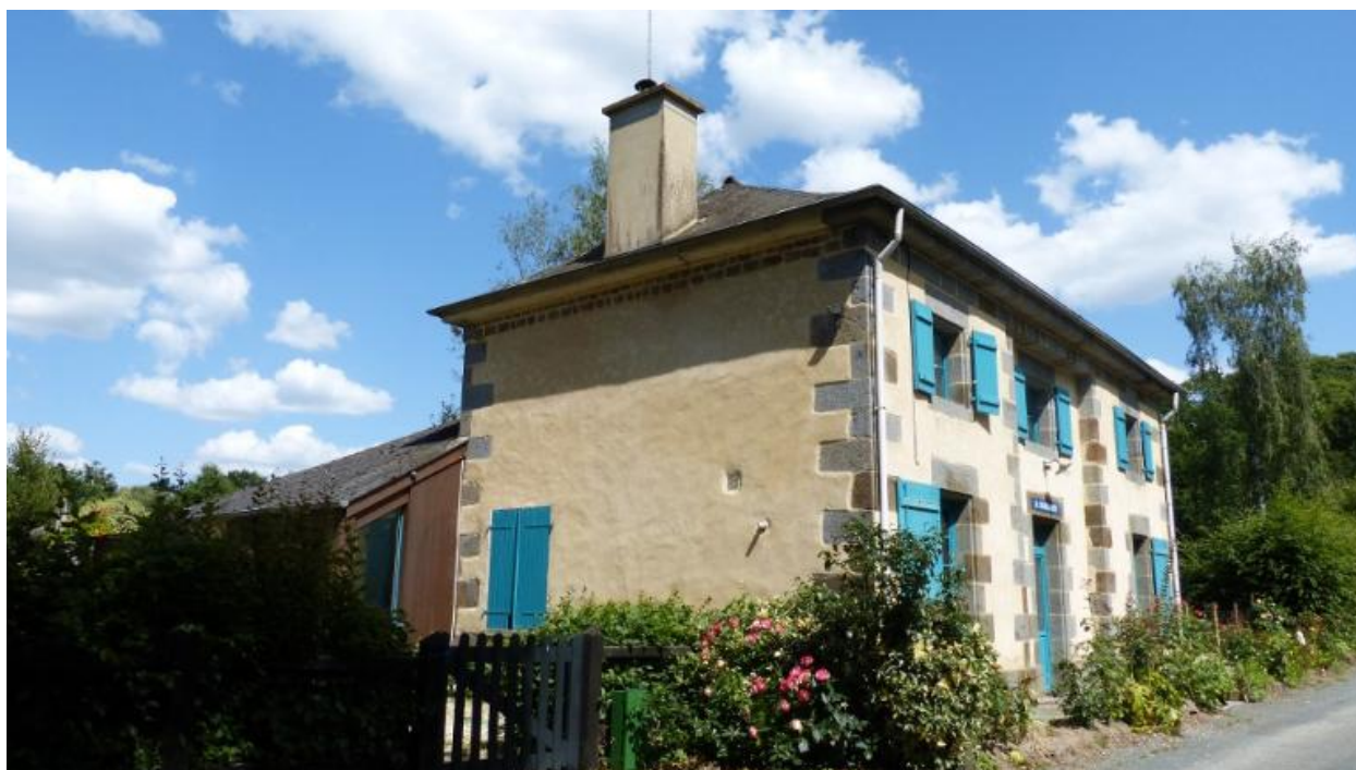
Vue sud ouest
