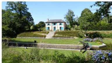
Vue sud Phot. Laurence Marquet IVR53_20243531612NUCA
