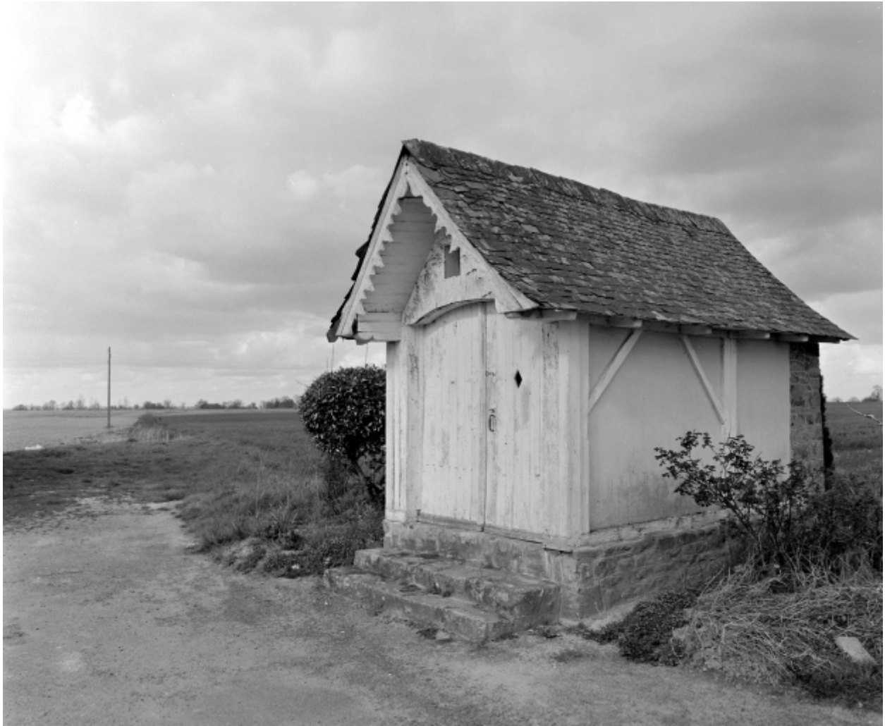
Elévation Ouest : vue générale
