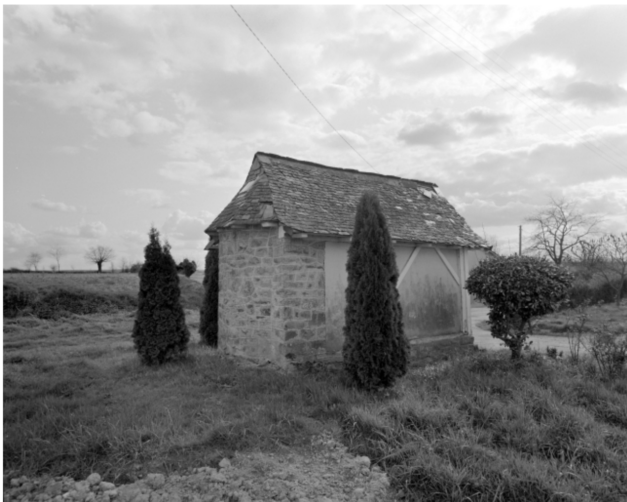
Elévation Est : vue générale
