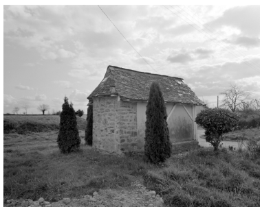
Elévation Est : vue générale Phot. Bernard Bègne, Phot. M. Loyon IVR53_19933500372X
