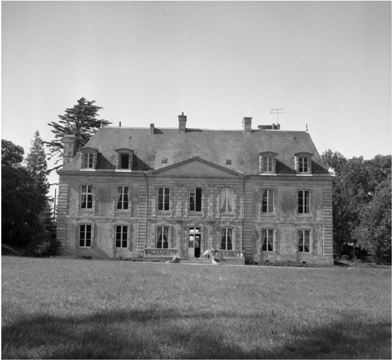
Vue générale nord, état en 1974
