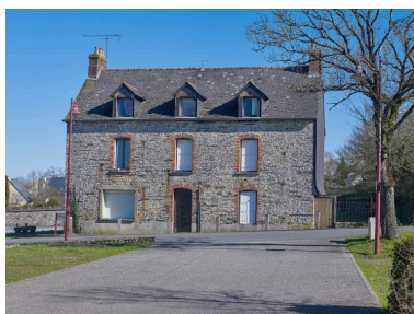
Façade ouest de la maison du 23 rue du Tertre-Gris Phot. Bernard Bègne IVR53_20263500403NUCA
