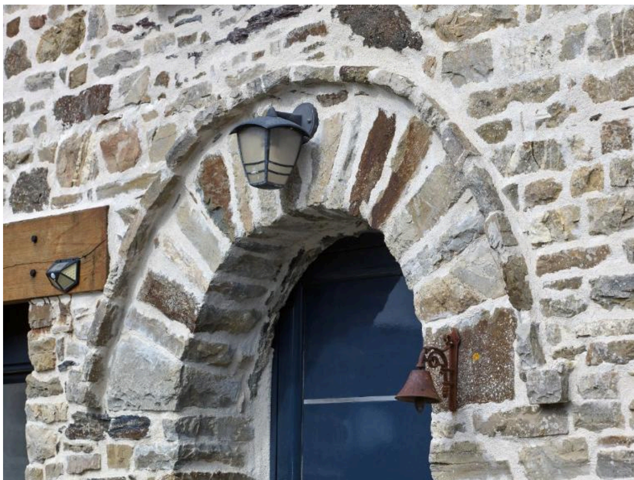
Détail du larmier au dessus de la porte du 26 La Violais
