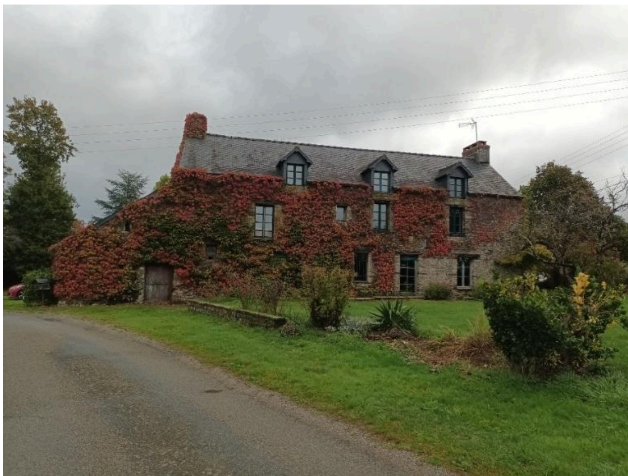
Façade du 7 La Choctière
