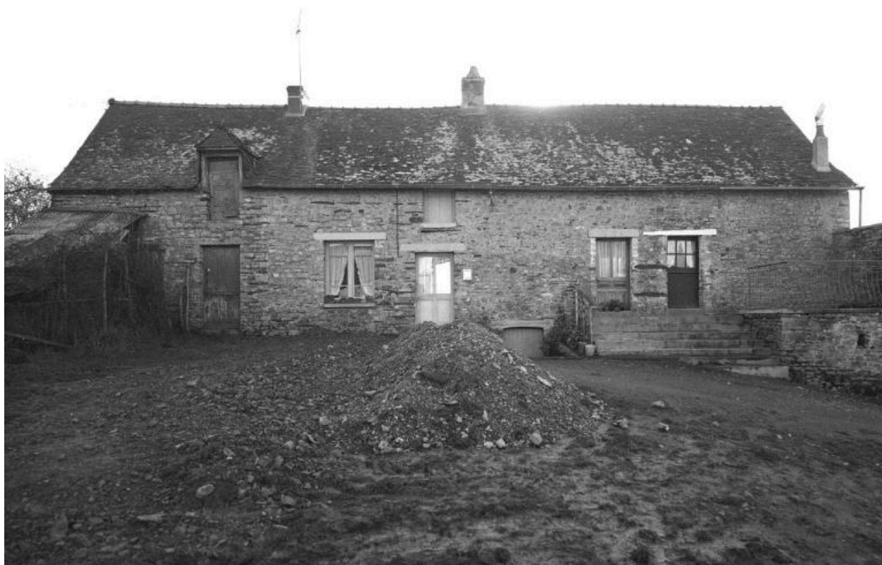
Façade du 7 rue de la Foulquière et 15 rue des Vignes, avant réhabilitation
