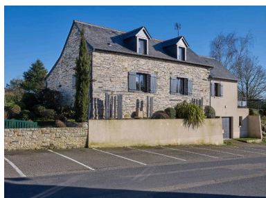
Façade ouest de la maison du 2 rue de la Mairie, après réhabilitation Phot. Bernard Bègne IVR53_20263500394NUCA
