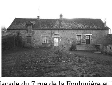
Façade du 7 rue de la Foulquière et 15 rue des Vignes, avant réhabilitation Phot. Guy Artur IVR53_19713500040V
