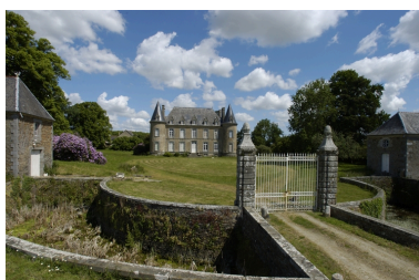
Vue générale sud Phot. Norbert Lambart IVR53_20063501169NUCA
