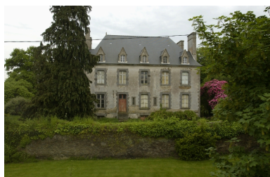
Logis ; vue générale nord Phot. Norbert Lambart IVR53_20063500966NUCA
