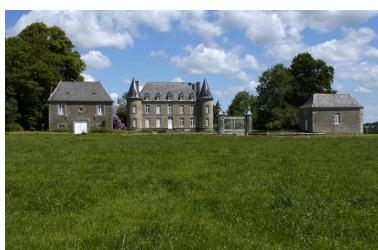
Vue générale sud Phot. Norbert Lambart IVR53_20063501174NUCA
