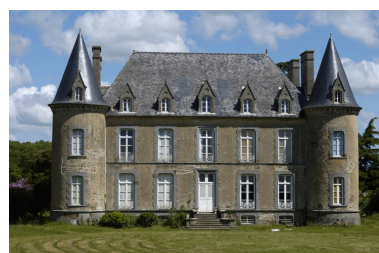
Logis ; vue générale sud Phot. Norbert Lambart IVR53_20063501170NUCA
