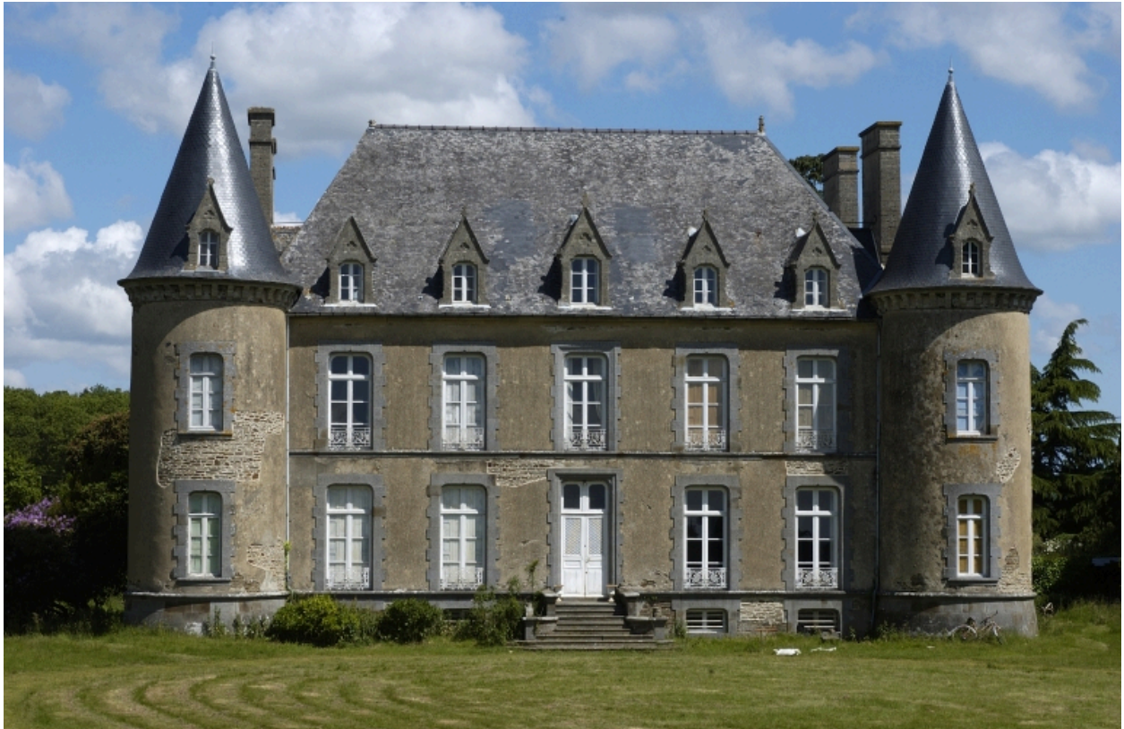
Logis ; vue générale sud
