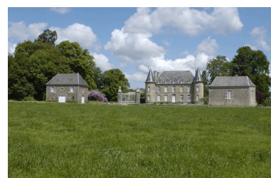
Vue générale sud Phot. Norbert Lambart IVR53_20063501175NUCA
