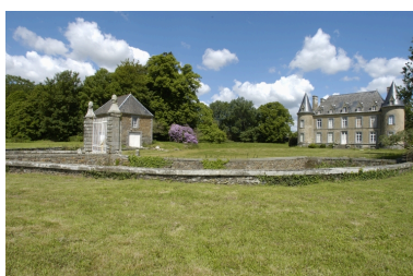
Vue partielle sud Phot. Norbert Lambart IVR53_20063501165NUCA
