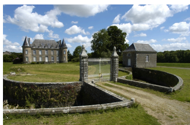
Vue générale sud Phot. Norbert Lambart IVR53_20063501168NUCA
