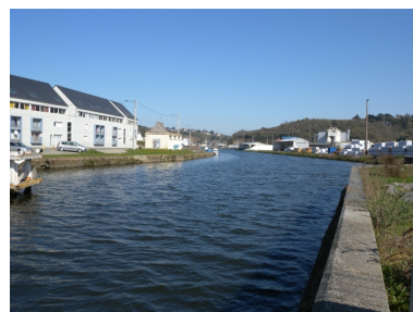
Vue du canal en amont du barrage déversoir et en aval du pont tournant Phot. Guy Prigent IVR53_20082212965NUCA
