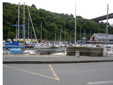
Vue du quai rive gauche du bassin à flot avec le banc traditionnel en pierre Phot. Guy Prigent IVR53_20082213118NUCA
