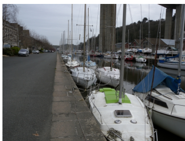
Bateaux de plaisance à couple au quai de l'Aiguillon Phot. Guy Prigent IVR53_20082212966NUCA
