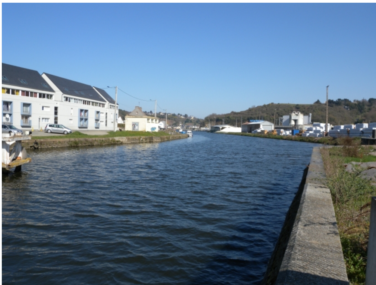
Vue du canal en amont du barrage déversoir et en aval du pont tournant
