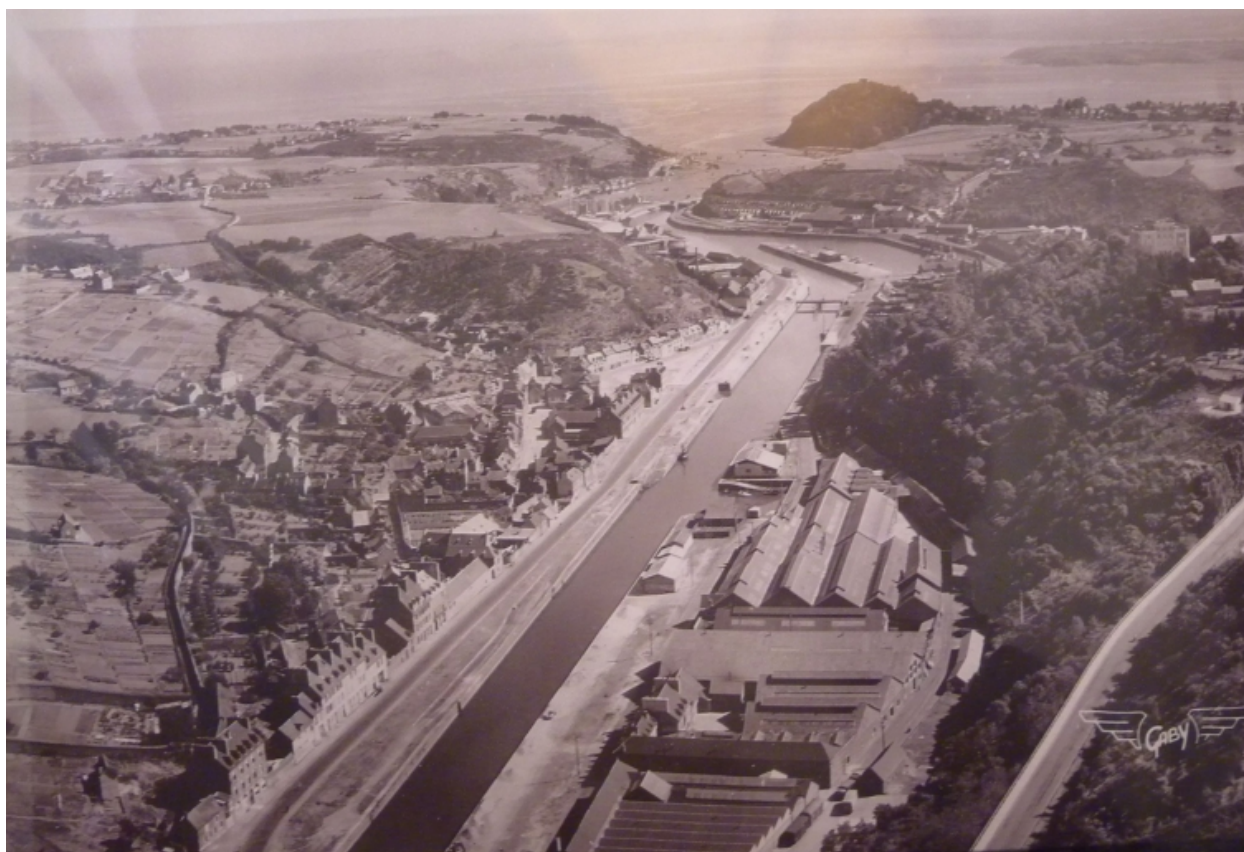
Vue aérienne : le nouveau bassin à flot du Légué vers 1950 (carte postale, collection particulière)
