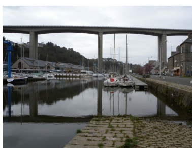
Vue de la cale amont du bassin à flot Phot. Guy Prigent IVR53_20082213006NUCA
