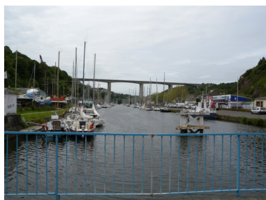
Vue en aval du bassin à flot réservé à la plaisance Phot. Guy Prigent IVR53_20082213117NUCA
