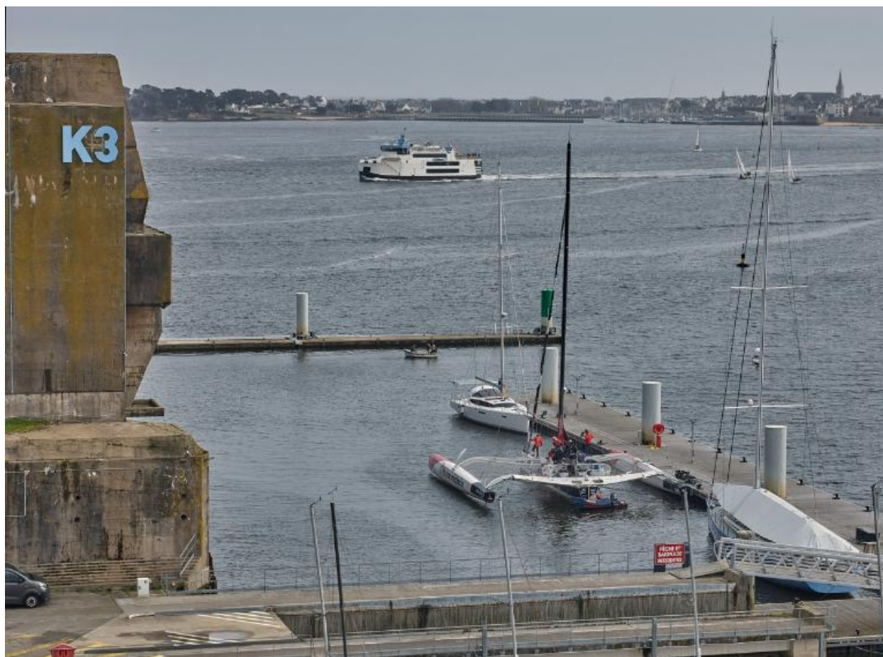
Vue de la rade de Lorient depuis la dalle de couverture du bunker Keroman I. A gauche, le bunker Keroman III
