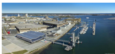
Vue aérienne oblique à basse altitude de la presqu'île de Keroman : Port de La Base de Lorient, Cité de la Voile Éric Tabarly et bunkers, 2010 (photographie : Frédéric Henry, Auteurs de Vues) Phot. Frédéric Henry IVR53_20235605336NUCA
