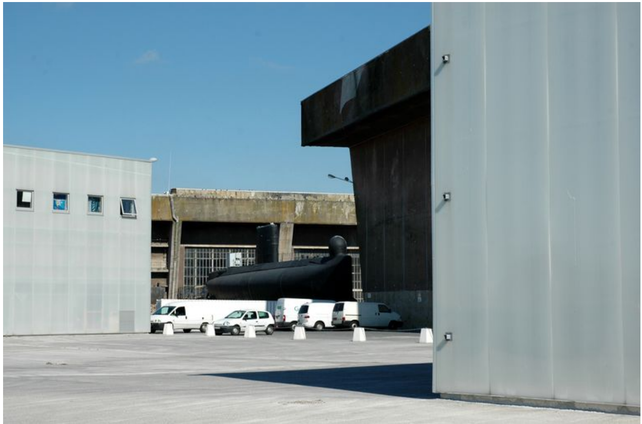
Vue du bunker "KII" entre deux docks (2005) : sur le terre-plein - plate-forme de translation - le sous-marin Flore (S645, lancé en 1960)
