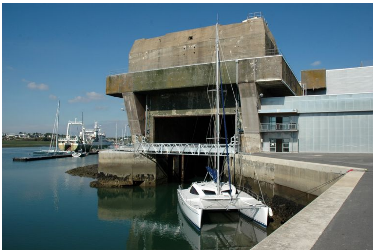
Vue de l'entrée du slipway du bunker "KI" (2005). Au premier plan, grand catamaran de croisière. A droite, flankant le bunker, docks contemporains
