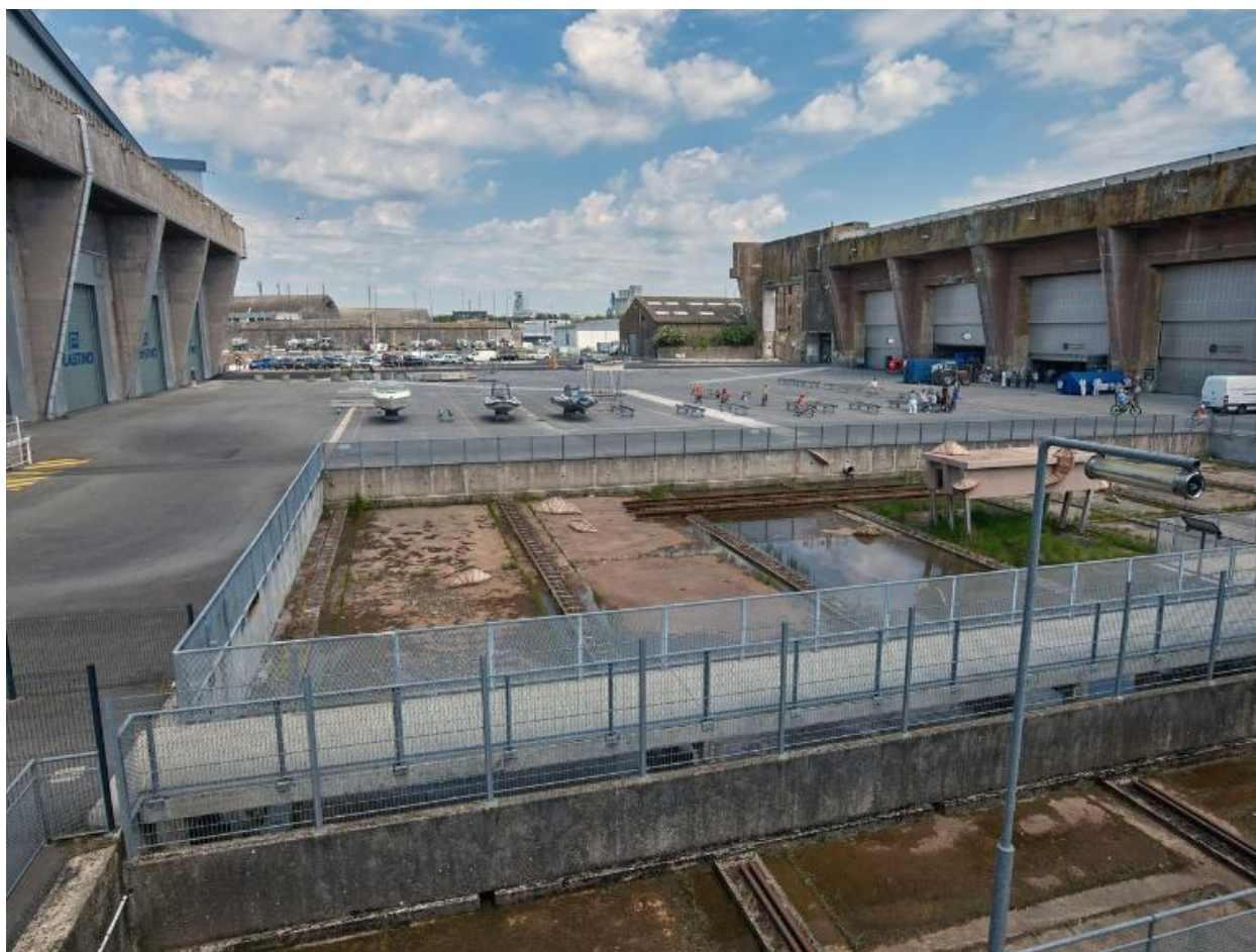
Vue du terre-plein - plate-forme de translation - situé entre les bunkers "KI" et "KII" (2021)
