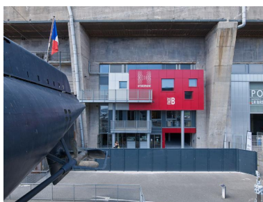
Vue de l'entrée ouest de l'alvéole "K6" du bunker "KII" abritant l'Hydrophone (2021). Cet équipement est dédié aux musiques actuelles) Phot. Bernard Bègne IVR53_20215600541NUCA
