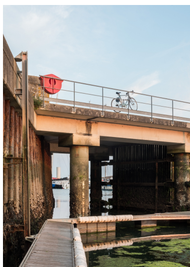
Vue de l'un des pontons Port de La Base de Lorient. A gauche, batardeau du bunker KIII Phot. Charlotte Barraud IVR53_20235600318NUCA
