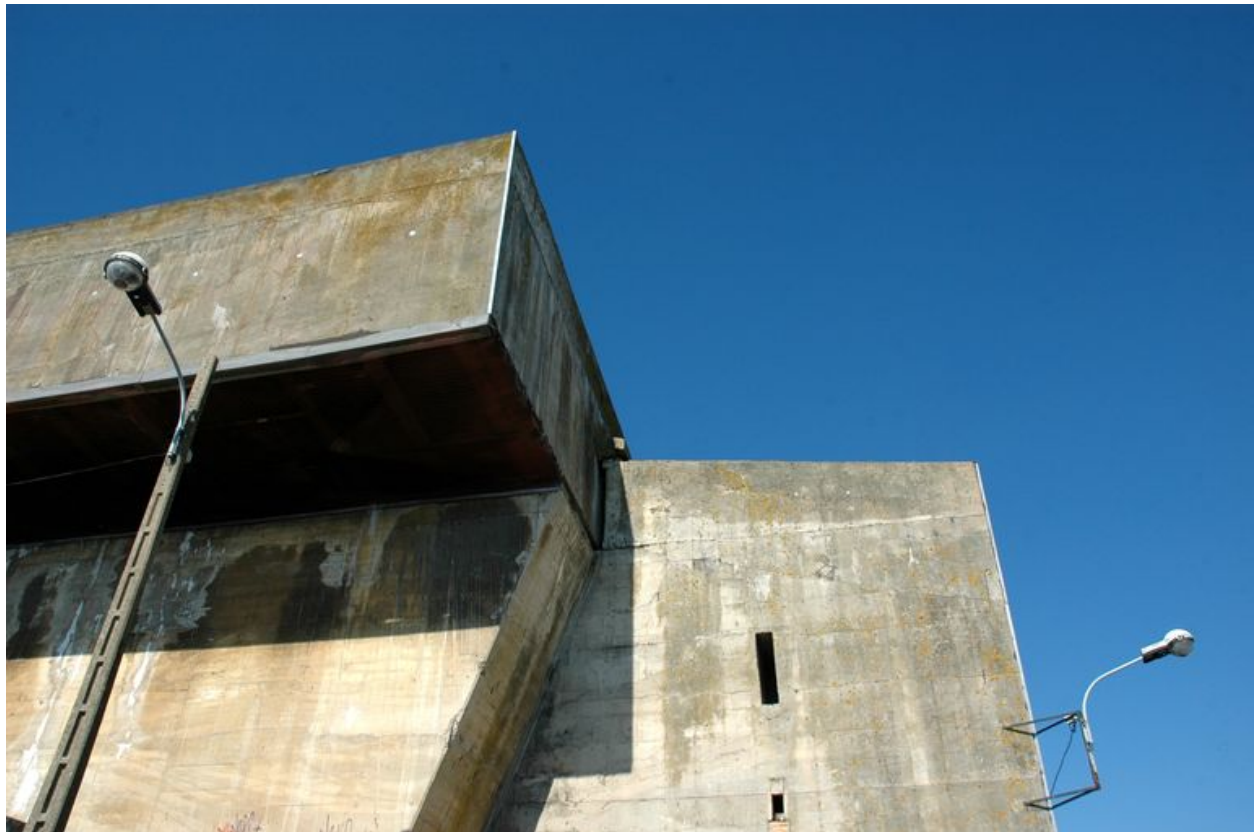
Vue de l'angle sud-est du bunker "KIII" : gigantisme du contrefort et de la dalle de couverture en béton armé (2005)
