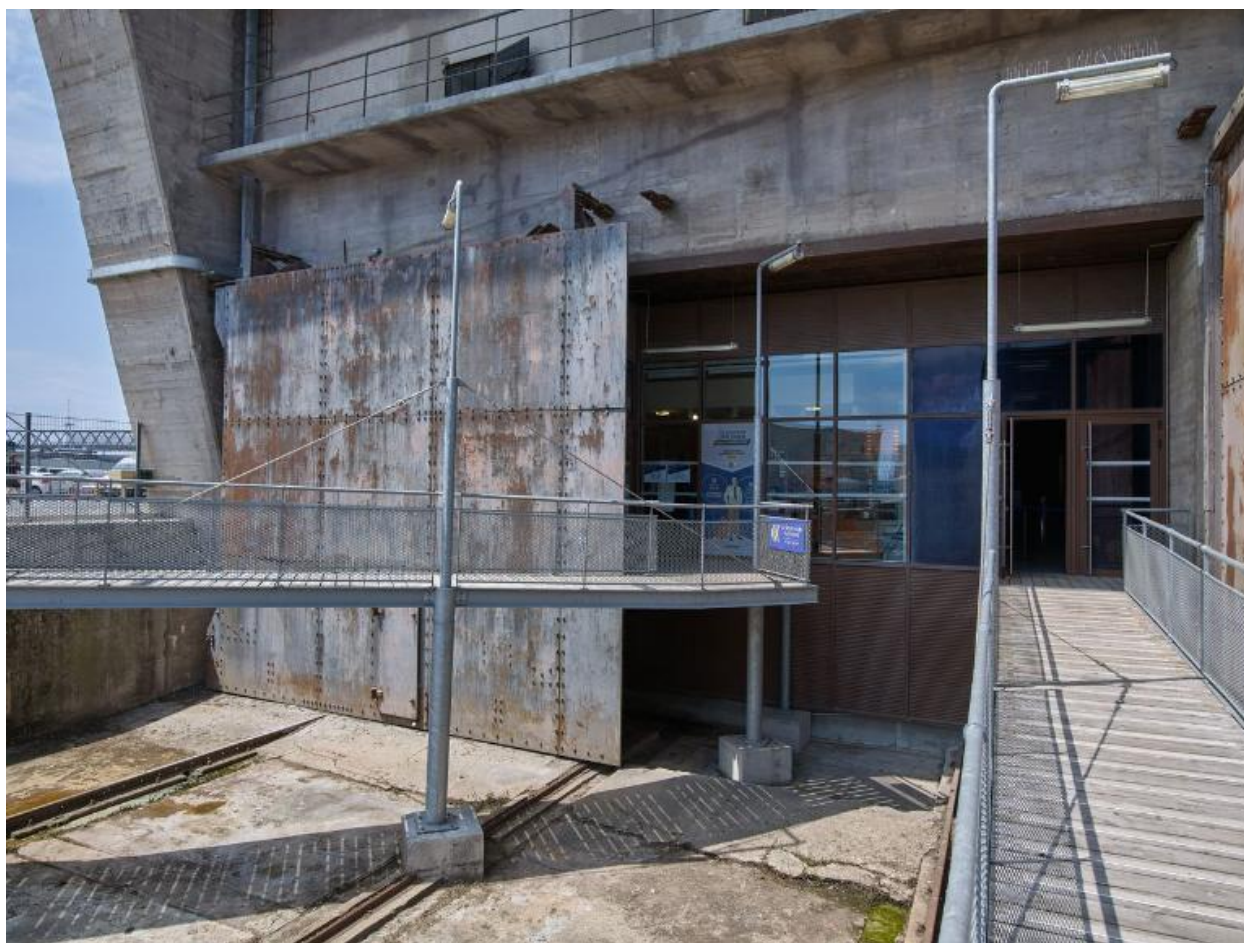
Vue du front avant du bunker "KII" : entrée de l'alvéole "K6a", portes blindées et passerelles du musée (2021)
