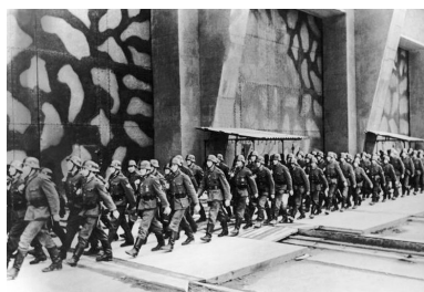
Troupes allemandes défilant devant le bunker "KII" de la base de sous-marins de Keroman, photographie de propagande nazie (fonds Keystone n° K033511). Les portes des alvéoles sont peintes en camouflage Repro. Guillaume Lécullier IVR53_20055603486NUCA
