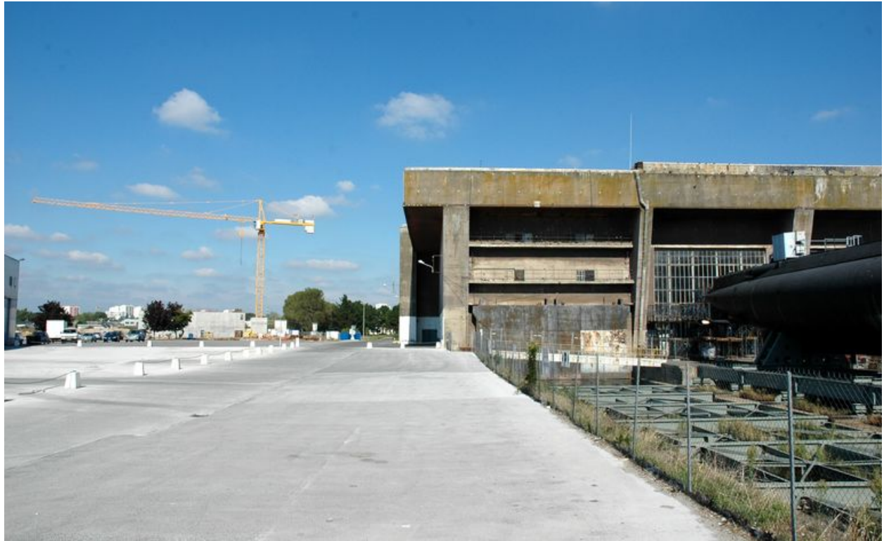
Vue de l'angle sud-ouest (front avant) du bunker "KII" : contreforts et dalle de couverture (2005). Les quatre entrées/sorties situées au premier étage de la première alvéole correspondent à la caserne dite des 1000. A droite, le sous-marin Flore (S645, lancé en 1960) sur le terre-plein - plate-forme de translation - situé entre les bunkers "KI" et "KII"
