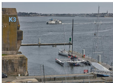
Vue de la rade de Lorient depuis la dalle de couverture du bunker Keroman I. A gauche, le bunker Keroman III Phot. Bernard Bègne IVR53_20235600254NUCA
