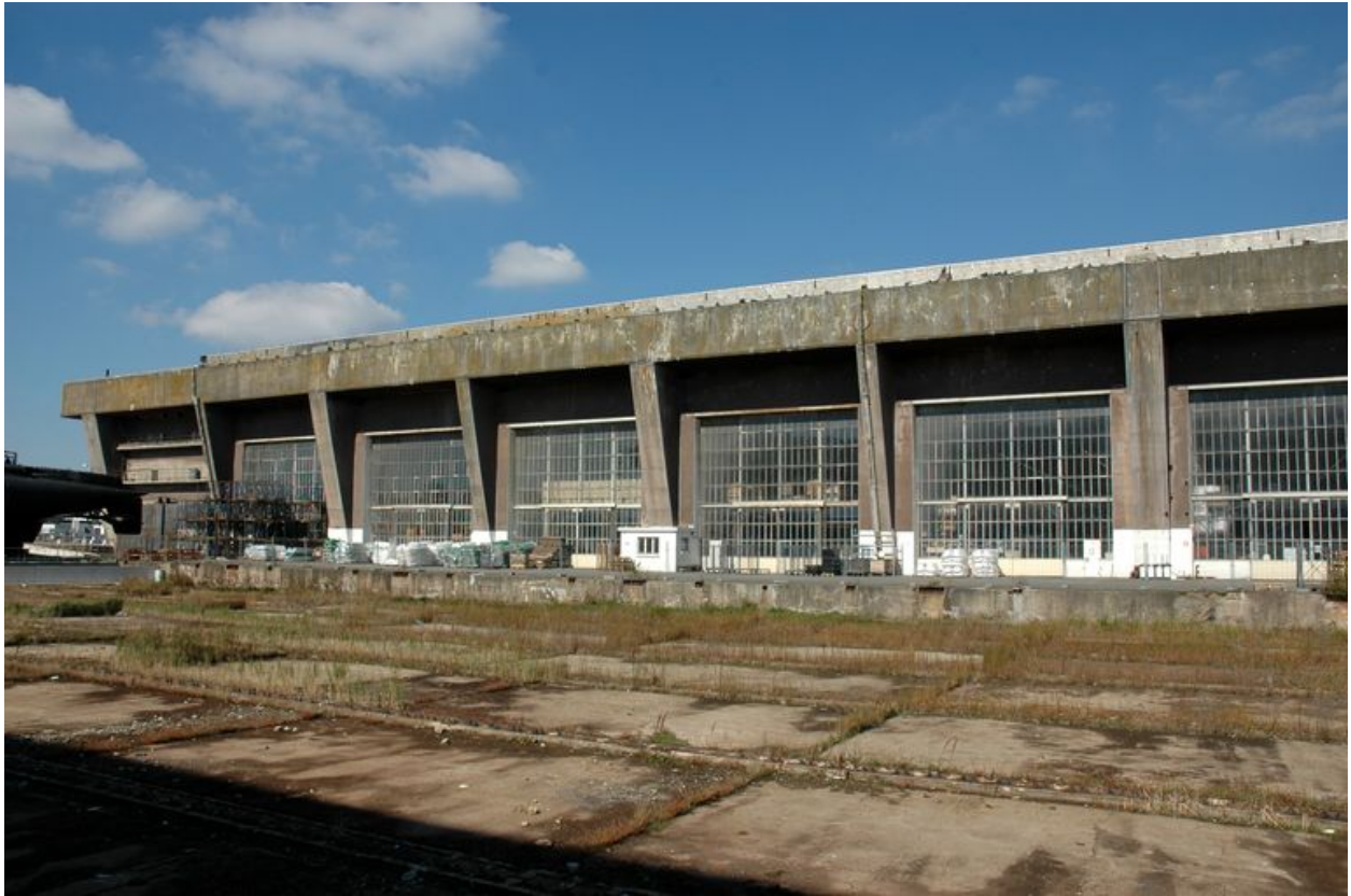
Vue du front avant du bunker "KII" : contreforts et dalle de couverture (2005). L'édifice compte huit alvéoles dont celle servant d'abri au chariot de translation des sous-marins (abri surmonté par la caserne dites des 1000)
