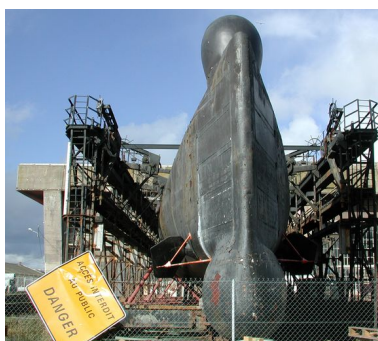
Vue du sous-marin Flore en 2002 (S645, classe Daphné, lancé en 1960) sur le plateau de translation d'origine allemande doté de deux berceaux. Le sous-marin Flore y repose à sec depuis le 12 juillet 1995 Phot. Guillaume Lécueillier IVR53_20055603497NUCA
