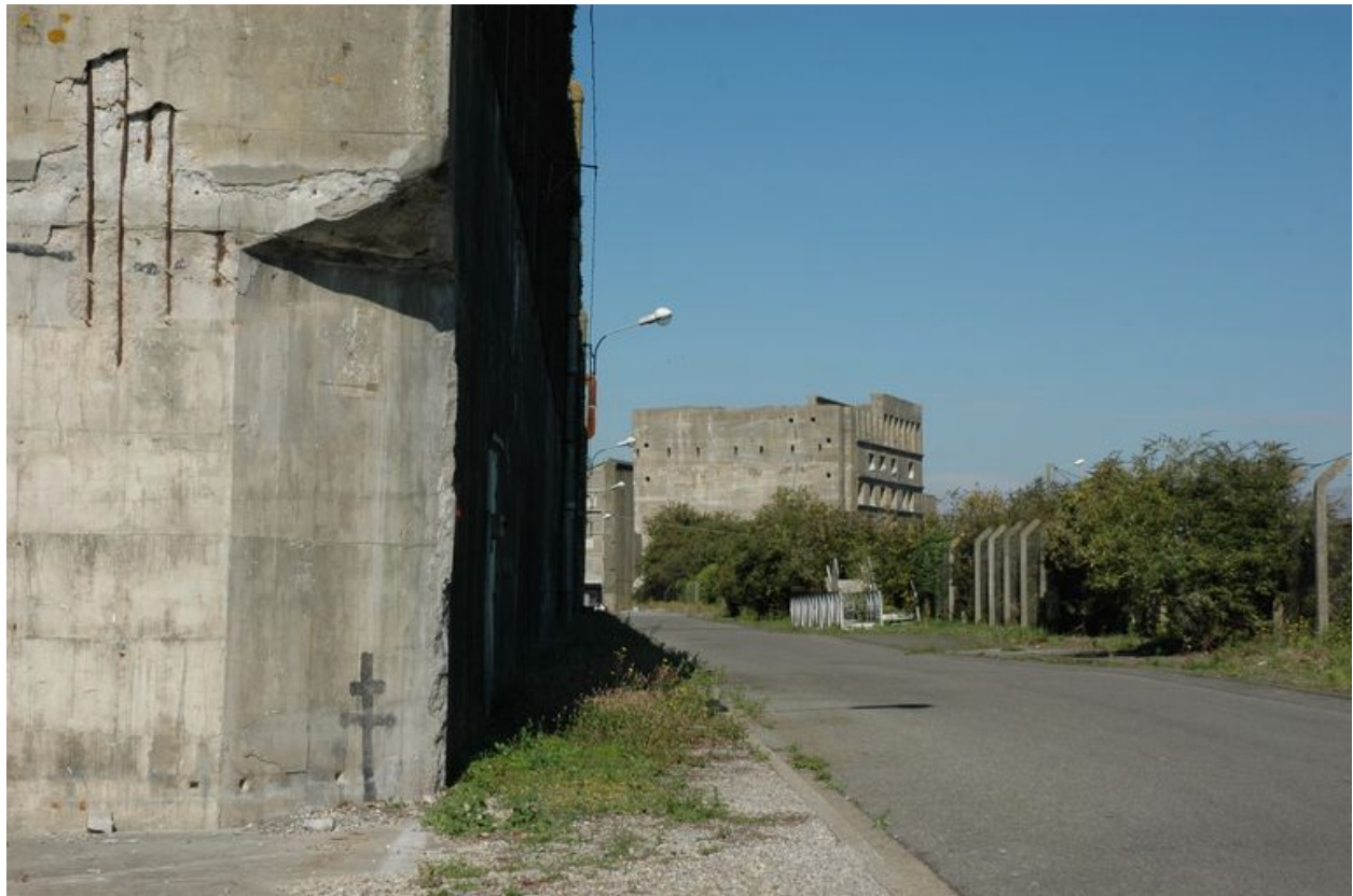
Vue de l'élévation nord, front arrière (2005). A l'arrière-plan, le bunker "KIV" (inachevé). Au premier plan, angle sud-est à pan coupé du bunker "KIII"
