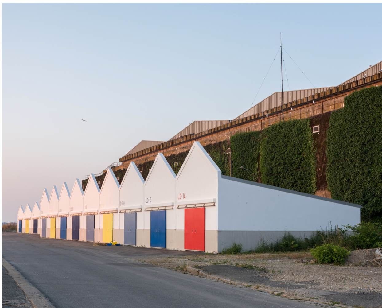
Vue générale des remises de pêcheur dites box situées au nord du bunker KIII
