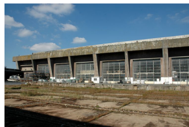
Vue du front avant du bunker "KII" : contreforts et dalle de couverture (2005). L'édifice compte huit alvéoles dont celle servant d'abri au chariot de translation des sous-marins (abri surmonté par la caserne dites des 1000) Phot. Guillaume Lécueillier IVR53_20055603559NUCA
