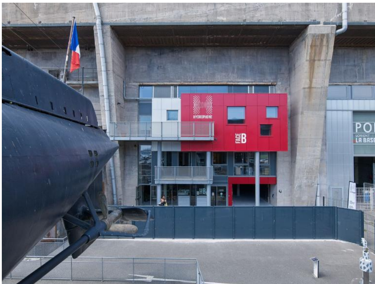
Vue de l'entrée ouest de l'alvéole "K6" du bunker "KII" abritant l'Hydrophone (2021). Cet équipement est dédié aux musiques actuelles)
