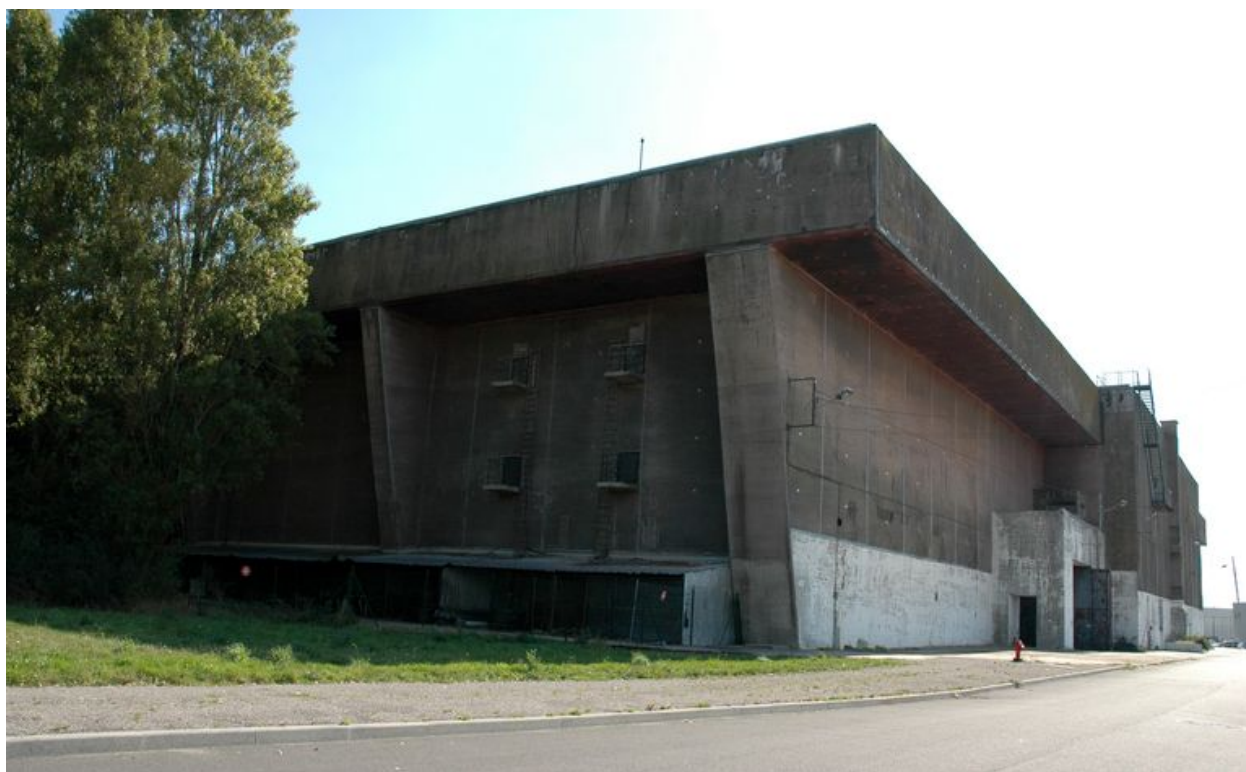
Vue de l'angle ouest du bunker "KII" : contreforts et dalle de couverture (2005). Les quatres entrées/sorties correspondent à la caserne dite des 1000
