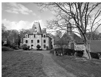
Château, logis et chapelle : vue générale sud (état en 1983) Phot. Guy Artur, Phot. Norbert Lambart IVR53_19835600480X
