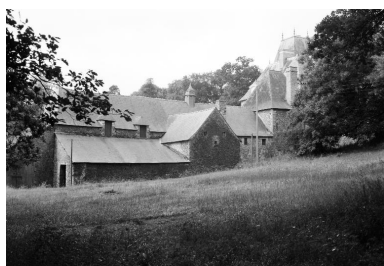
Château, aile nord : élévation nord (état en 1983) Phot. Jean-Pierre Ducouret IVR53_19835600191X
