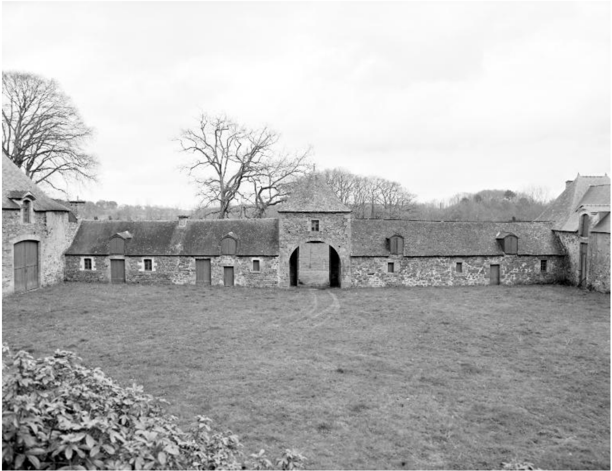
Château, aile est : élévation ouest (état en 1983)
