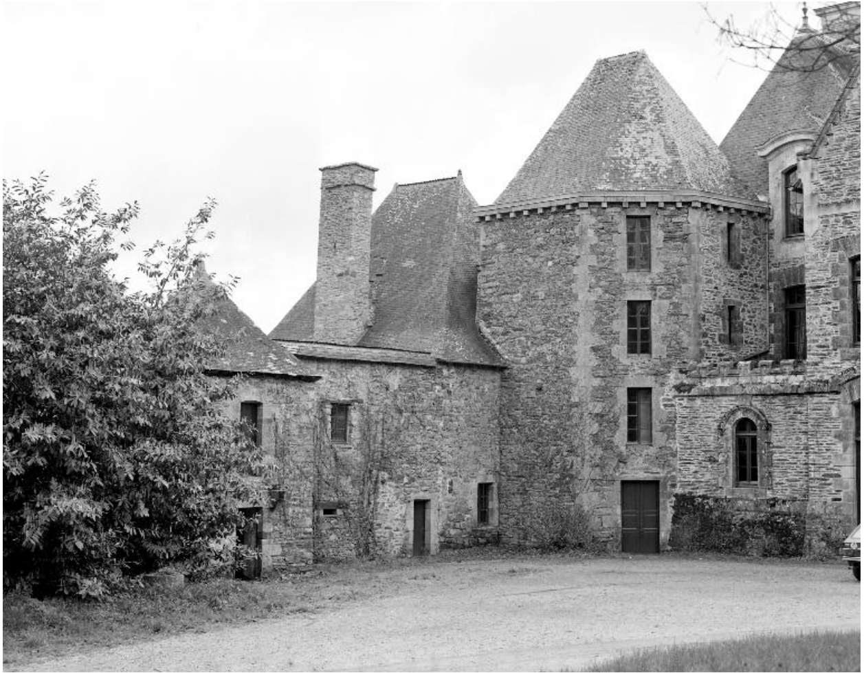
Château, logis, élévation nord : la partie gauche (état en 1983)
