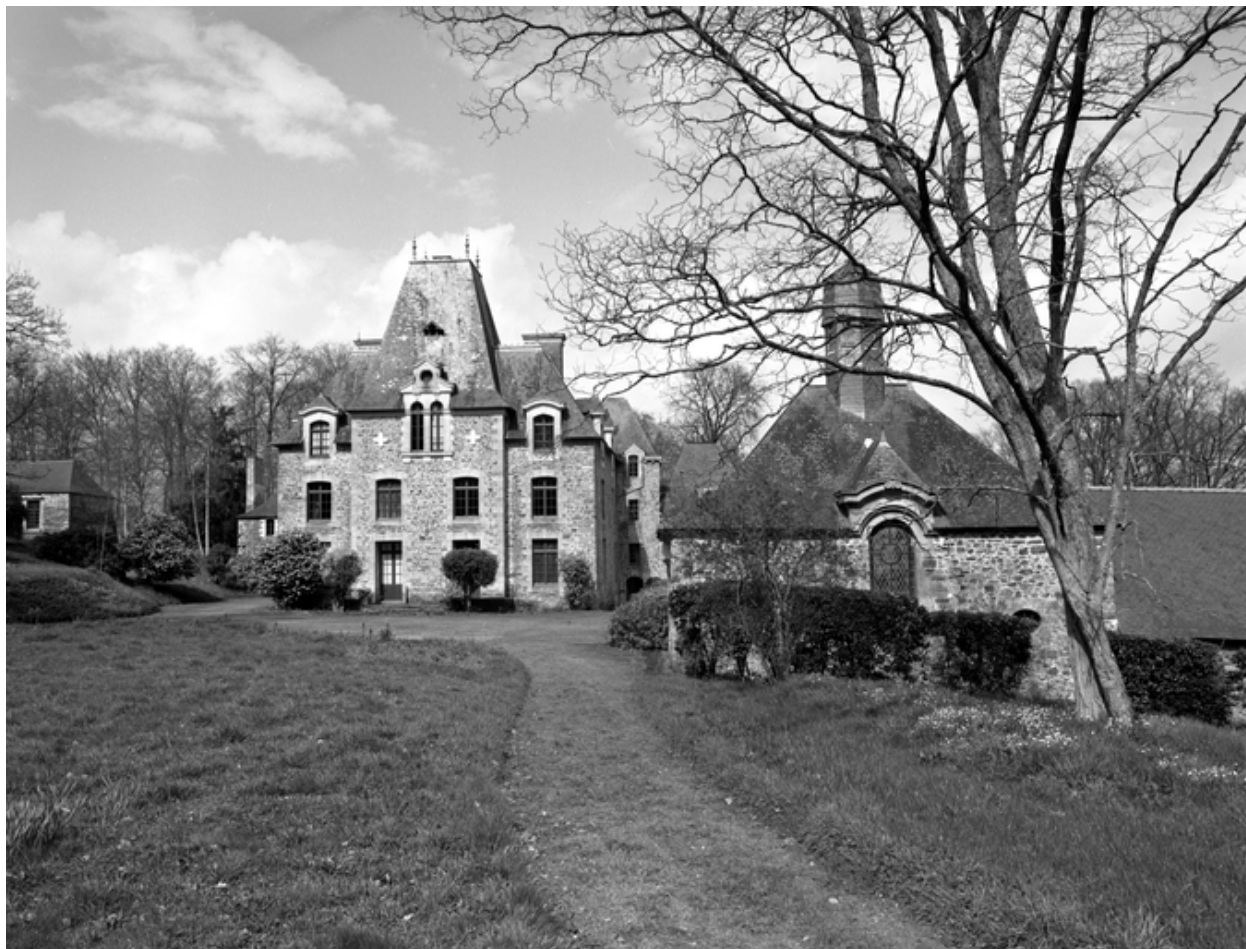
Château, logis et chapelle : vue générale sud (état en 1983)
