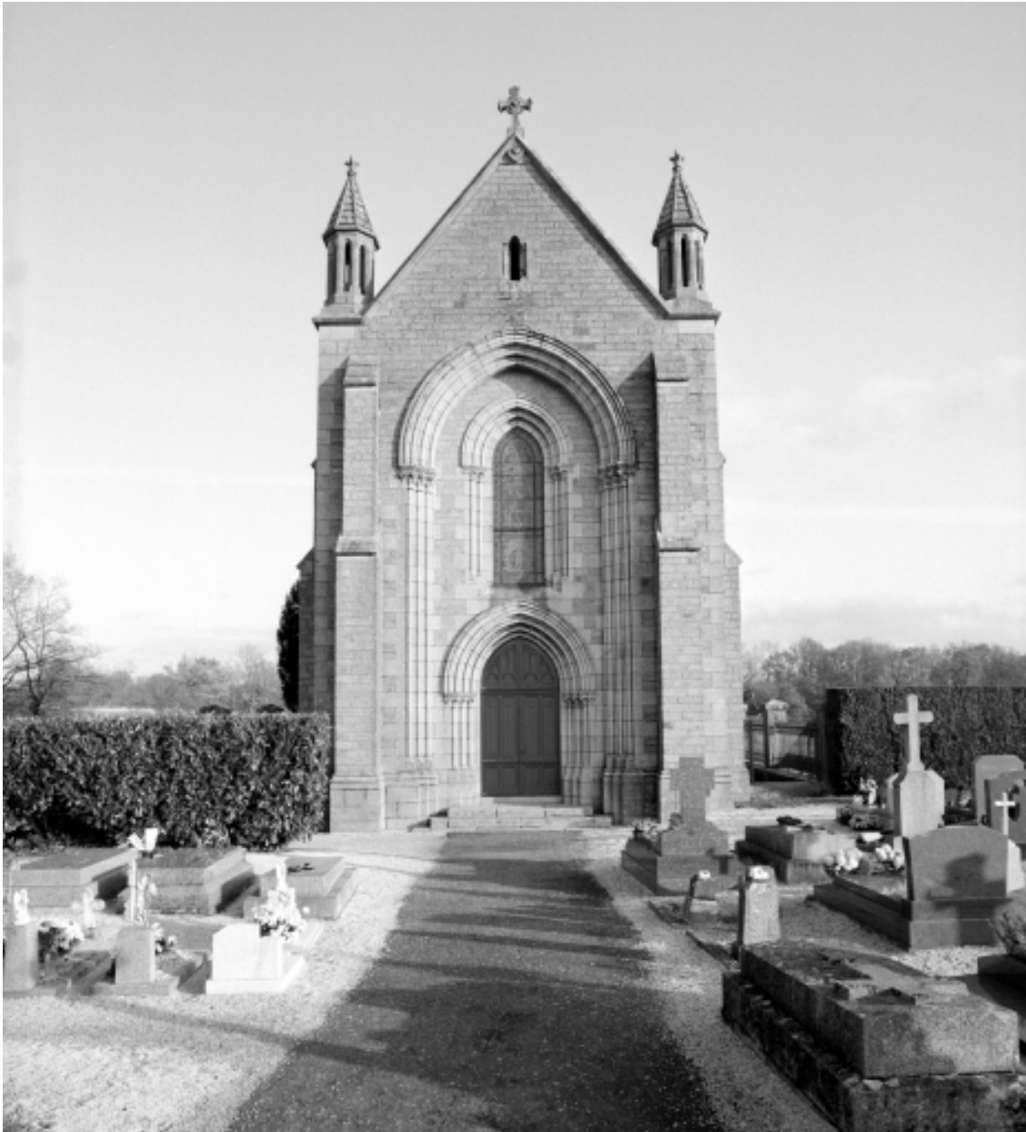
Elévation Ouest : vue générale
