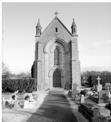
Élévation Ouest : vue générale Phot. Bernard Bègne, Phot. M. Loyon IVR53_19923500945X
