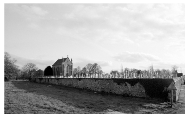
Élévation Nord-Ouest : vue de situation Phot. Bernard Bègne, Phot. M. Loyon IVR53_19923500944X
