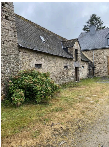
Dépendance, vue nord-est Phot. Baptiste Oligo IVR53_20255610606NUCA
