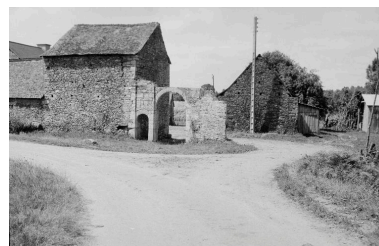
Manoir : vue rapprochée (état en 1969) Phot. Jean-Pierre Ducouret IVR53_20115601328Z
