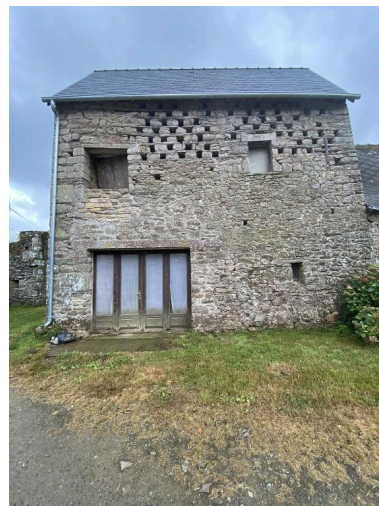
Vue nord, présence de plusieurs rangées de boulines Phot. Baptiste Oligo IVR53_20255610607NUCA
