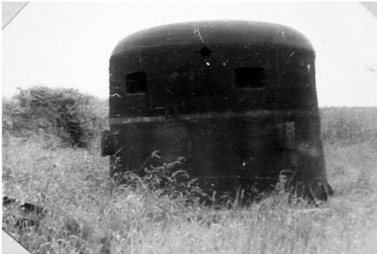
Vue d'une cloche blindée pour deux 2 mitrailleuses non mise en place au Portzic, n° 114, rapport Pinczon du Sel. Livre IV, vers 1947, Service Historique de la Marine, Brest
