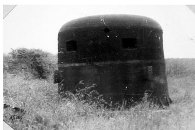
Vue d'une cloche blindée pour deux mitrailleuses non mise en place au Portzic, n° 114, rapport Pinczon
