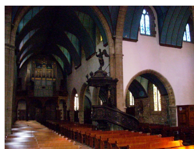
Crozon, église paroissiale Saint-Pierre : vue transversale nord-ouest Phot. Gwénaél Fauchille IVR53_20082905856NUCA
