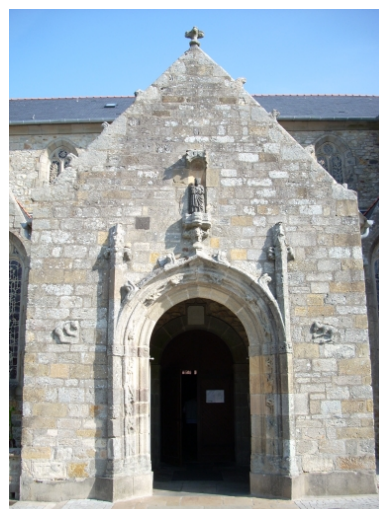
Crozon, église paroissiale Saint-Pierre : porche sud Phot. Gwénaél Fauchille IVR53_20082905853NUCA
