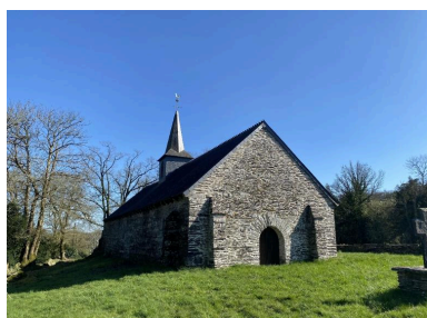
Vue nord-ouest Phot. Baptiste Oligo IVR53_20265610324NUCA
