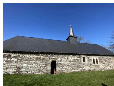
Vue sud Phot. Baptiste Oligo IVR53_20265610329NUCA
