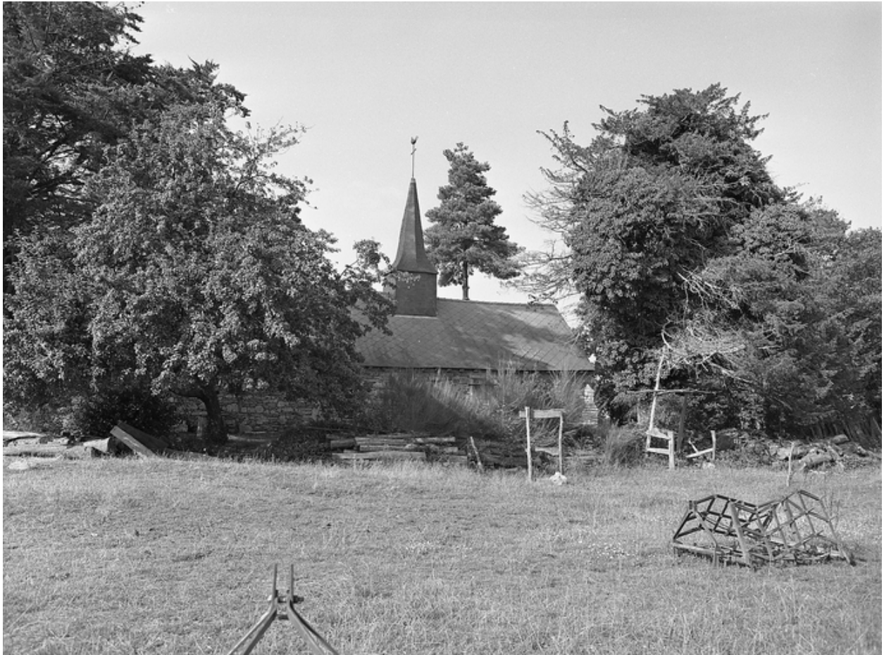
Vue générale sud.
