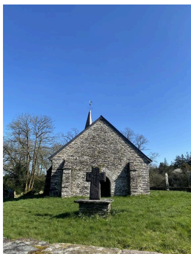
Vue ouest Phot. Baptiste Oligo IVR53_20265610323NUCA
