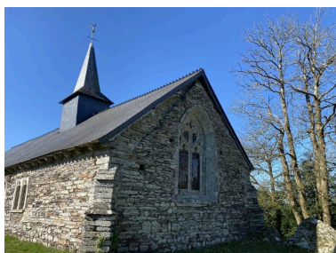
Vue sud-est Phot. Baptiste Oligo IVR53_20265610330NUCA
