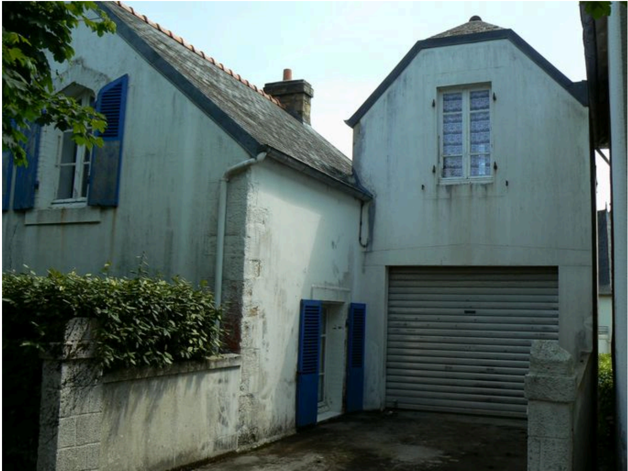
Vue arrière de la villa Ker Eulec'h
