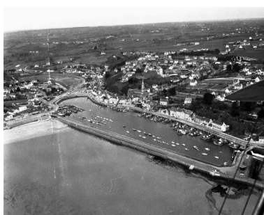
Vue aérienne du port de Binic vers 1970 : le bassin à flot (Fonds Joël, AD 22) Phot. Guy Prigent, Autr. Joël Jouas Poutrel IVR53_20072206195NUCB
