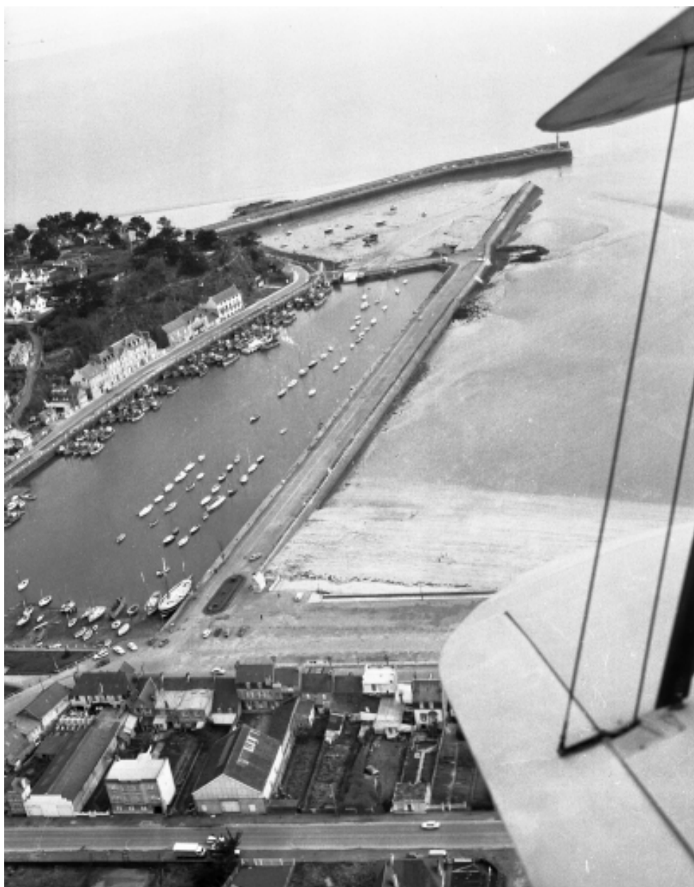
Vue aérienne du port de Binic vers 1970 (Fonds Joël, AD 22)
