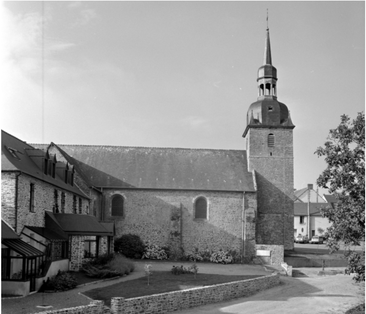
Elévation nord, partie ouest : vue générale
