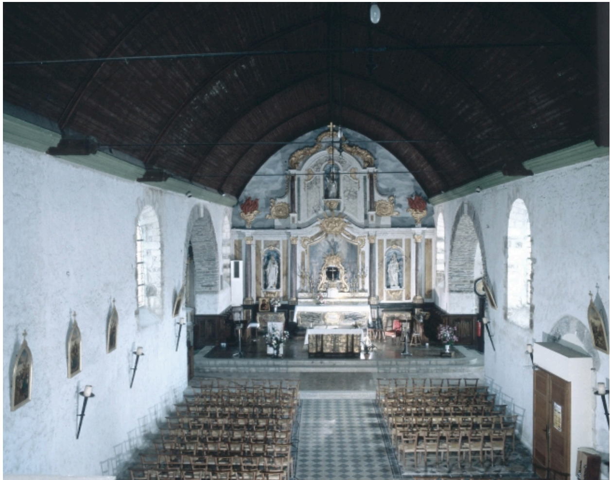
Intérieur : vue générale vers le chœur.
