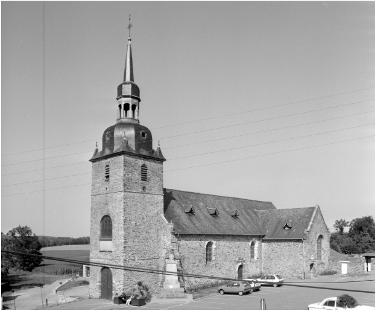
Elévation sud-ouest : vue générale
