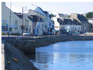
Vue générale du front portuaire Kléber Phot. Guillaume Marie IVR53_20062908332NUCA
