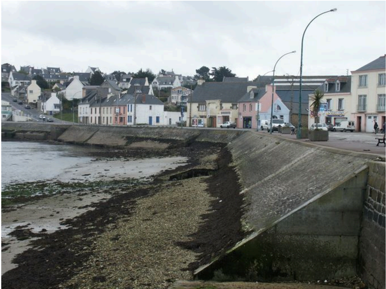
Vue du front portuaire Kléber vers le sud-est
