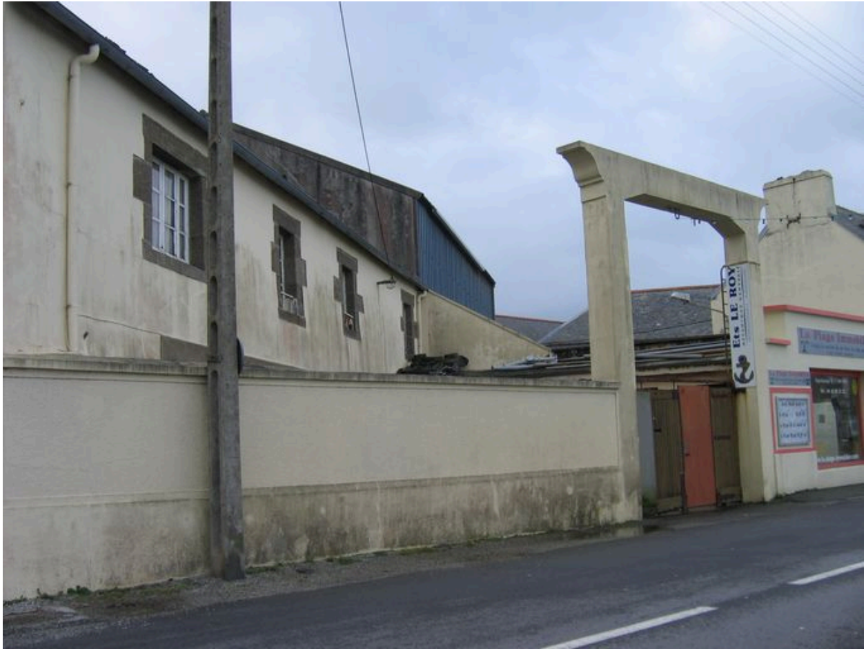
Entreprise Le Roy (ancien Grand Magasin)
