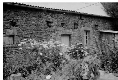
Ferme 43 : chaque about de poutre qui soutient le plancher du grenier est protégé de l'eau par une plaque de schiste, appelé larmier (état en 1969)
