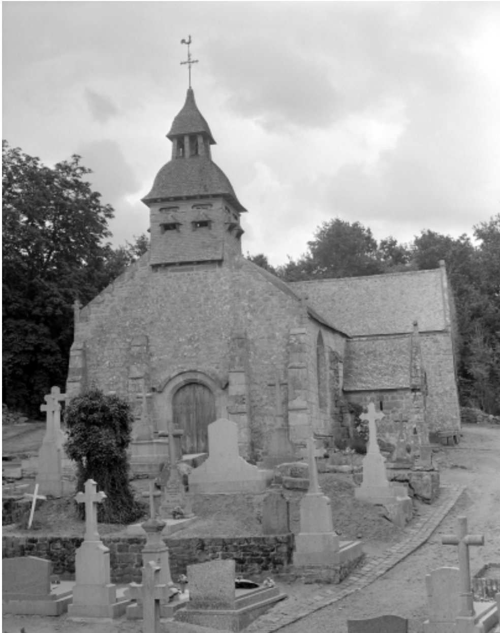
Elévation Ouest : vue générale
