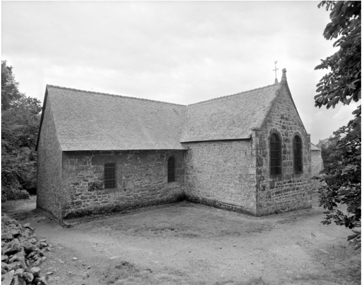
Elévation Nord-Est : vue générale
