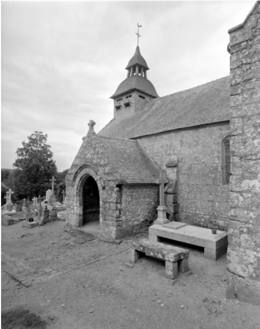
Elévation Sud, porche : vue générale
