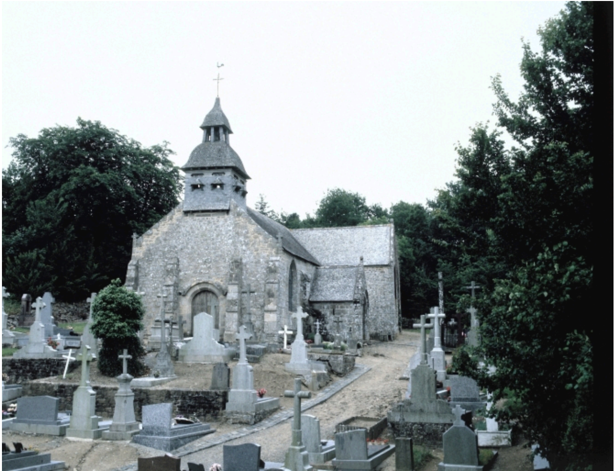
Elévation Ouest : vue générale
