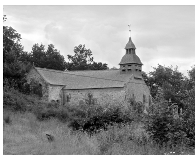
Elévation Nord : vue générale Phot. Guy Artur, Phot. Norbert Lambart IVR53_19943501307X
