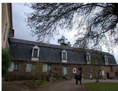
Métairie, aile Est Phot. Guillaume Lécueillier IVR53_20033515344NUCA
