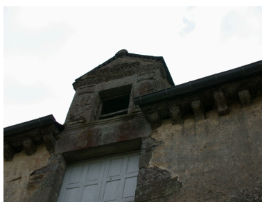
Communs, détail d'une lucarne au décor renaissance Phot. Guillaume Lécueillier IVR53_20033515338NUCA
