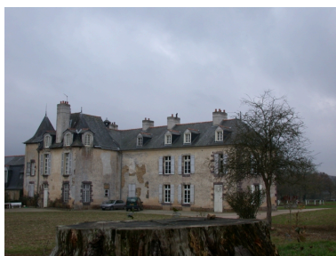
Vue générale du château, façade arrière est, prise de 3/4 Phot. Guillaume Lécueillier IVR53_20033515329NUCA
