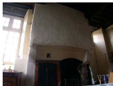
Pavillon accolé à la façade est, vue intérieure de la cuisine, cheminée Phot. Guillaume Lécueillier IVR53_20033515330NUCA
