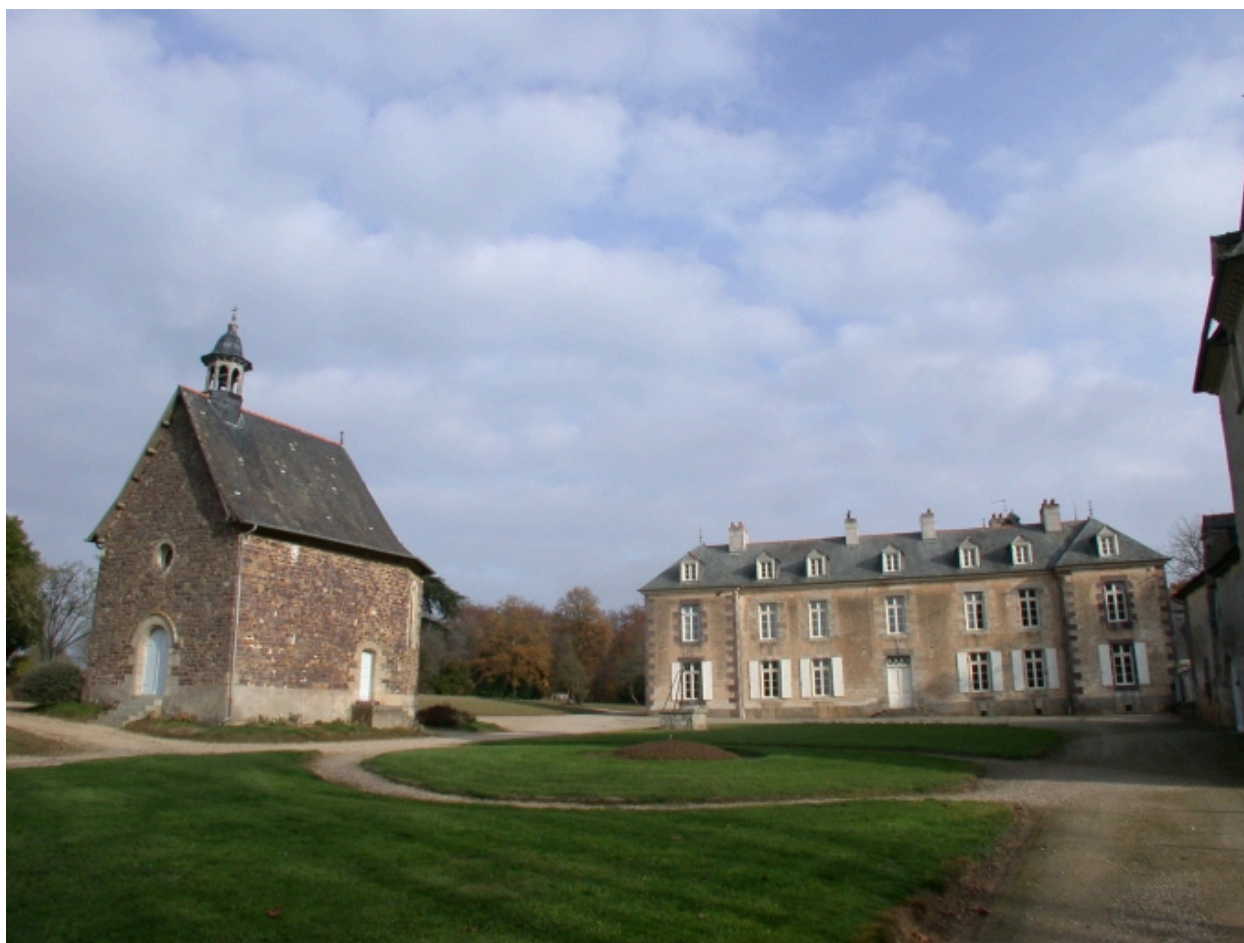
Vue générale, façade antérieure du château et chapelle
