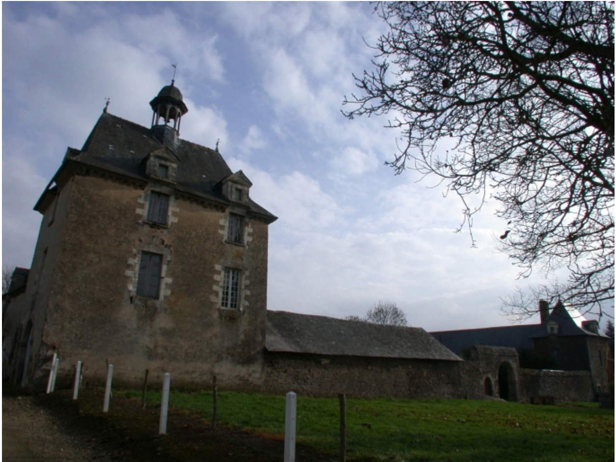
Métairie, portail d'entrée de la cour fermée
