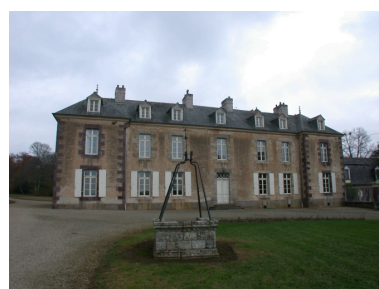
Vue générale du château, façade antérieure Phot. Guillaume Lécueillier IVR53_20033515327NUCA
