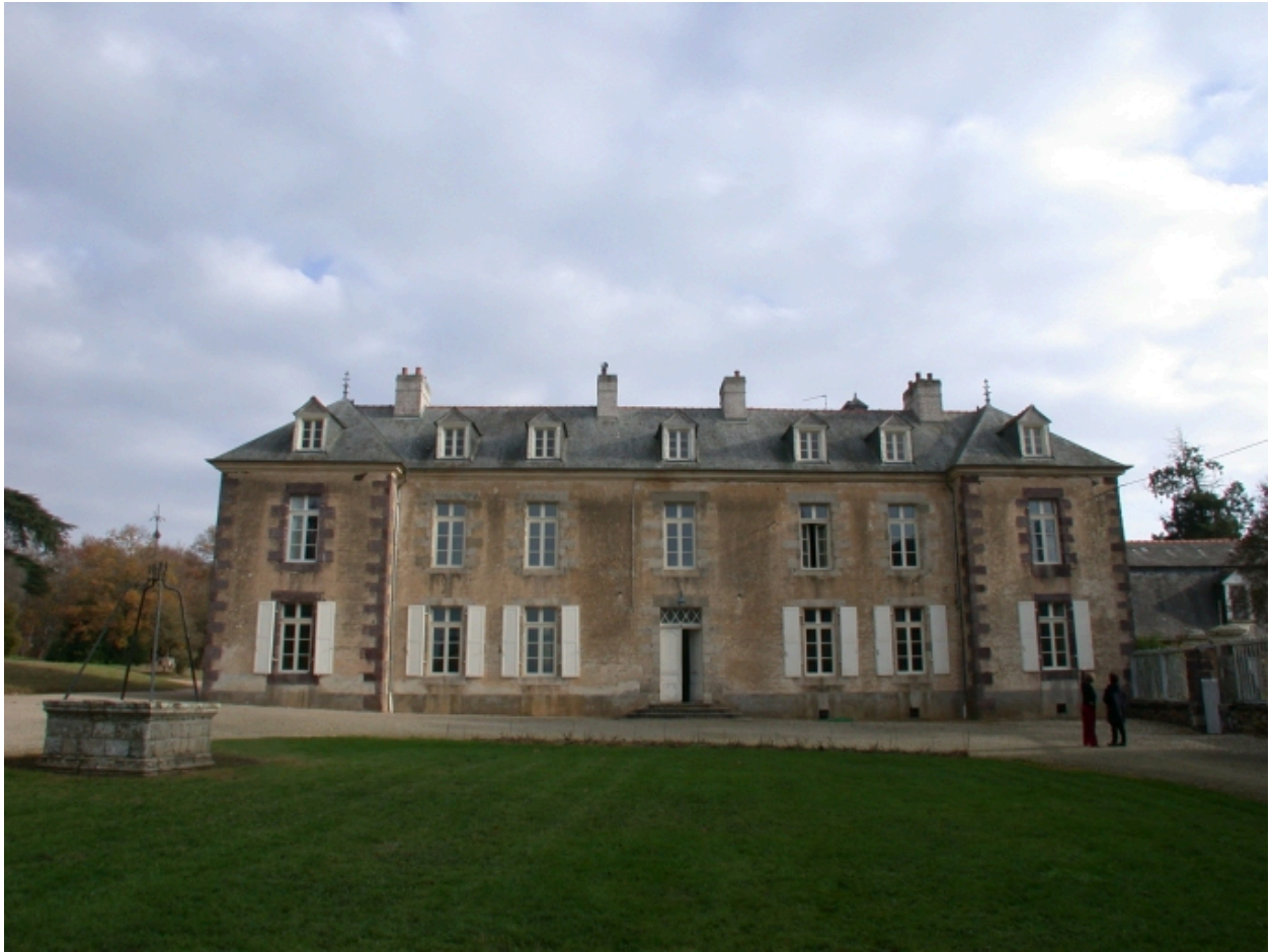
Vue générale du château, façade antérieure
