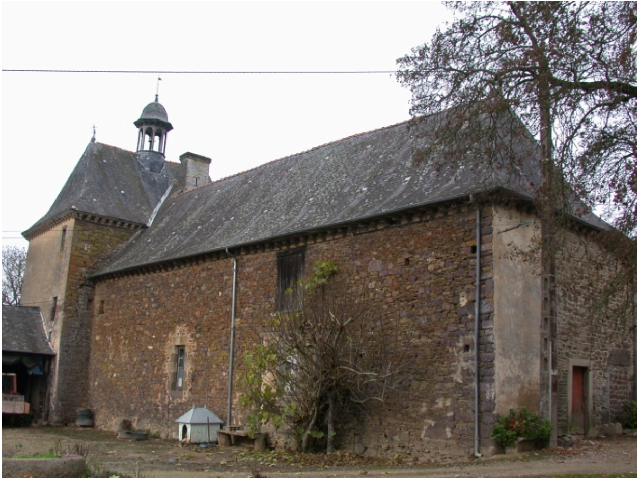
Communs et pavillon nord ouest, vue prise de la cour de la métairie
