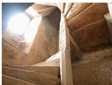
Pavillon nord ouest, détail de l'escalier en bois dans œuvre Phot. Guillaume Lécueillier IVR53_20033515340NUCA
