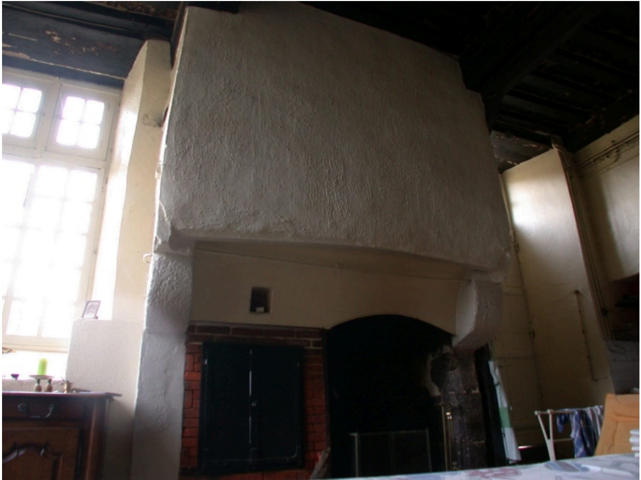
Pavillon accolé à la façade est, vue intérieure de la cuisine, cheminée
