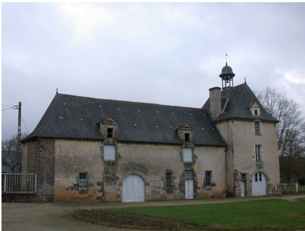
Communs et pavillon nord Ouest, vue d'ensemble prise de la cour
