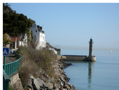
Vue des enrochements et du mur de soutènement en amont du phare Phot. Guy Prigent IVR53_20082213232NUCA
