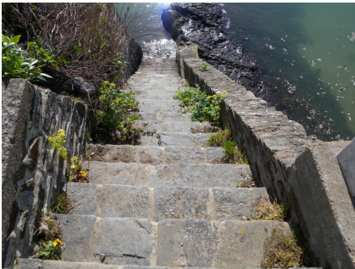
Vue des escaliers en pierre de taille (granite) qui desservent la grève d'échouage
