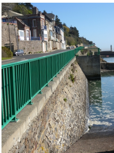
Vue des murs de soutènement et de la rampe Phot. Guy Prigent IVR53_20082213235NUCA
