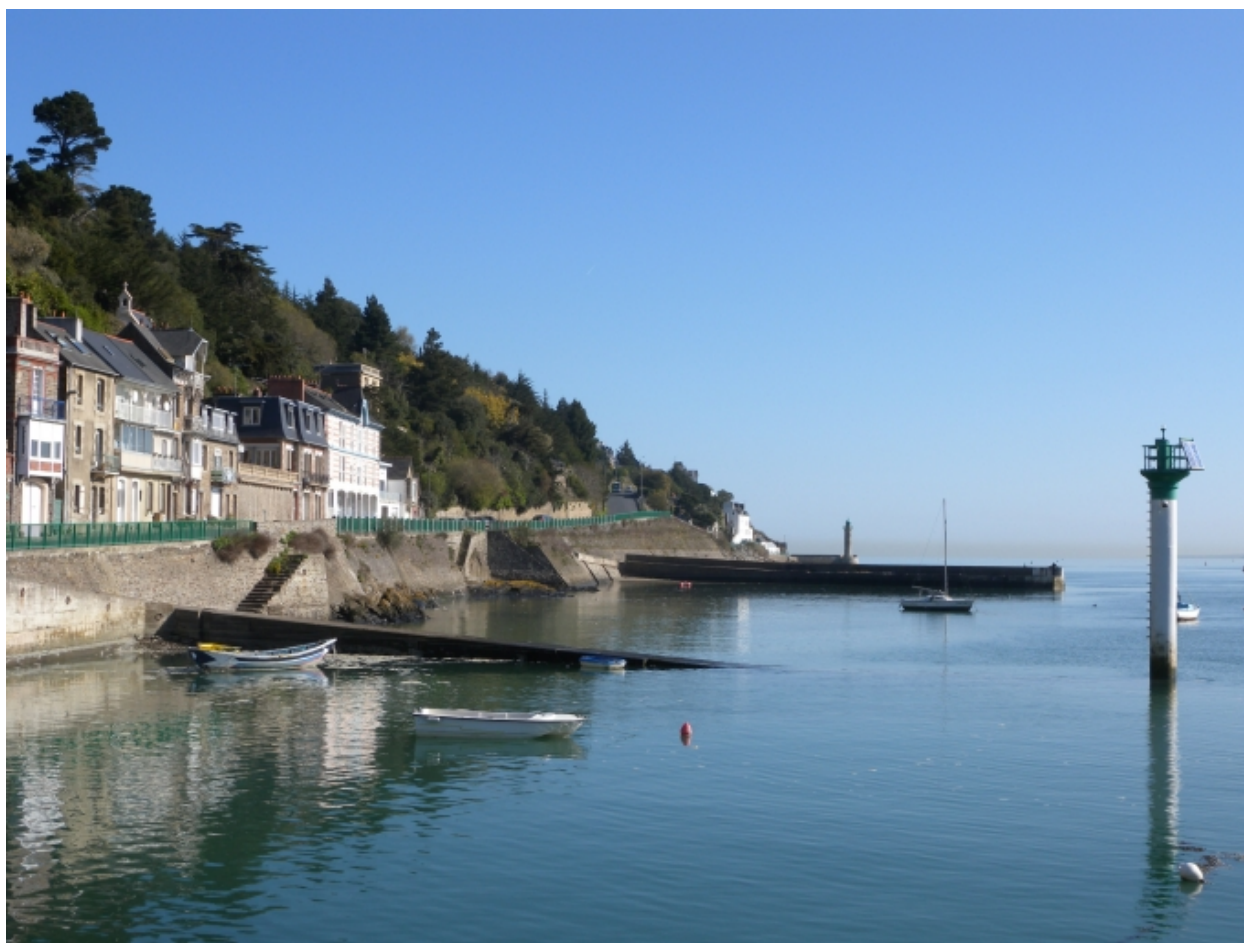
Vue des murs de soutènement, de la jetée de la Douane et du môle à marée haute
