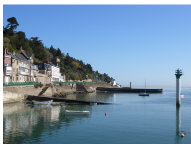
Vue des murs de soutènement, de la jetée de la Douane et du môle à marée haute Phot. Guy Prigent IVR53_20082213234NUCA
