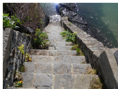
Vue des escaliers en pierre de taille (granite) qui desservent la grève d'échouage Phot. Guy Prigent IVR53_20082213236NUCA
