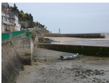
Vue des murs de soutènement, de la jetée de la Douane et du môle à marée basse Phot. Guy Prigent IVR53_20082213233NUCA
