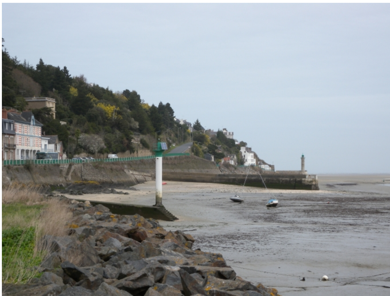
Vue générale des ouvrages portuaires
