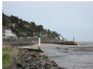
Vue générale des ouvrages portuaires Phot. Guy Prigent IVR53_20082213231NUCA
