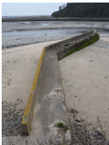
Vue du môle Sous-la-Tour Phot. Guy Prigent IVR53_20082213230NUCA
